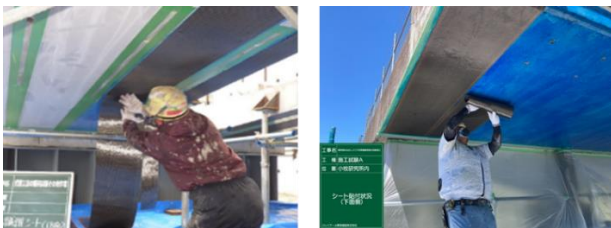
図11 新工法試験施工状況
