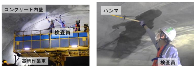
写真1 現行のトンネル打音検査の状況
