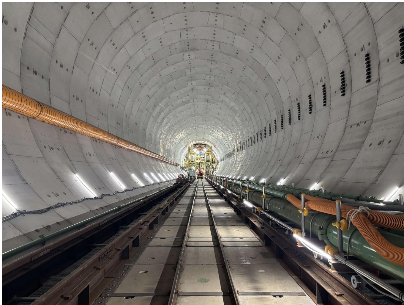
○坂下西工区の坑内の状況(2024年10月15日撮影)
