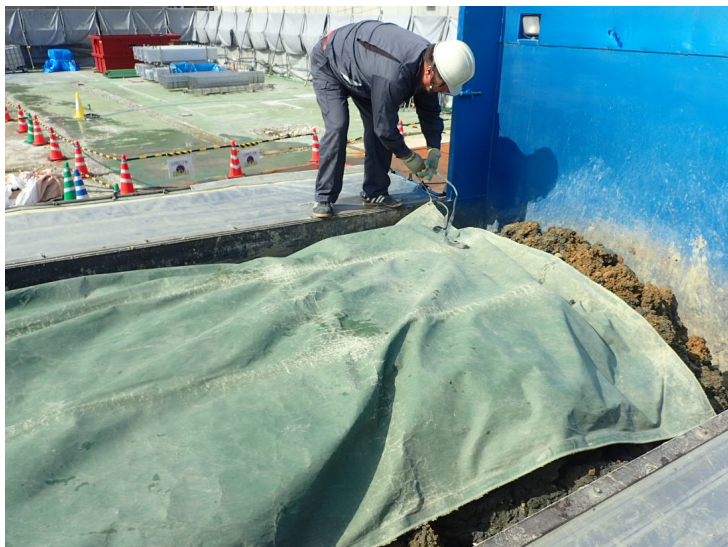
荷台への防じんシートの設置
