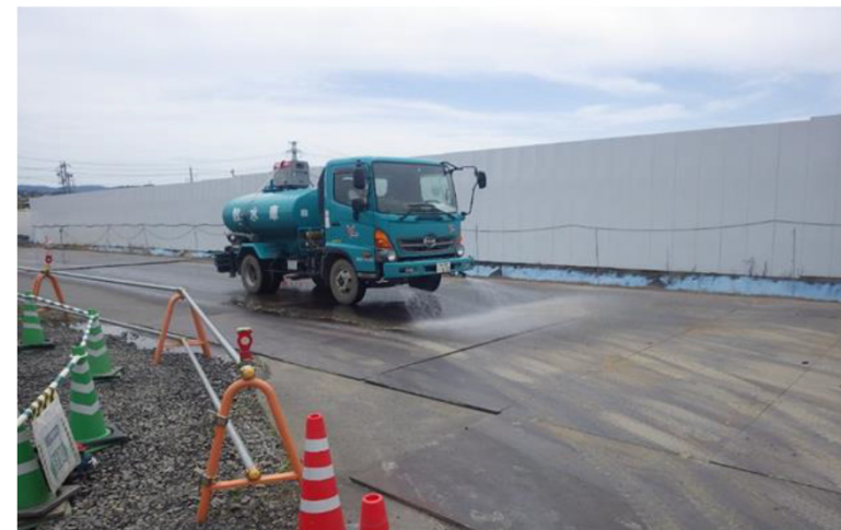
工事施工ヤード等の清掃、散水
