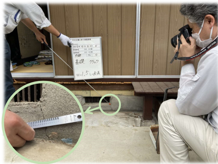
外壁・基礎調査
