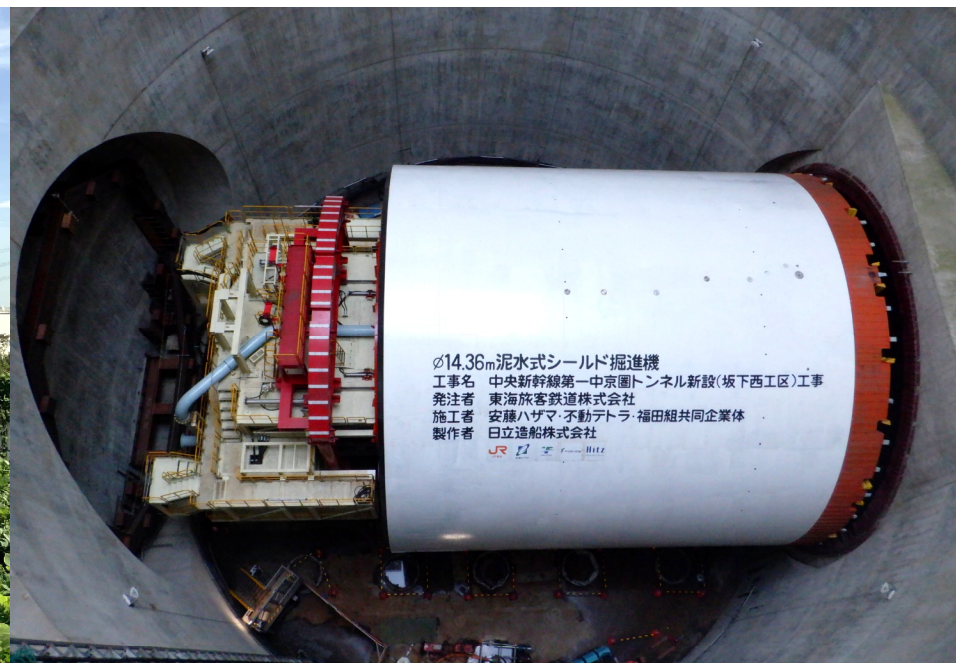
シールド機の組立が完了(非常口内)
