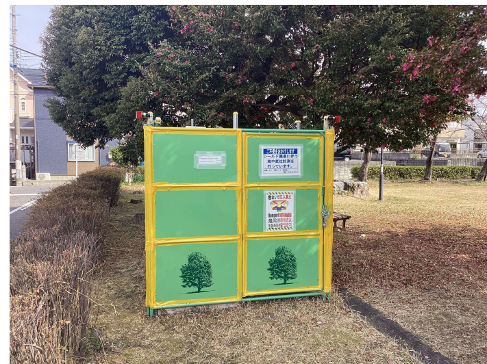
「地中変位計」の設置状況
