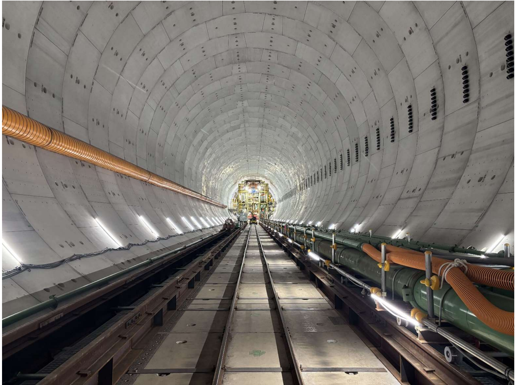
坂下西工区のトンネル内の状況(2024年10月15日 撮影)
