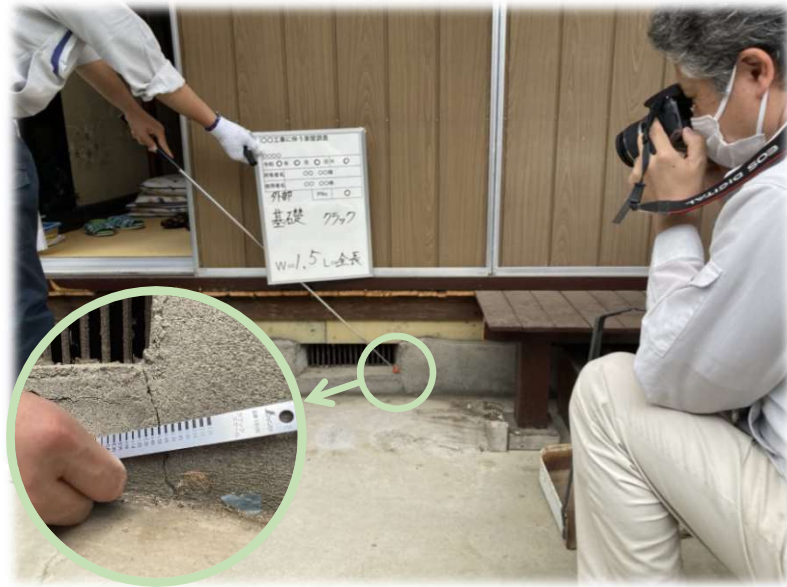
外壁・基礎調査
