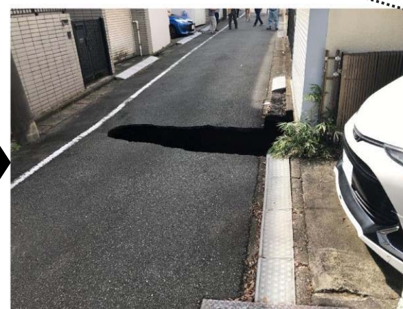
10月18日12:30(陥没発生)
