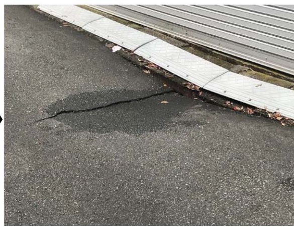
10月18日11:50(舗装亀裂)
