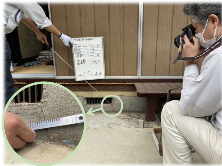
外壁・基礎調査
