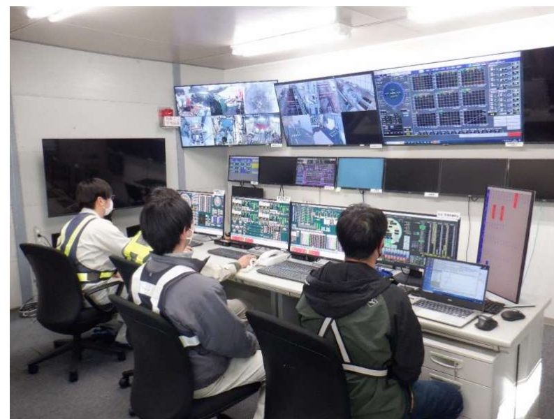
泥土圧の確認状況
