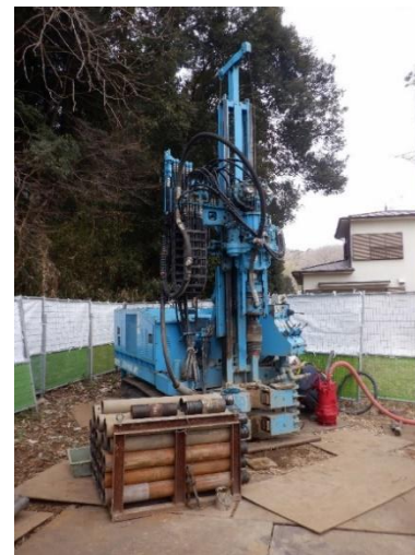
追加ボーリング (小山田緑地)
