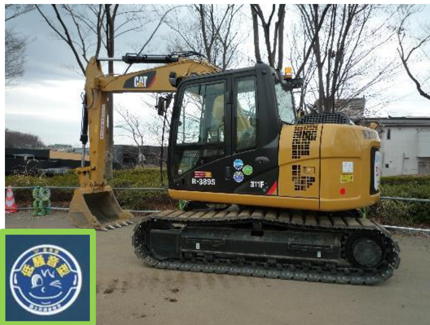
低騒音型の建設機械の採用
