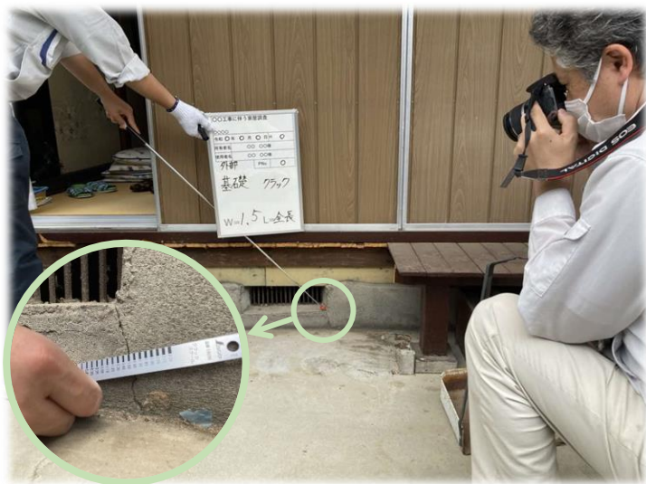
外壁・基礎調査
