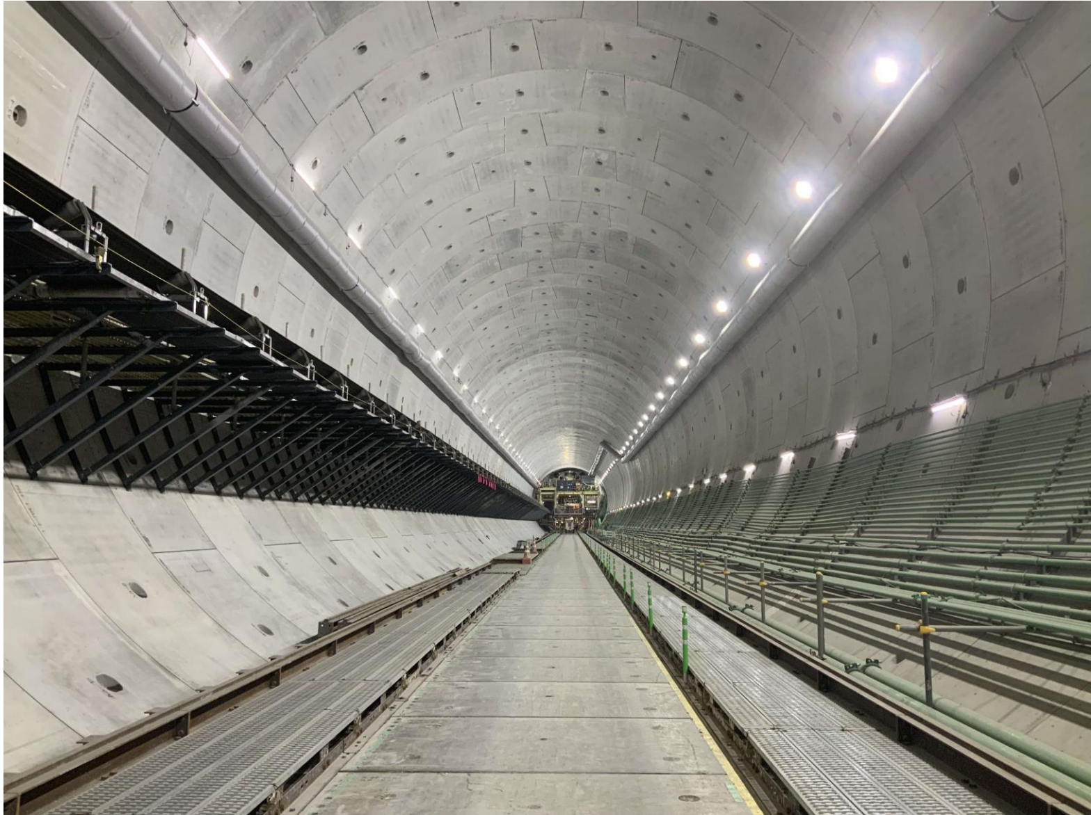
小野路工区のトンネル内の状況(2025年4月17日 撮影)
