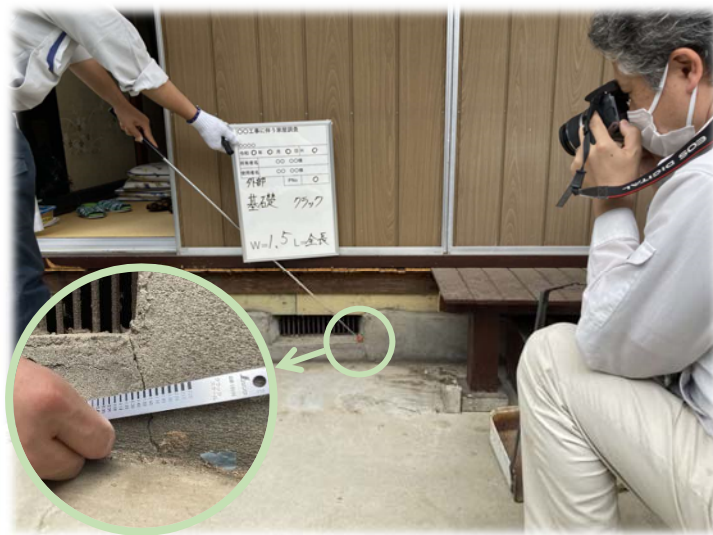
外壁・基礎調査
