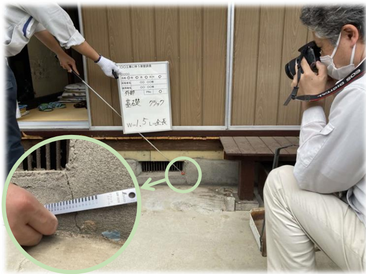
外壁・基礎調査
