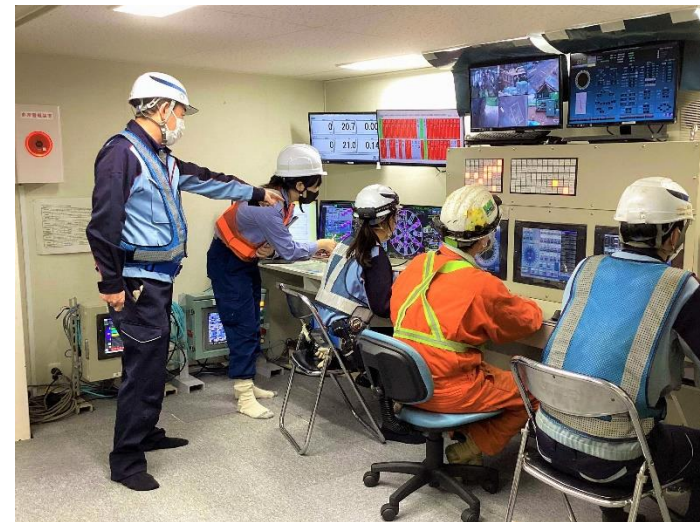
泥土圧の確認状況
