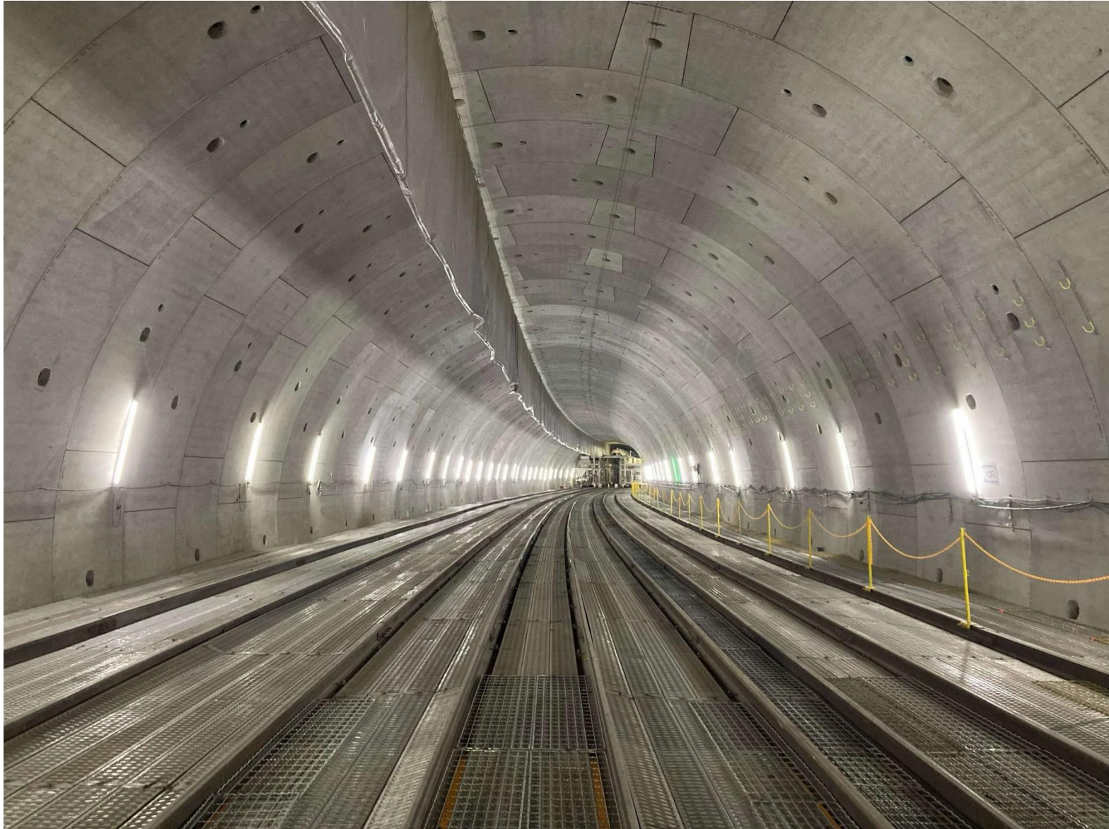
北品川工区のトンネル内の状況(2024年11月19日 撮影)
