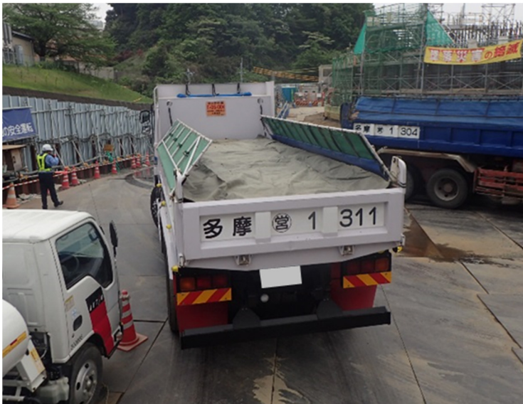
荷台への防じんシートの設置
