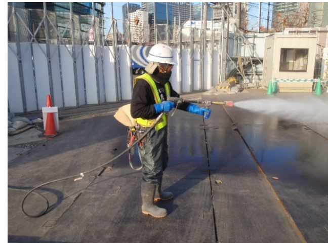
工事施工ヤード等の清掃、散水
