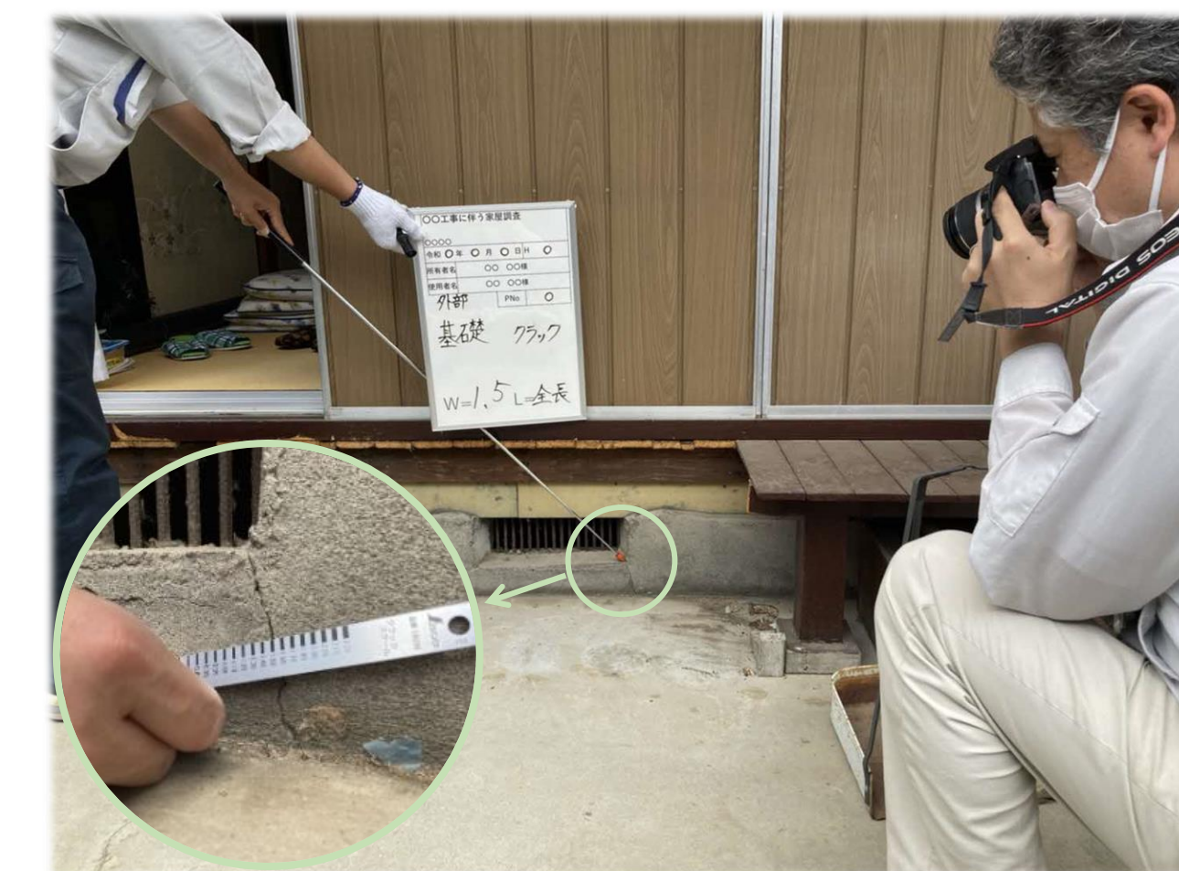
外壁・基礎調査
