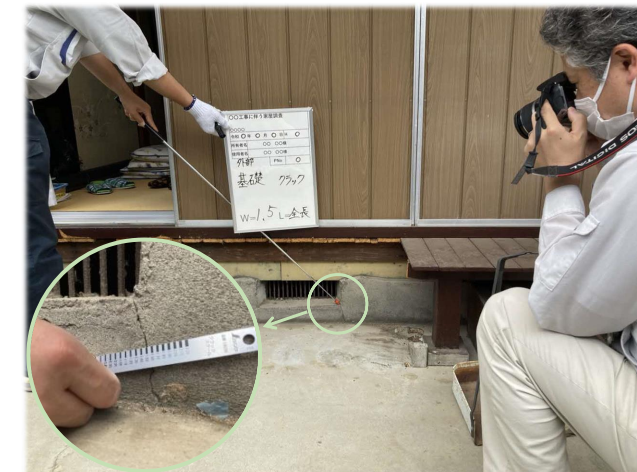
外壁・基礎調査
