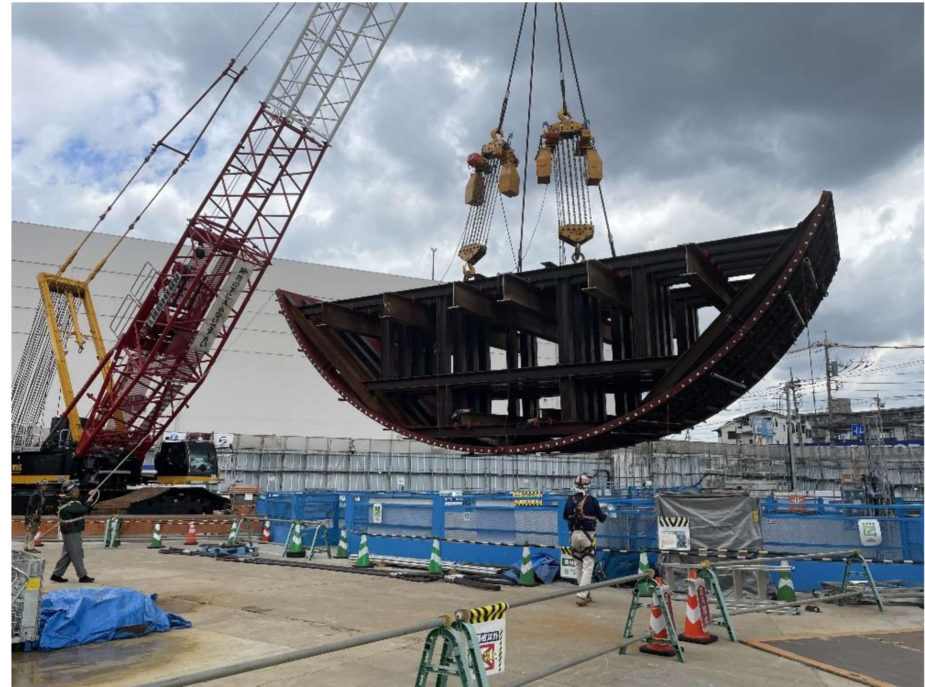
大型クレーンでの設備投入イメージ (写真：犬蔵非常口新設工事)
