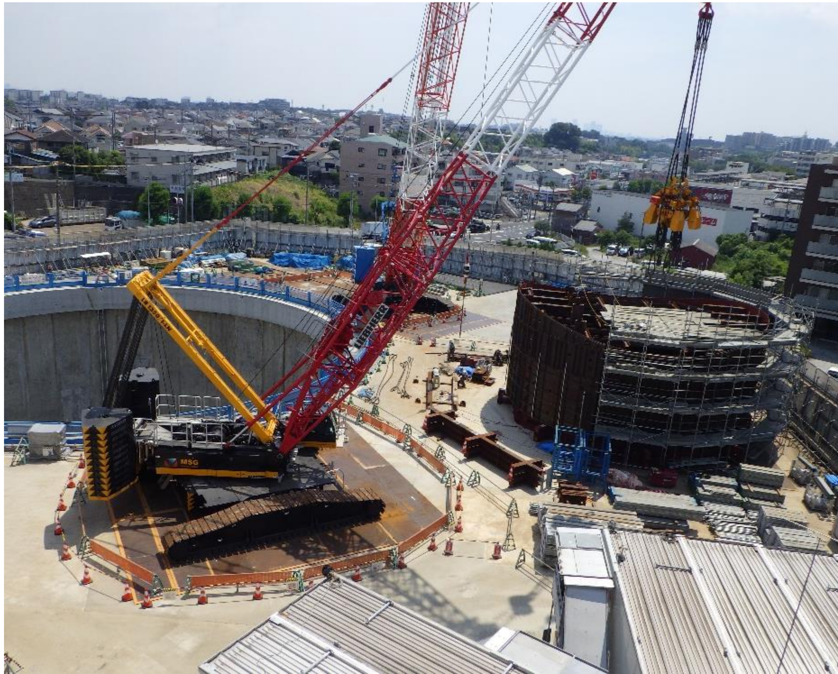
大型クレーンの使用状況イメージ (写真：犬蔵非常口新設工事)
