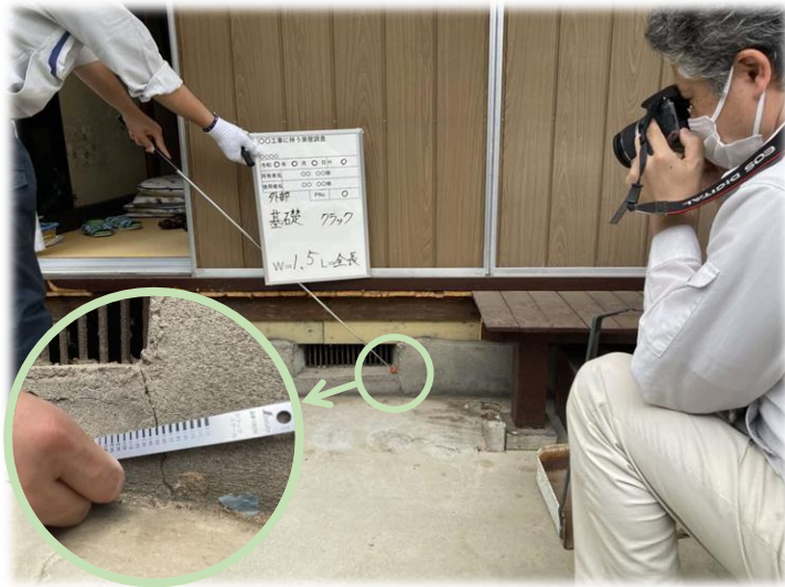
外壁・基礎調査
