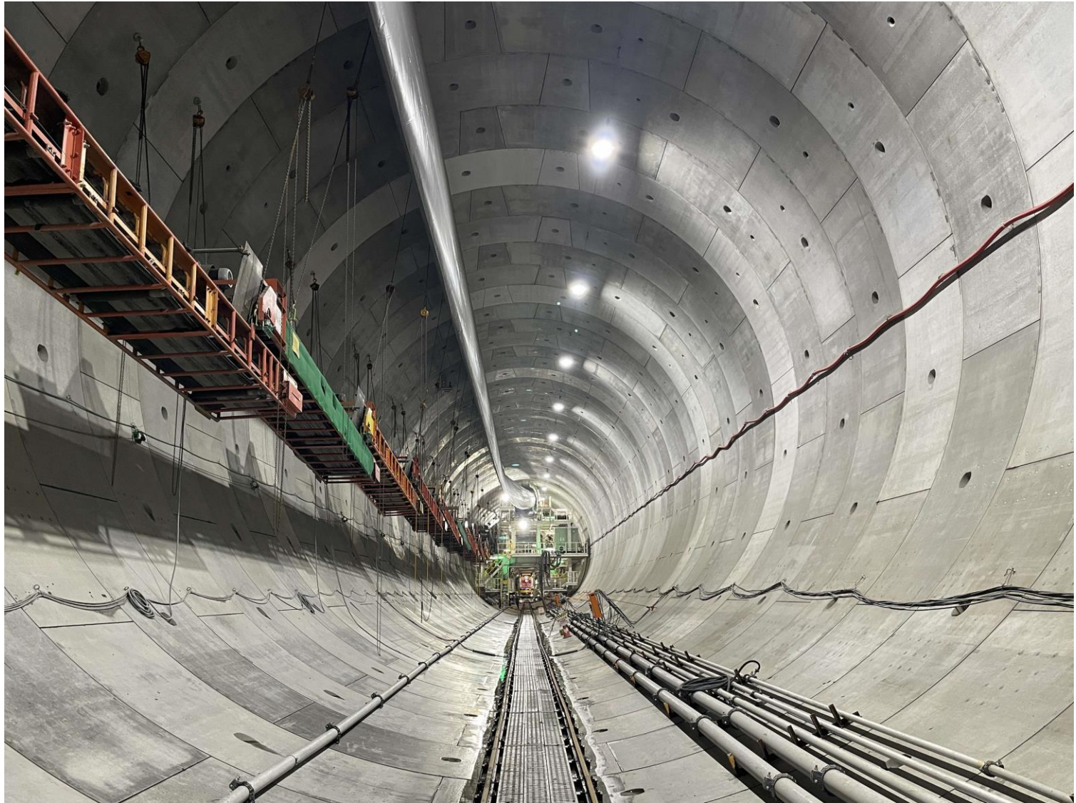
梶ヶ谷工区の坑内の状況(2024年2月22日 撮影)
