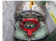
シールド機組立
