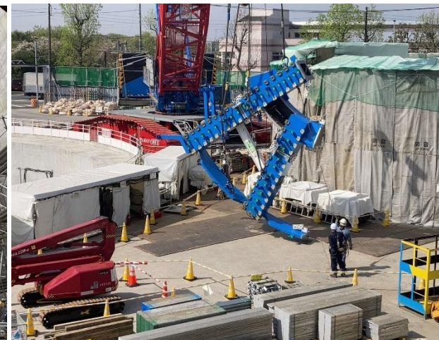
カッターヘッドの分割投入
