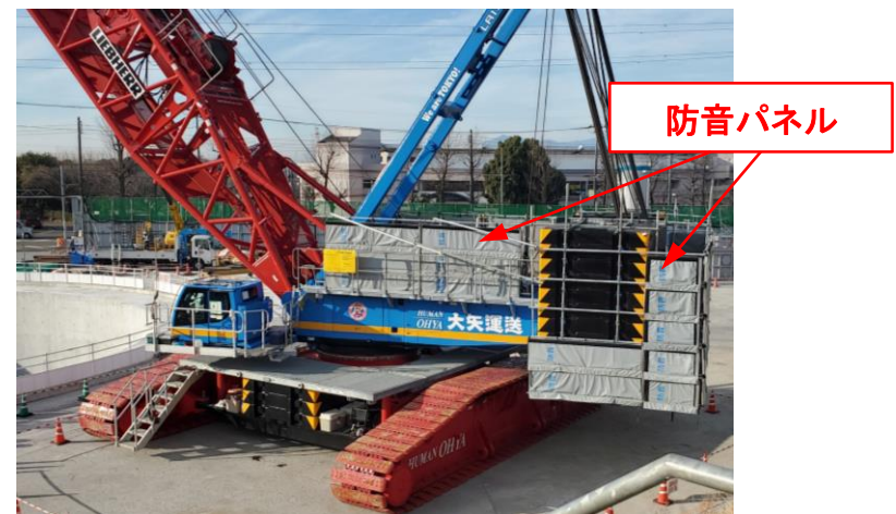
建設機械のエンジン部に防音パネルを設置
