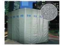
写真② 注入プラント周辺に防音シートを設置
