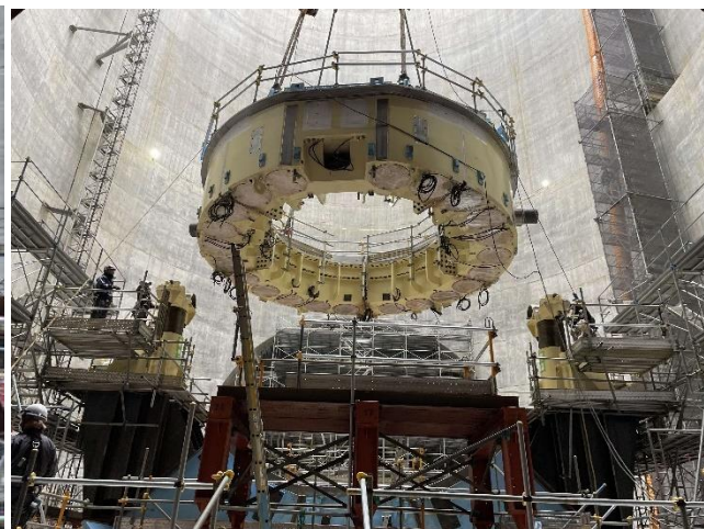
カッターヘッド駆動部の投入
