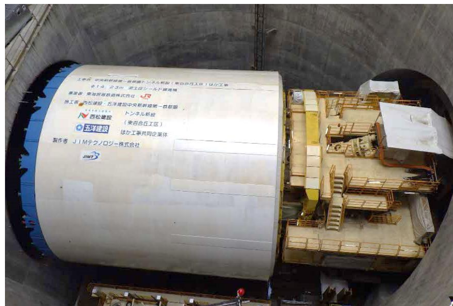
シールド機組立完了
