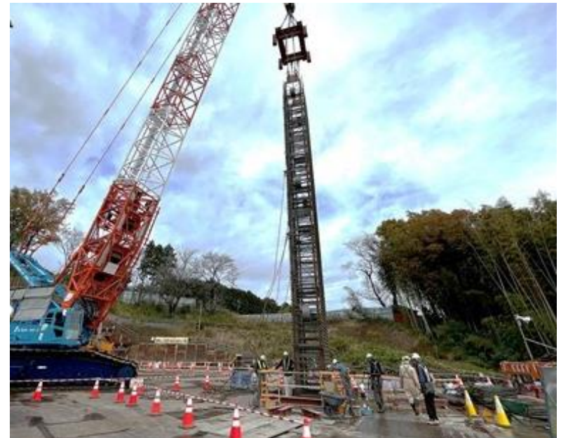
地中連続壁工法により土留め壁を構築中
