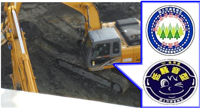
排出ガス対策型、低騒音型建設機械の使用
