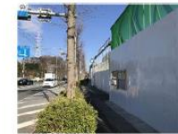
写真① 仮囲い設置
