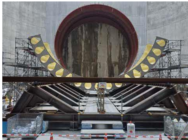
シールド機本体下部の据付
