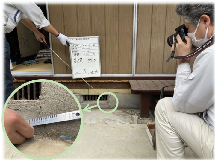
外壁・基礎調査
