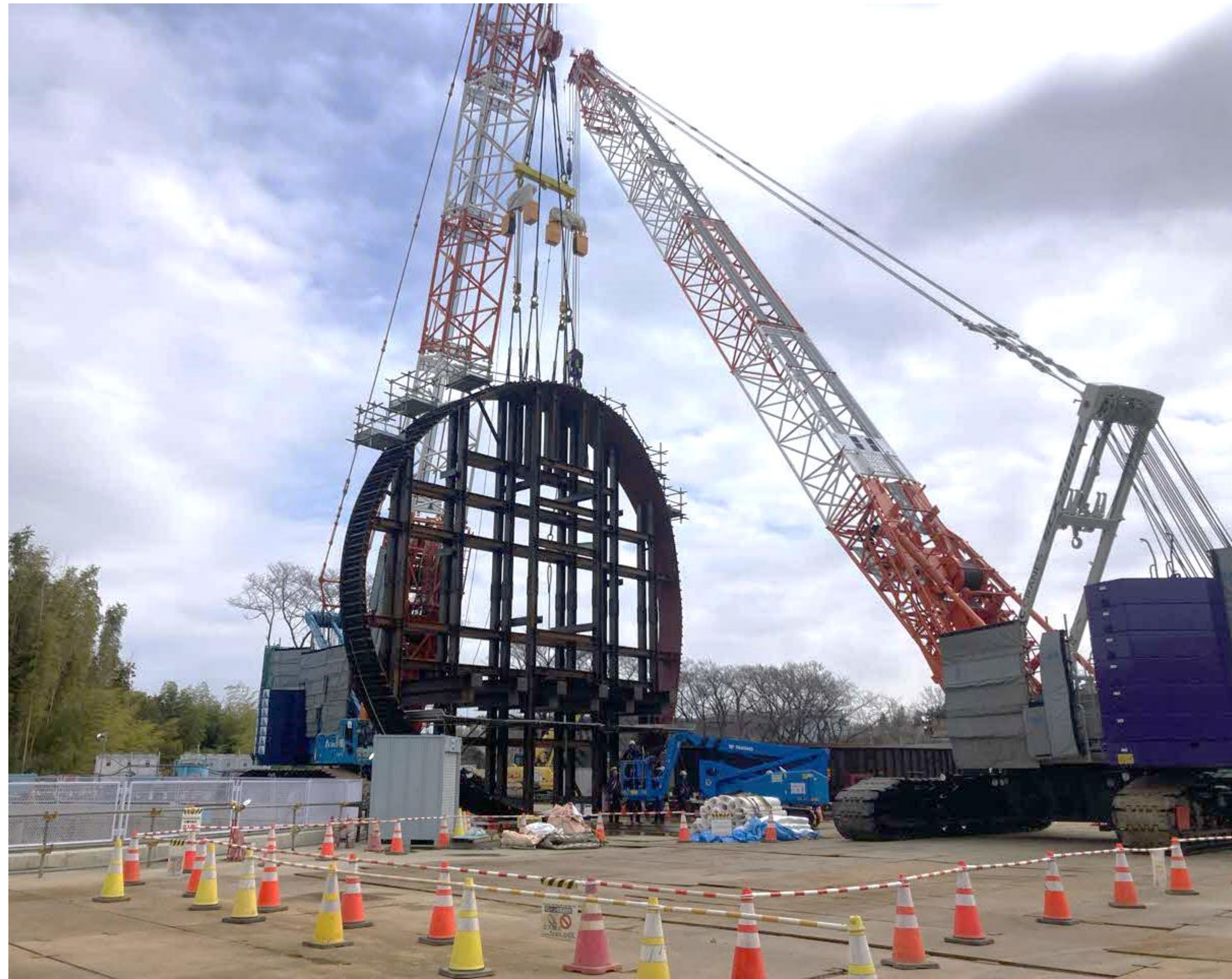
到達設備設置の作業イメージ
