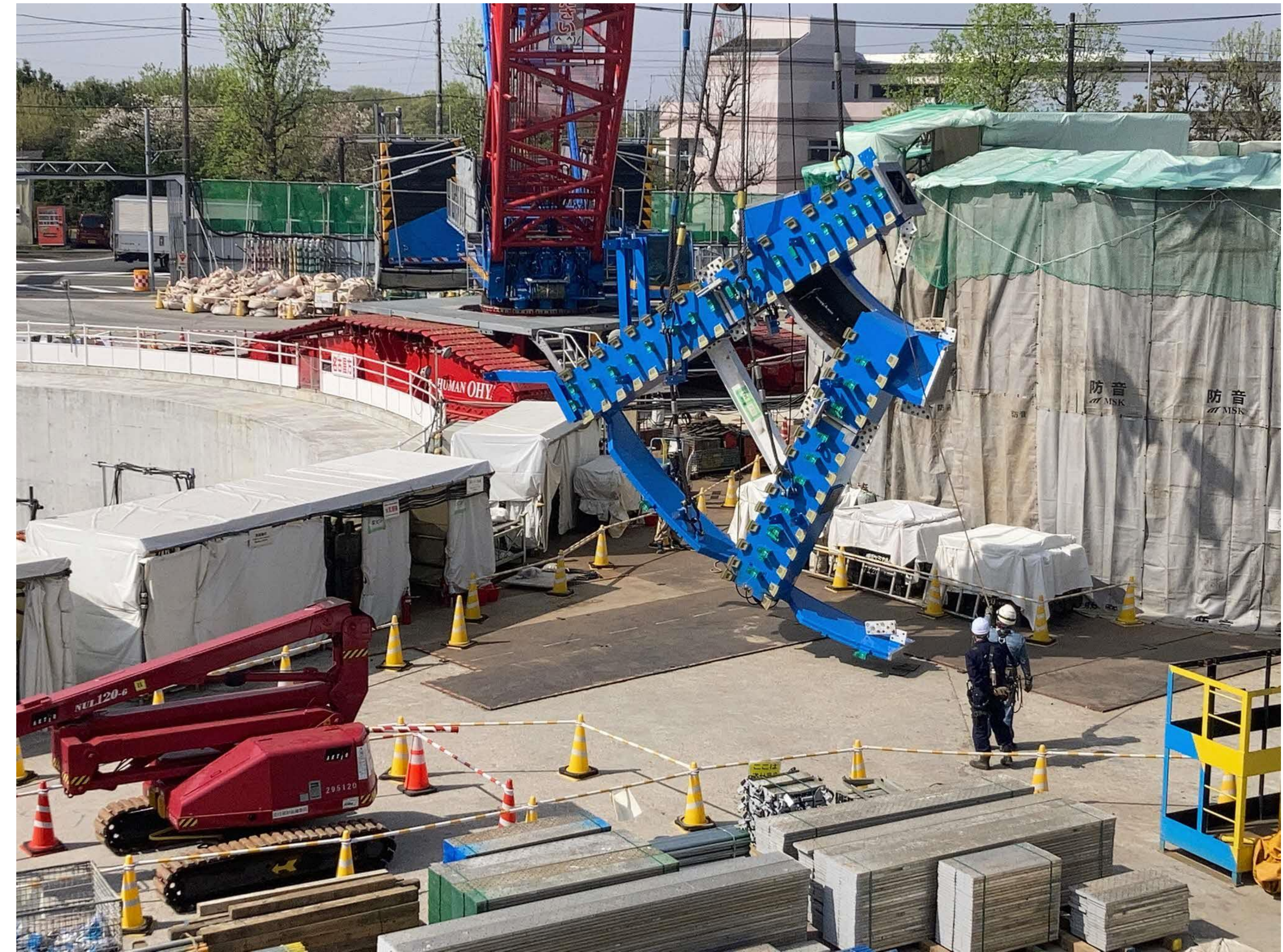
シールド機解体の作業イメージ
