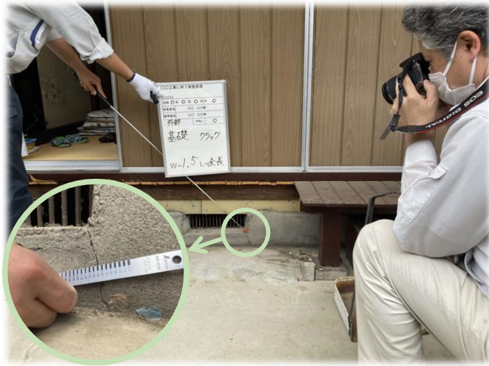
外壁・基礎調査
