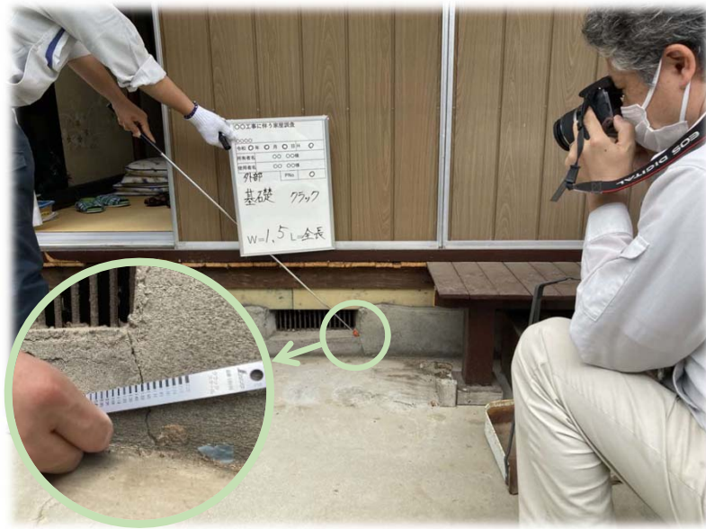
外壁・基礎調査
