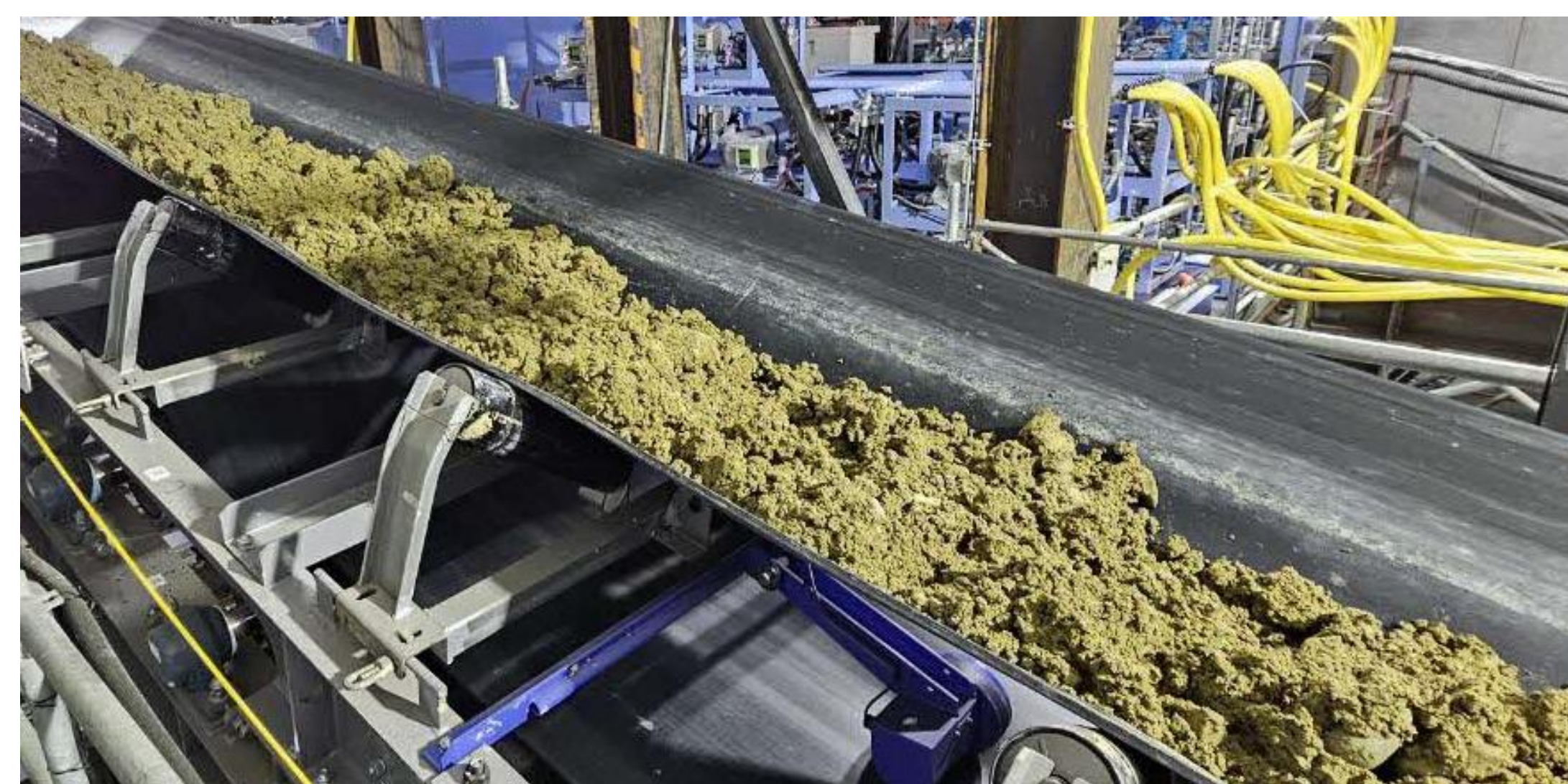
排出された土砂
