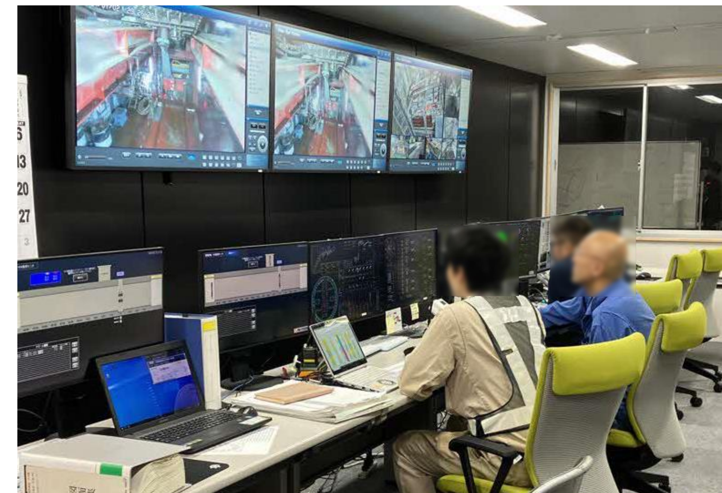
泥土圧の確認状況
