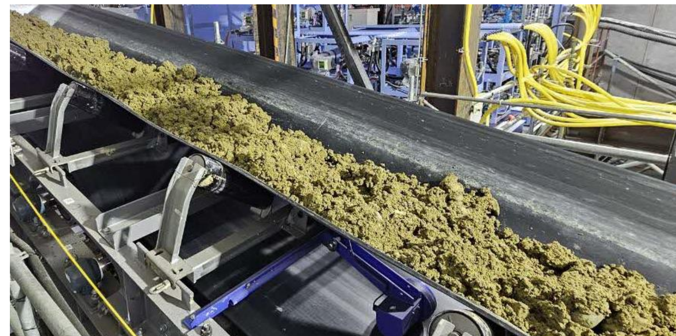
排出された土砂
