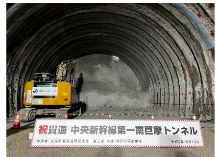
第一南巨摩トンネル貫通（2023年10月）
