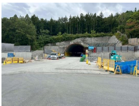
第一南巨摩トンネル坑口
