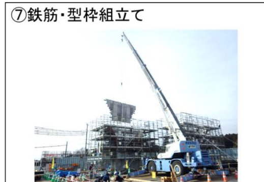
図 2-6(1) 高架橋（下部工）の施工手順①
