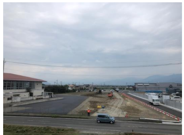
写真 2-2 工事施工ヤードの工事着手前の状況
