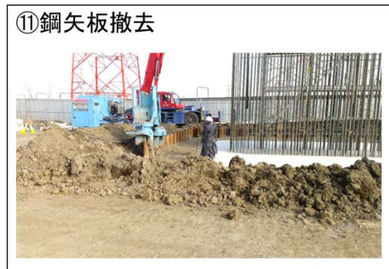
図 2-6(2) 高架橋(下部工)の施工手順②
