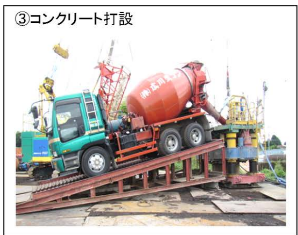
図 2-5 高架橋（基礎杭）の施工手順
