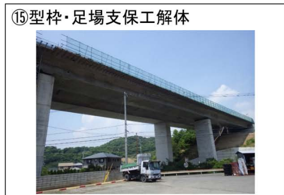
図 2-7 高架橋（上部工）の施工手順
