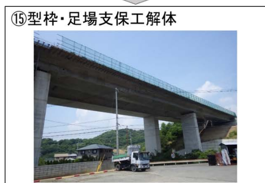
図 2-7 高架橋（上部工）の施工手順
