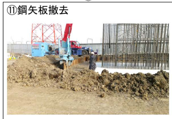
図 2-6(2) 高架橋（下部工）の施工手順②
