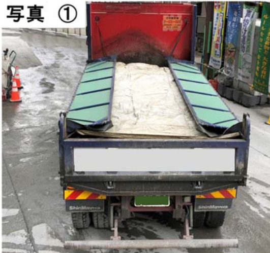
荷台への防じんシート等の設置
