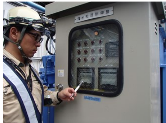
写真 6-1-10 工事排水の監視 (濁水処理設備の監視・点検)
