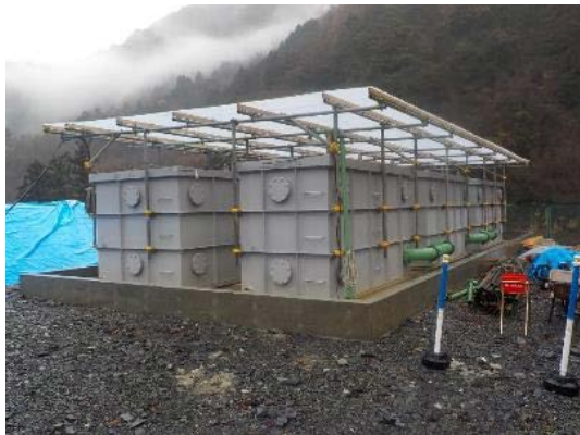
写真 6-4-5 浸潤水用水槽 (雨畑地区発生土仮置き場)
