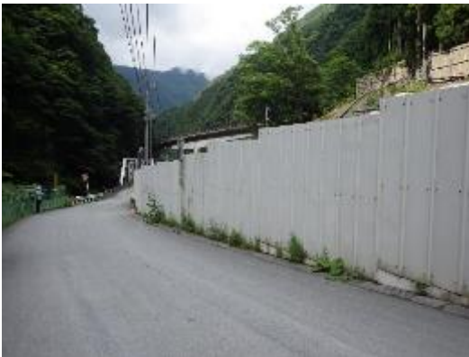
写真 6-2-5 仮囲いの設置 (早川非常口)
