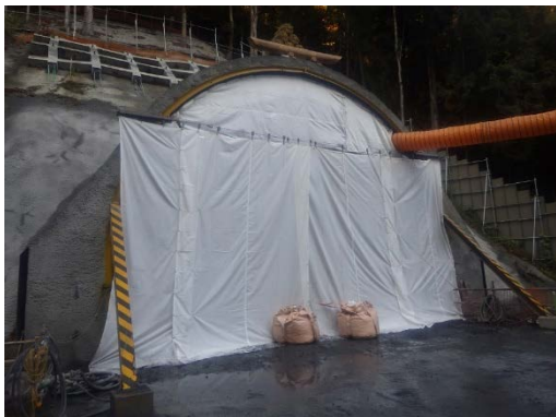
発破作業時の坑口状況
