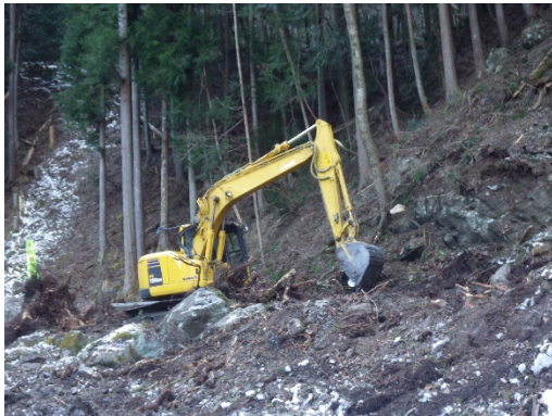
重機作業による整地作業
