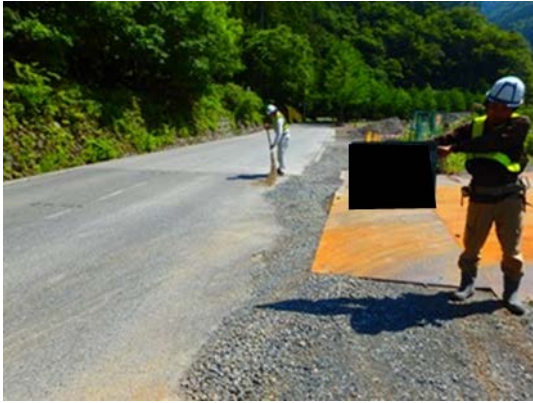
写真 6-4-3 清掃実施状況 (塩島地区(南)発生土仮置き場)
