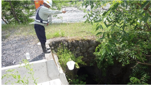
写真 6-3-7 工事排水の監視 (塩島地区発生土置き場)
