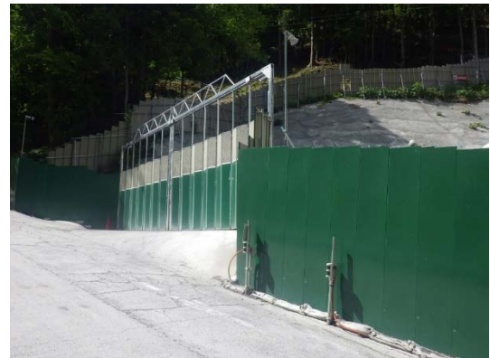
写真 6-2-6 仮設物の色合いへの配慮 (広河原非常口仮囲い)
