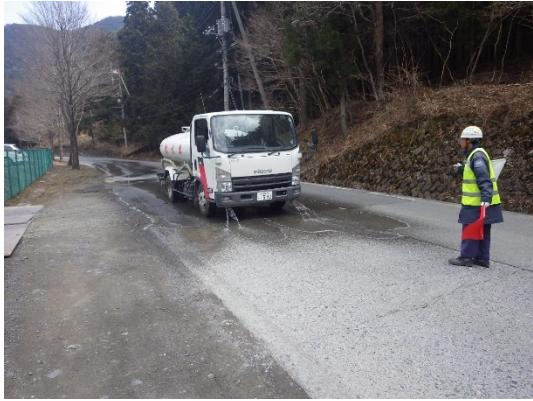
写真 6-2-7 道路への散水
