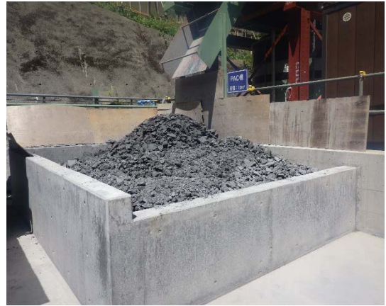
写真 6-2-21 建設汚泥の脱水処理 (早川非常口)
