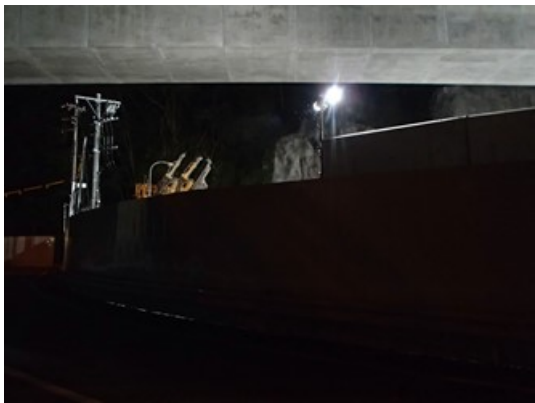
写真 6-1-13(2) LED 照明（点灯時）
