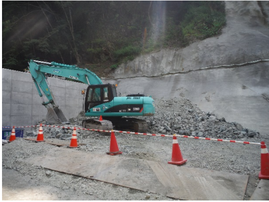
写真 6-1-11 土砂ピットにおける掘削土砂の管理
