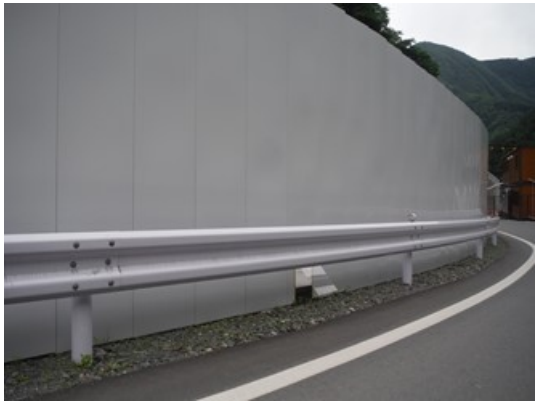
写真 6-1-12(2) 小動物が脱出可能な仮囲い
