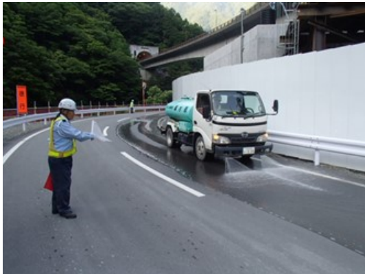
写真 6-1-7 道路への散水
