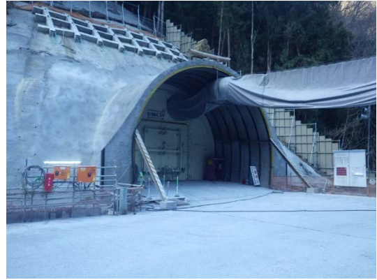
写真 6-2-16 防音扉の設置 （広河原非常口）
