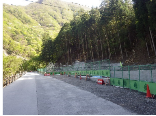
写真 6-2-14 侵入防止柵の設置 （広河原非常口）
