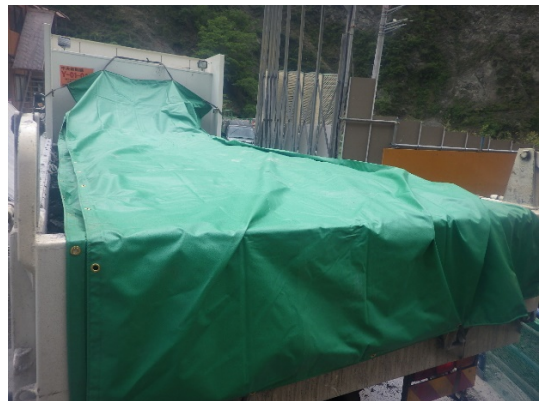
写真 6-2-12 運搬時の浸透防止シート設置状 況
