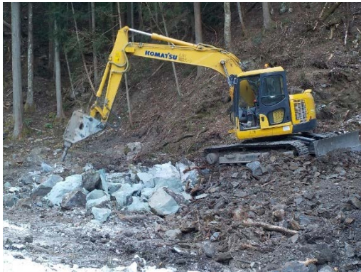
重機作業による削岩作業
