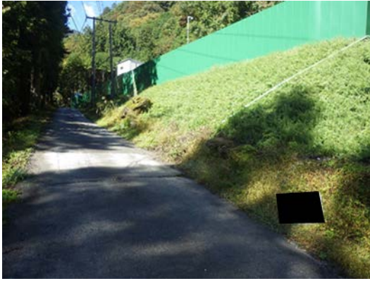
写真 6-2-19 のり面の緑化 (広河原非常口)
