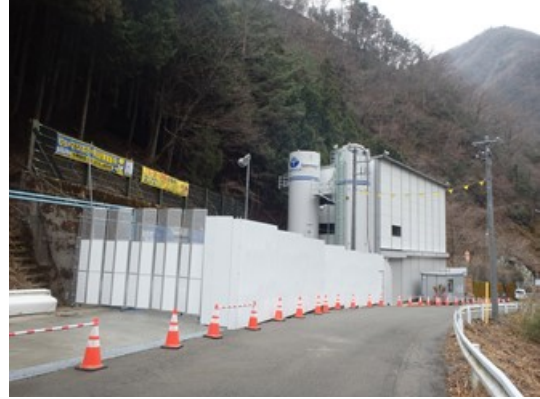
写真 6-1-6(2) 仮囲い、パッチャープラント 建屋設置
