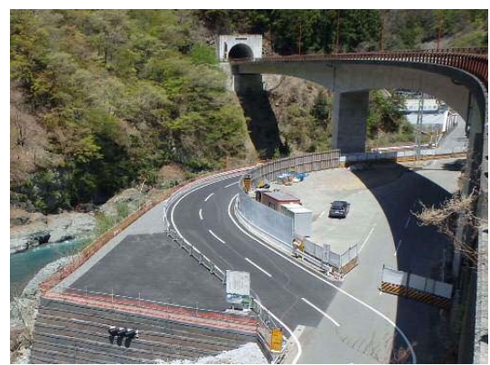
写真 6-1-5(2) 工事現場の清掃（清掃後）
