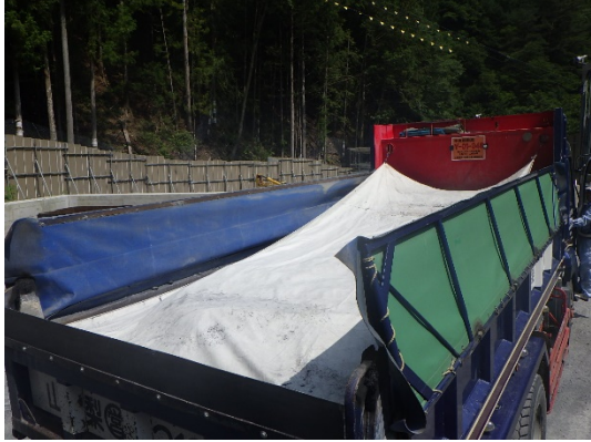
写真 6-4-7 運搬時の浸透防止シート設置状況
