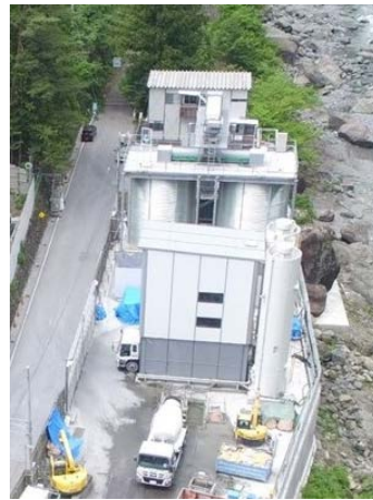
写真 6-2-23(1) バッチャープラント 建屋設置 (早川非常口)
