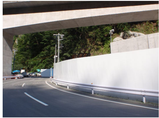
写真 6-1-13(1) LED 照明（点灯前）
