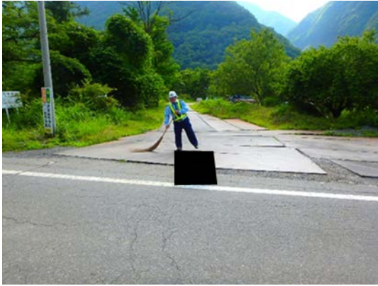
写真 6-3-3 清掃実施状況 (塩島地区発生土置き場)
