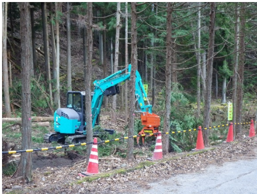
重機作業による伐採した木の収集
