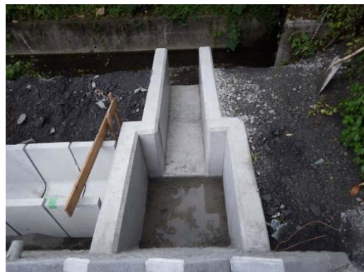
写真 6-3-6 沈砂池の設置 (塩島地区発生土置き場)
