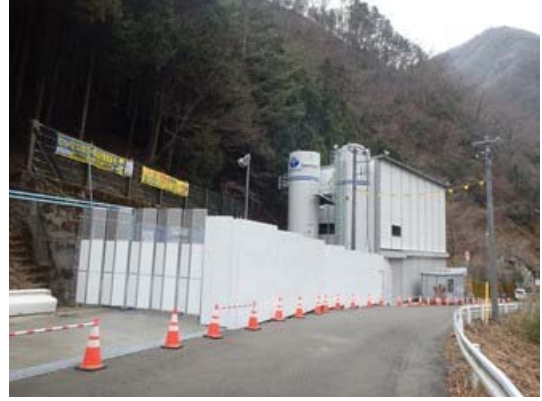
写真 6-1-6(2) 仮囲い、バッチャープラント 建屋設置
