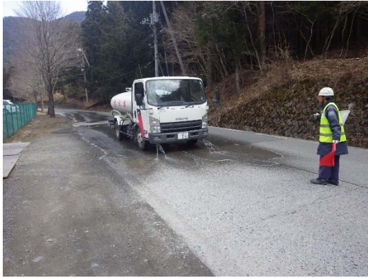
写真 6-2-7 道路への散水
