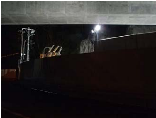
写真 6-1-13(2) LED 照明（点灯時）
