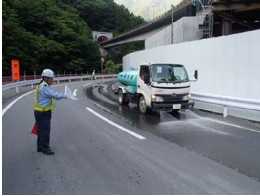
写真 6-1-7 道路への散水
