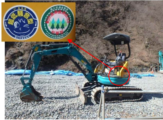
写真 6-1-1 排出ガス対策型・低騒音型 建設機械の採用
