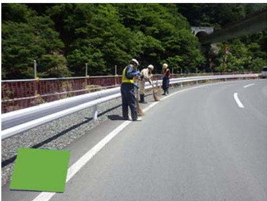
写真 6-1-5(1) 工事現場の清掃
