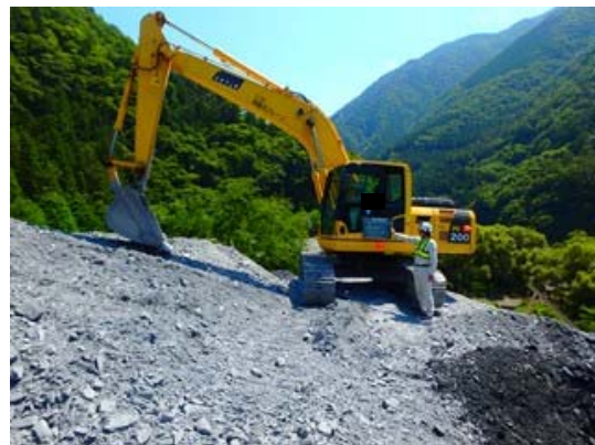
写真 6-4-6 建設機械の点検・整備
