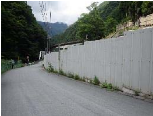
写真 6-2-5 仮囲いの設置 (早川非常口)
