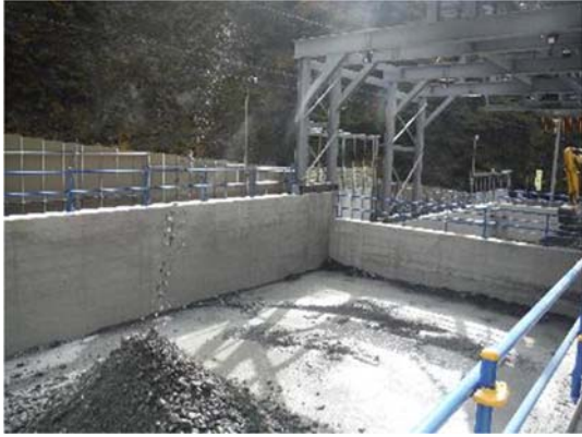
写真 6-2-13 土砂ピットにおける掘削土砂管理（早川非常口）
