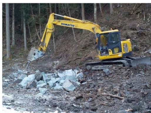
重機作業による削岩作業
