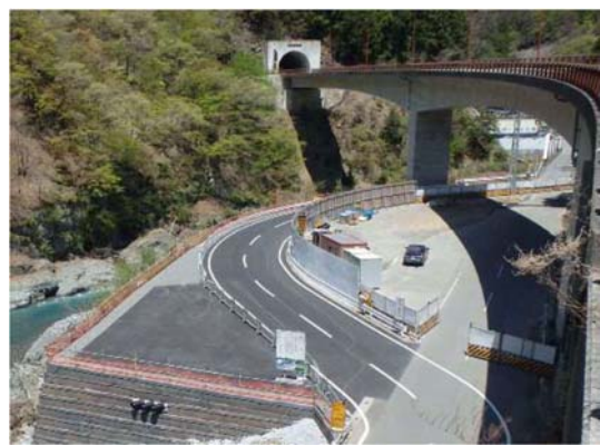
写真 6-1-5(2) 工事現場の清掃（清掃後）
