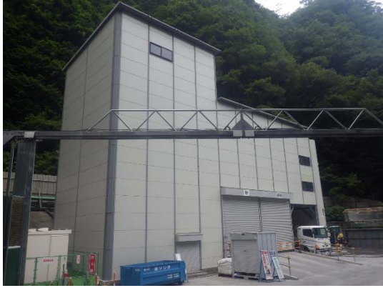
写真 6-2-23 (2) バッチャープラント建屋設置 (広河原非常口)
