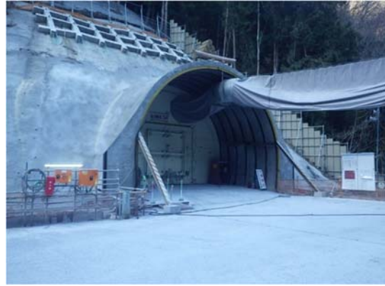
写真 6-2-16 防音扉の設置（広河原非常口）
