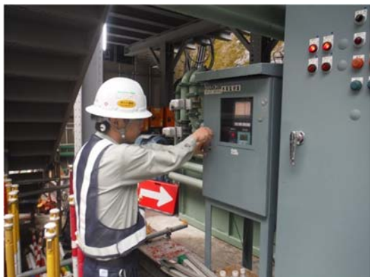
写真 6-2-11 工事排水の監視 (濁水処理設備の監視・点検)
