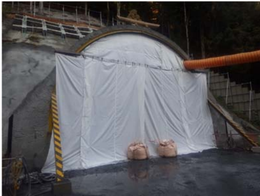
発破作業時の坑口状況
