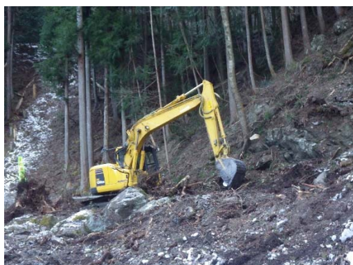
重機作業による整地作業
