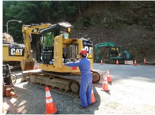
写真 6-1-2 建設機械の点検・整備
