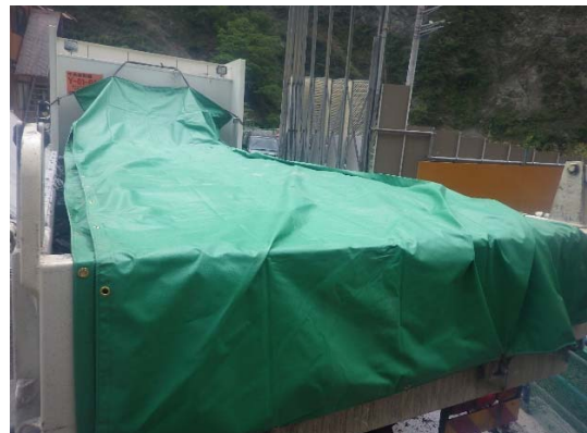
写真 6-2-12 運搬時の浸透防止シート設置状 況
