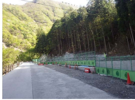
写真 6-2-14 侵入防止柵の設置（広河原非常口）
