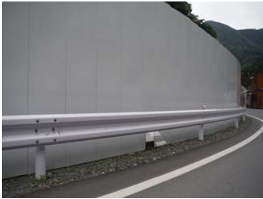
写真 6-1-12(2) 小動物が脱出可能な仮囲い
