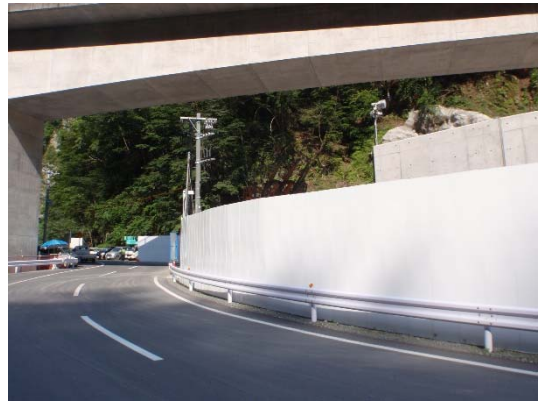
写真 6-1-13(1) LED 照明（点灯前）
