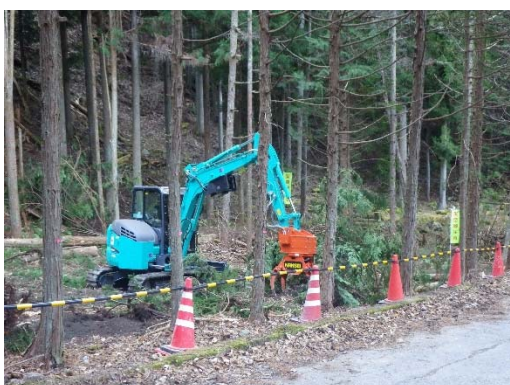
重機作業による伐採した木の収集
