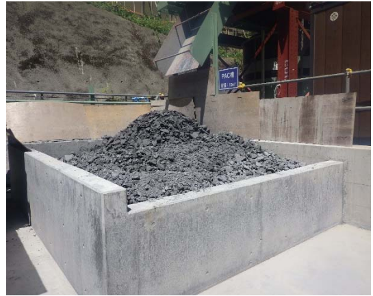
写真 6-2-21 建設汚泥の脱水処理 (早川非常口)
