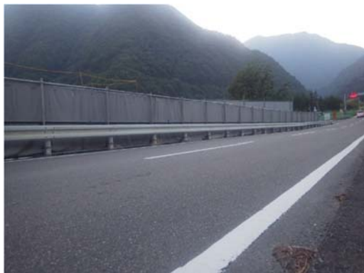
写真 6-3-5 防音シートの設置 (塩島地区発生土置き場)
