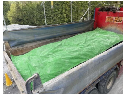
写真 5-11-6 運搬時の防じんシート 設置状況
