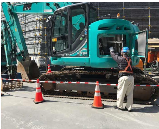
写真5-9-3 建設機械の点検及び整備状況
