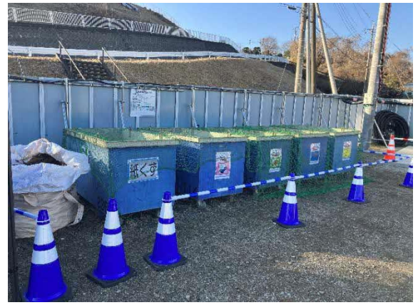
写真5-1-11 副産物の分別・再資源化
