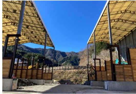
写真5-8-14 土砂ピットにおける掘削土砂の 適切な管理状況（底盤及び周辺に コンクリート打設、屋根の設置）
