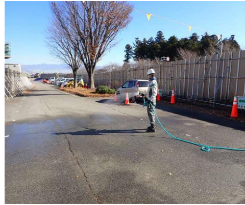
写真5-6-6 工事現場の散水状況
