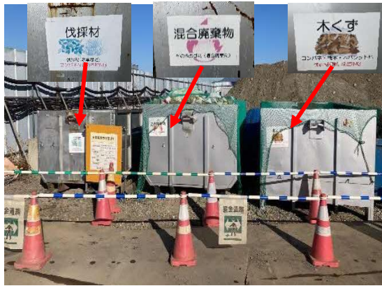
写真5-5-18 副産物の分別、再資源化
