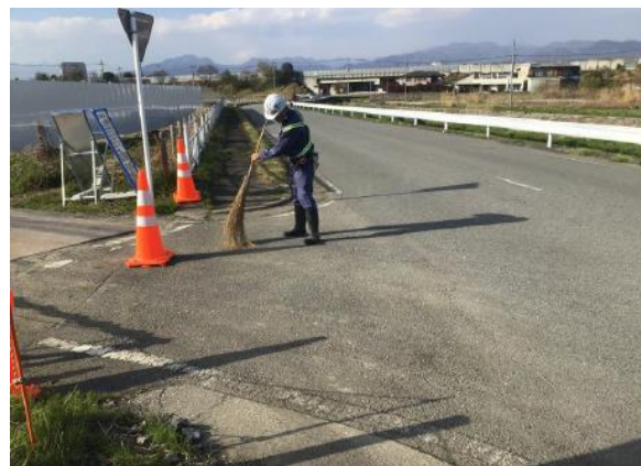
写真 5-3-5 周辺道路の清掃
