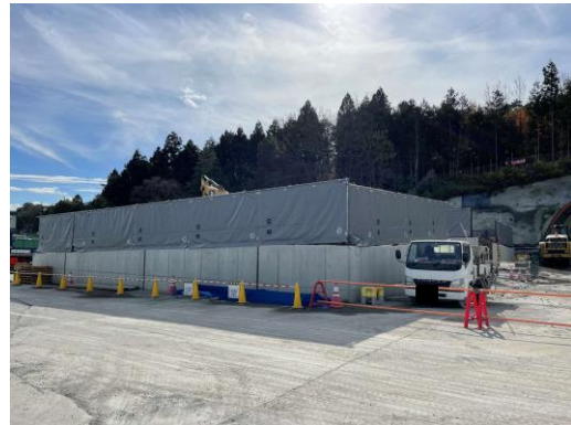
写真5-7-10 防音シートの設置状況
