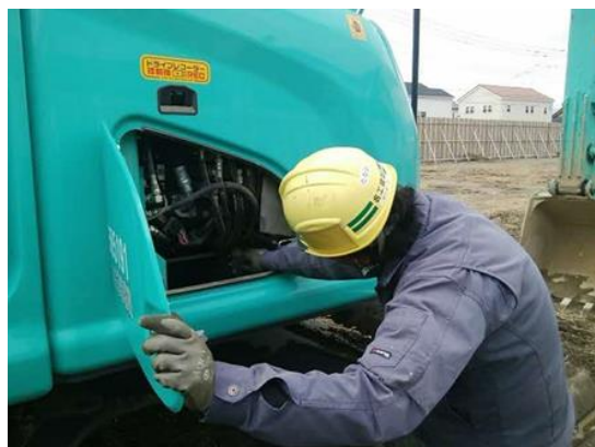
写真5-4-2 建設機械の点検及び整備の実施状況
