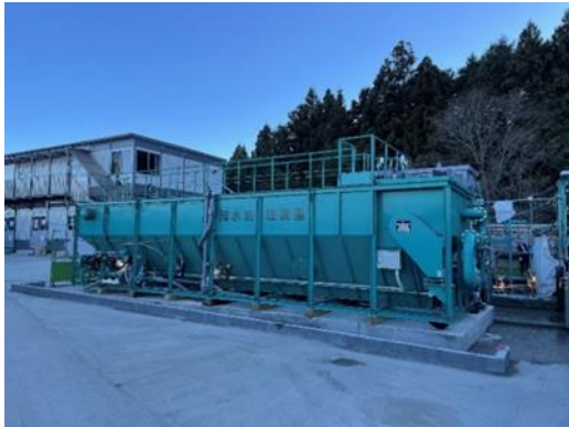
写真5-7-11 濁水処理設備の設置状況
