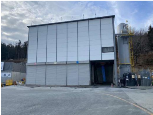
写真5-7-9 バッチャープラント建屋の設置状況
