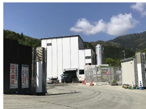
写真 5-8-18 バッチャープラント建屋の 設置状況
