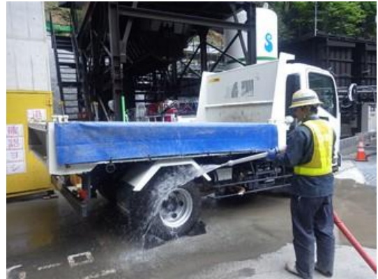
写真 5-9-8 タイヤ洗浄状況
