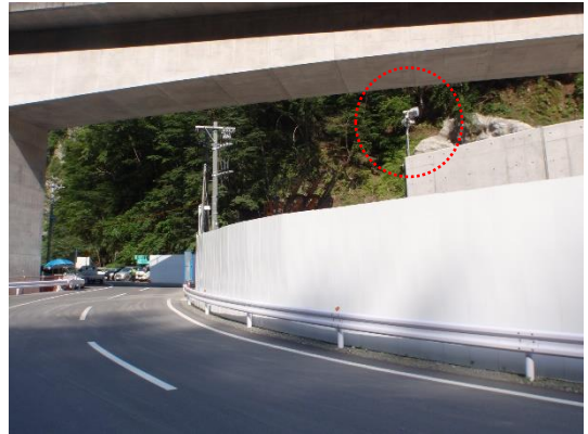
写真5-9-15 (1) 照明の漏れ出しの抑制（LED照明の採用）
