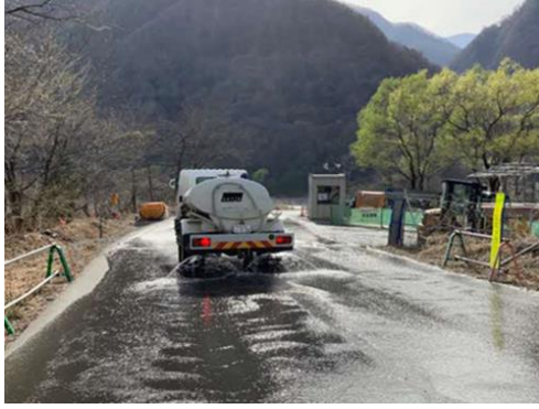
写真 5-11-7 道路への散水状況
