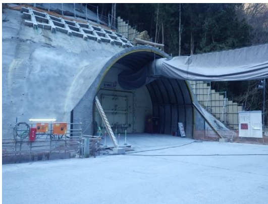
写真 5-11-9 防音扉の設置状況 (広河原非常口)
