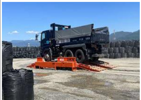
写真5-3-6 タイヤの洗浄状況
