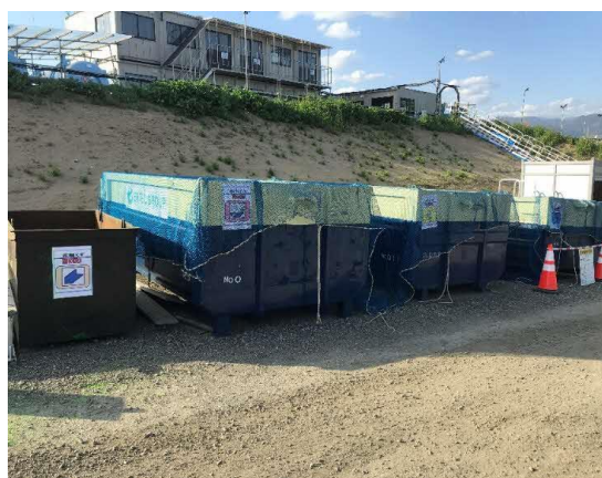
写真 5-2-12 副産物の分別、再資源化
