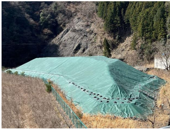
写真 5-13-7 遮水シートの設置状況 (雨畑発生土仮置き場)
