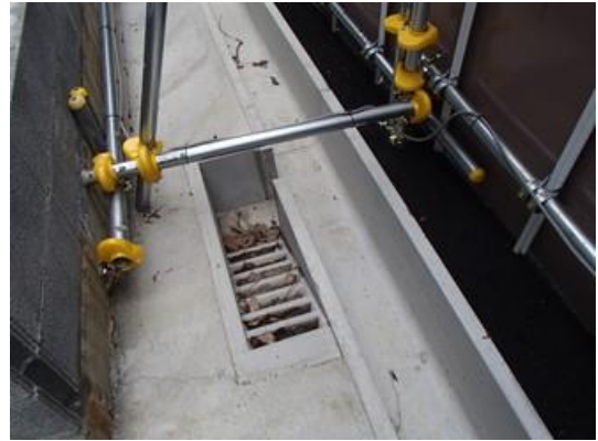
写真5-9-14(1) 小動物が脱出可能な側溝の設置状況
