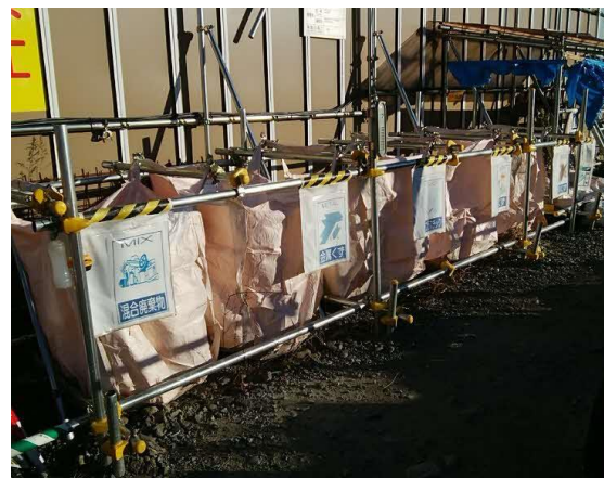
写真5-4-11 副産物の分別・再資源化
