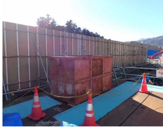
写真5-6-10 濁水処理施設の設置状況
