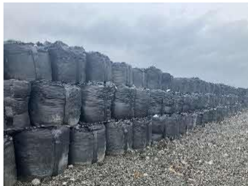
写真5-5-16 (2) 仮締切工の実施状況
