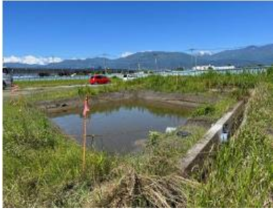
写真 5-3-7 沈砂池の設置
