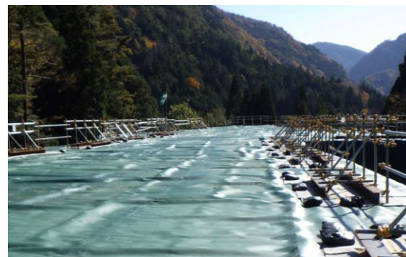
図 参 1-4-6 遮水シート設置状況 (湯島地区(田島)発生土仮置き場)
