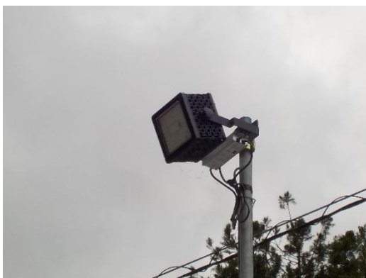
写真5-11-16 照明の漏れ出しの抑制 (LED照明の採用) (早川非常口)
