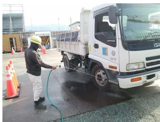
写真5-4-6 資材及び機械の運搬に用いる車両のタイヤ洗浄の状況
