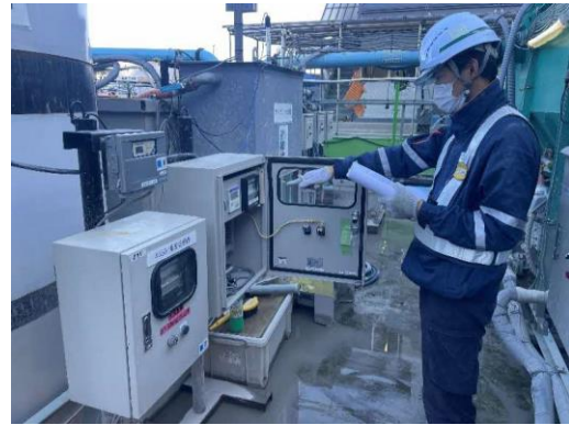
写真5-7-12 工事排水の監視及び濁水処理設備の点検状況
