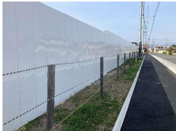
写真5-2-4 仮囲い設置状況
