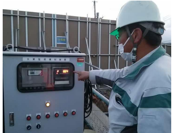
写真5-4-10 工事排水の監視及び濁水処理設備の点検状況
