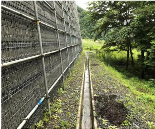
図 参 1-4-1 外周の排水溝の設置 (西之宮地区発生土仮置き場)
