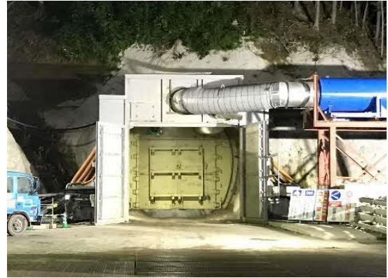
写真5-8-8 坑口の防音扉設置状況
