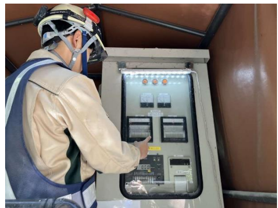
写真5-9-12 工事排水の監視及び 濁水処理設備の点検状況
