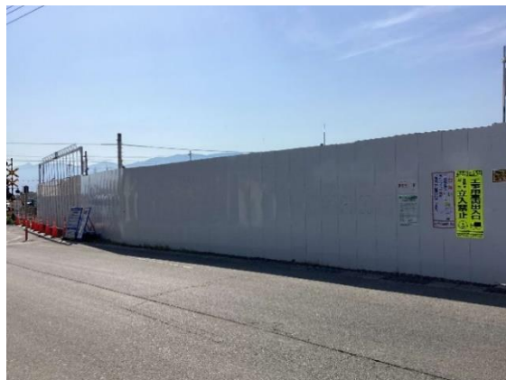
写真5-4-4 仮囲いの設置状況
