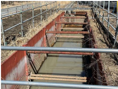
写真 5-12-5 沈砂池の設置状況 (塩島地区(河川側)発生土仮置き場)
