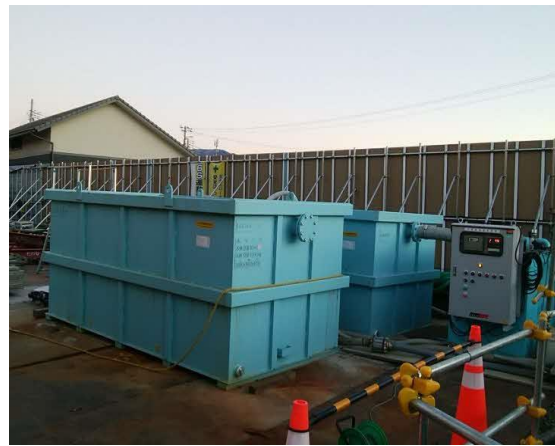
写真5-4-9 濁水処理設備の設置状況
