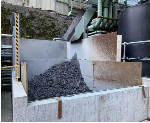
写真 5-11-18 建設汚泥の脱水処理状況 (早川非常口)
