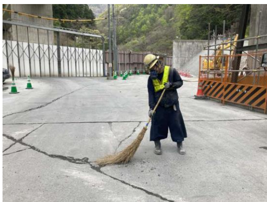
写真5-9-5 工事現場の清掃状況
