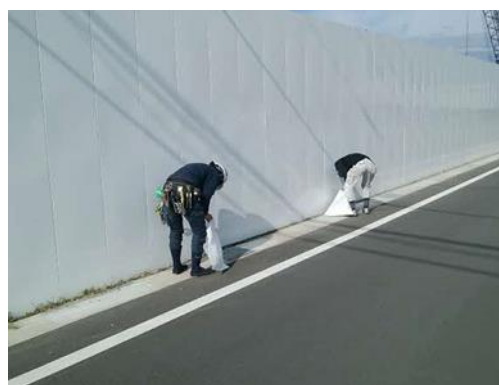
写真5-5-6 工事現場の清掃状況
