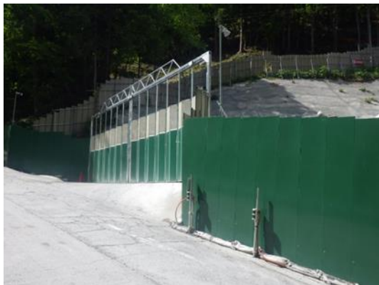
写真 5-11-5 仮設物の色合いへの配慮 (広河原非常口仮囲い)
