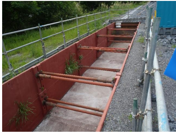
図 参 1-4-2 仮設沈砂池の設置 (塩島地区(河川側)発生土仮置き場)
