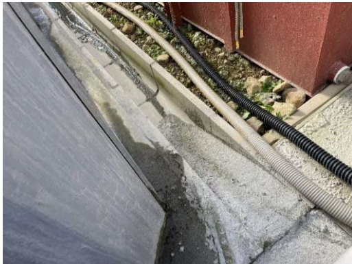
写真5-7-15 小動物が脱出可能な側溝の設置状況
