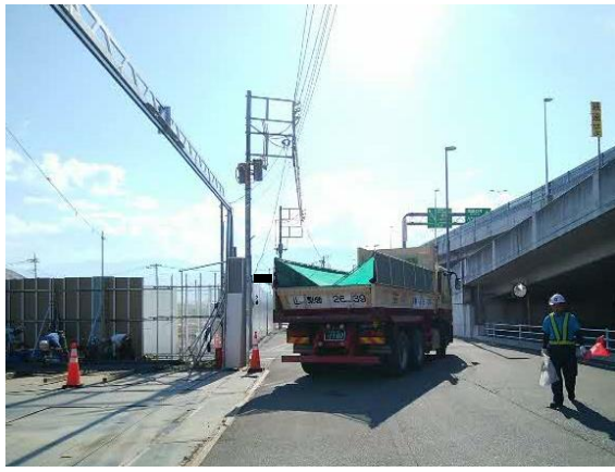
写真5-4-7 荷台への防塵シートの敷設状況
