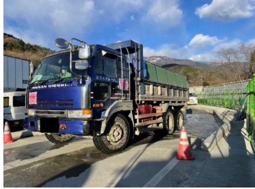
写真5-7-8 タイヤの洗浄状況
