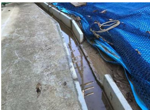
写真 5-8-17 小動物が脱出可能な側溝の 設置状況
