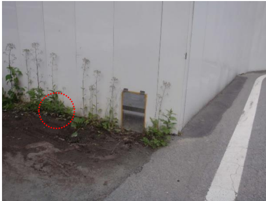
写真5-9-14(2) 小動物が脱出可能な仮囲いの設置状況
