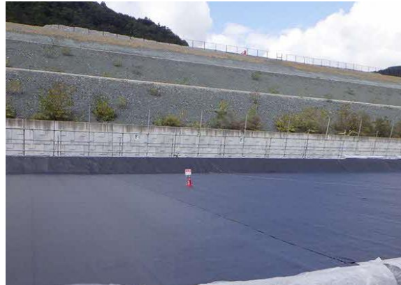
図 参 1-4-4 アスファルトの舗装状況 (西之宮地区(その2)発生土仮置き場)
