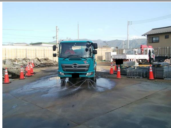
写真5-4-5 工事現場の散水状況
