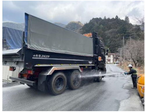
写真 5-11-8 タイヤ洗浄状況
