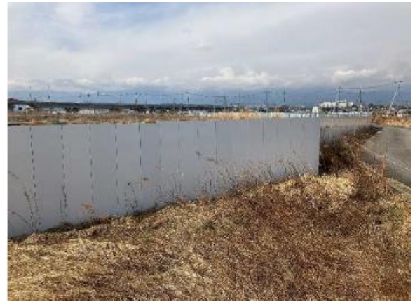
写真5-3-2 仮囲いの設置
