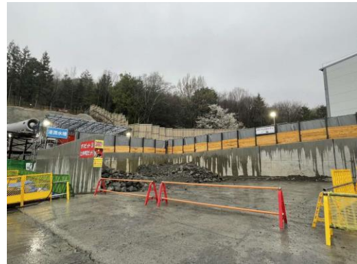
写真5-7-16 LED灯の設置状況
