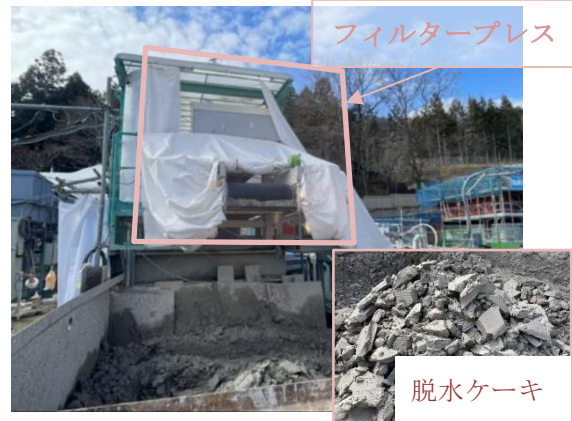
写真5-7-18 建設汚泥の脱水処理
