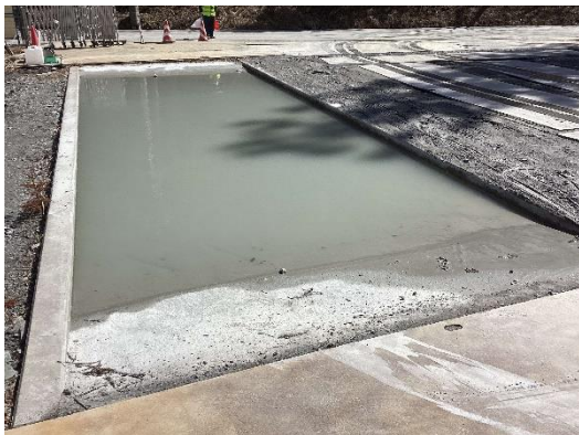
写真 5-12-3 タイヤ洗浄プールの設置状況 (塩島地区 (河川側) 発生土仮置き場)
