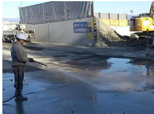
写真5-7-6 工事現場の散水状況
