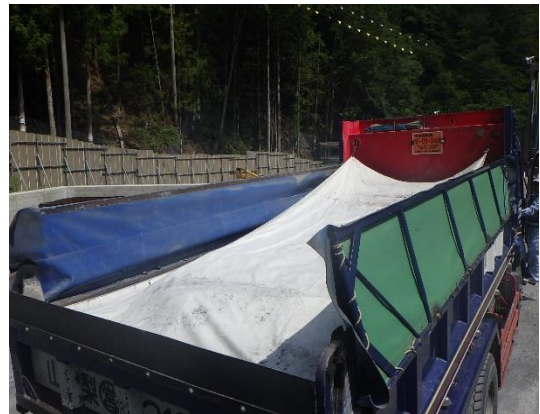
写真 5-13-4 運搬時の防じんシート 敷設状況
