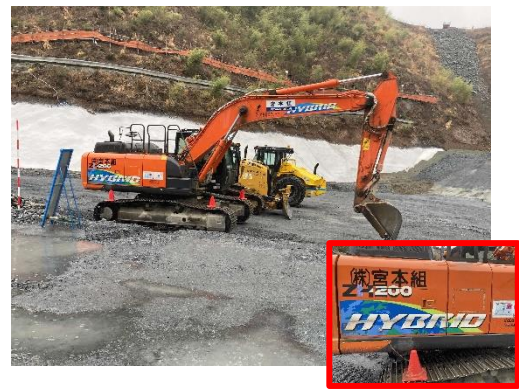
写真 5-8-22 低炭素型建設機械の採用
