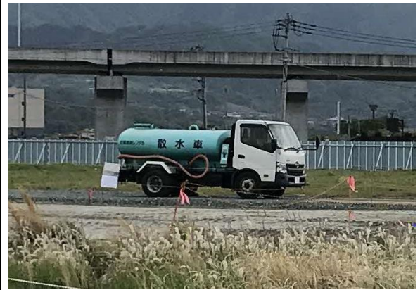
写真5-3-4 工事施工ヤード内の散水
