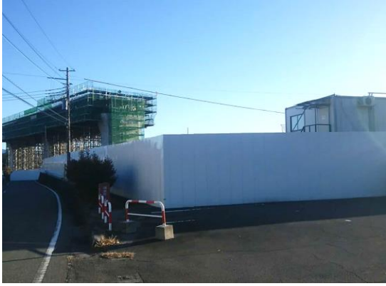
写真5-6-7 仮囲いの設置状況
