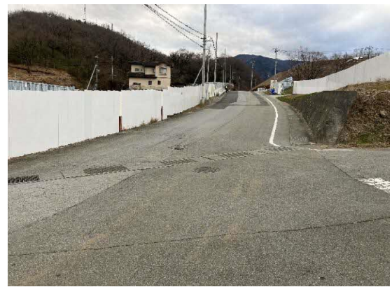
写真5-1-4 仮囲いの設置状況
