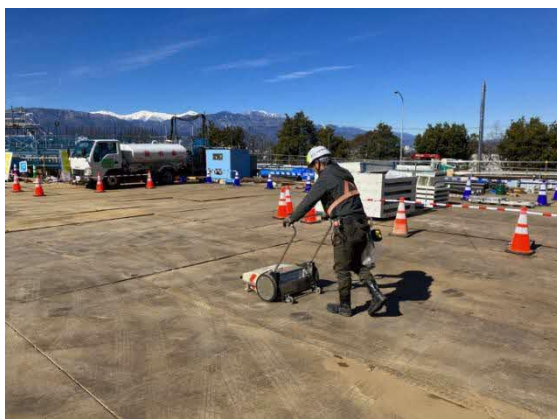
写真5-1-5 工事現場の清掃状況
