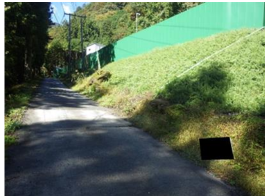
写真 5-11-17 のり面の緑化状況 (広河原非常口)
