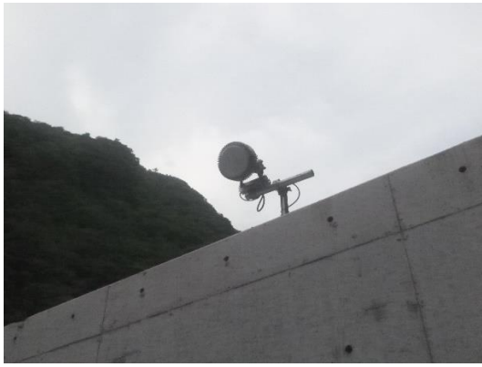
写真5-9-15 (2) 照明の漏れ出しの抑制 (LED照明の採用)
