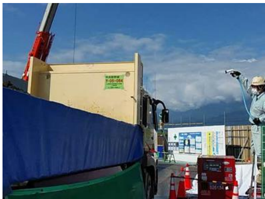
写真5-5-11 荷台への防じんト の敷設及び散水状況
