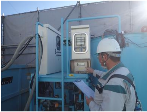
写真5-5-13 工事排水の監視及び 濁水処理設備の点検状況
