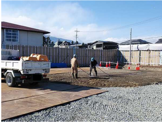
写真5-5-7 粉じん飛散防止剤散布状況
