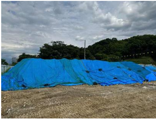
写真5-1-9 掘削土砂の適切な管理
