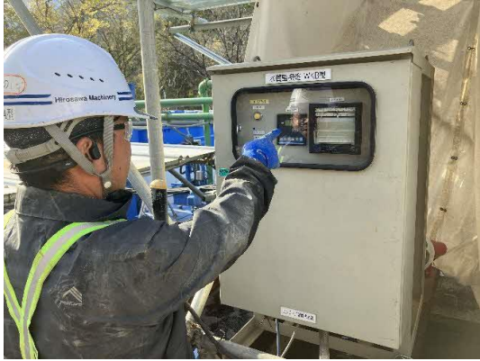
写真5-8-13 工事排水の監視及び 濁水処理設備の点検状況
