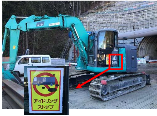
写真5-8-2 建設機械の使用時における配慮の実施状況
