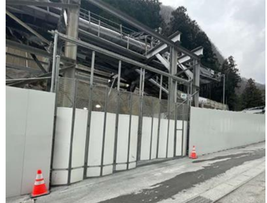
写真 5-11-4 仮囲いの設置状況 (早川非常口)
