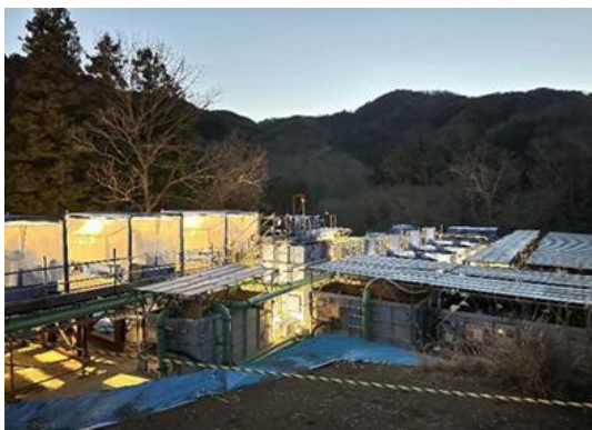
写真5-8-11 濁水処理設備の設置状況
