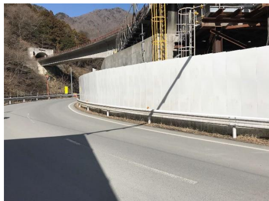
写真5-9-6 仮囲いの設置状況
