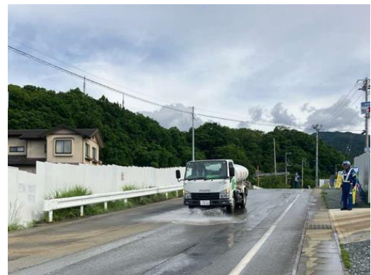
写真5-1-6 周辺道路の散水状況
