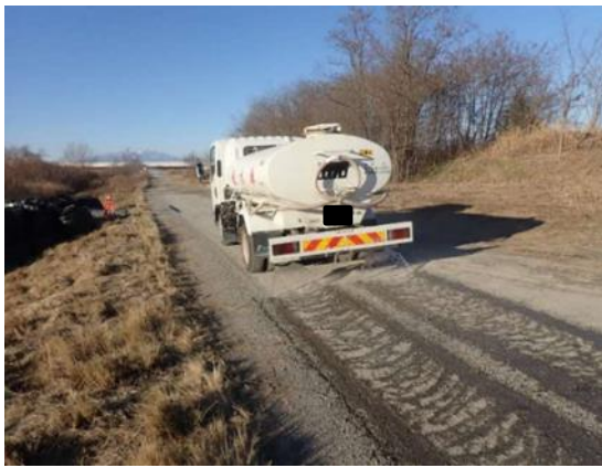
写真5-5-9 河川内道路への散水状況
