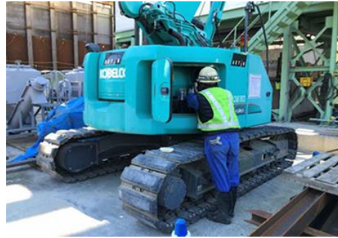
写真5-8-4 建設機械の点検及び整備状況
