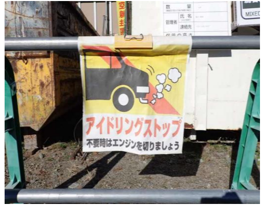
写真5-6-2 建設機械の使用時における配慮
