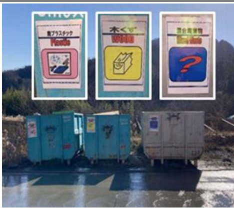
写真 5-8-21 副産物の分別、再資源化
