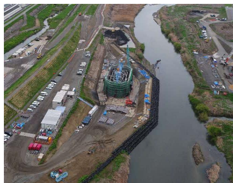
写真 5-2-10 仮締切工の実施状況
