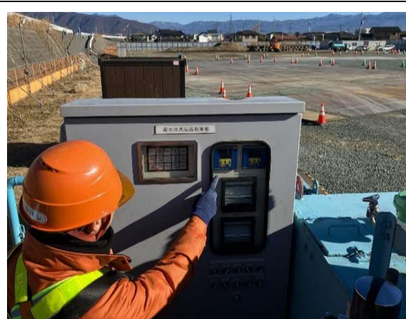
写真 5-2-11 工事排水の監視及び 濁水処理設備の点検状況
