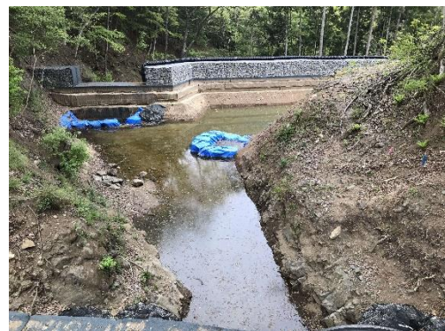
5-8-12 仮設沈砂池の設置状況
