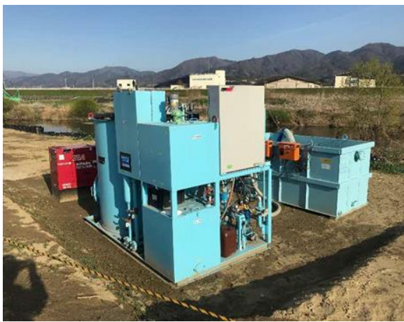
写真 5-2-8 濁水処置設備の設置状況
