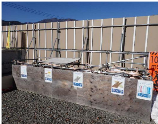
写真5-6-11 建設副産物の分別・再資源化
