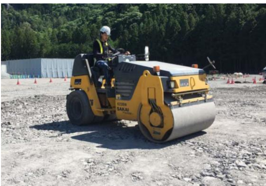
図 参 1-4-5 締固め状況 (中洲地区(その2)発生土仮置き場)
