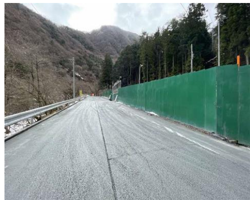
写真 5-11-11 侵入防止柵 (仮囲い) の設置状況 (広河原非常口)
