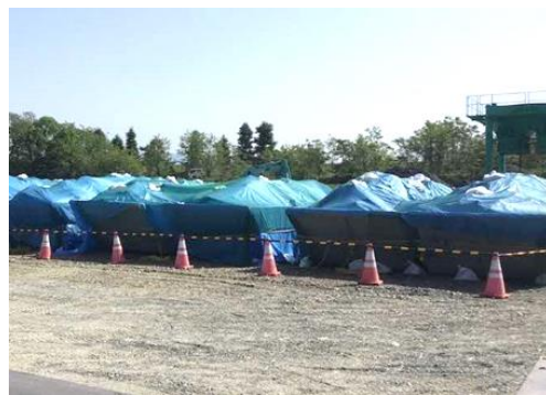
写真5-5-17 掘削土砂の適切な管理
