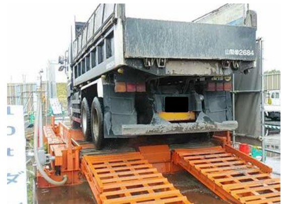
写真5-5-10 タイヤ洗浄の実施状況 (乾式スパッツ)
