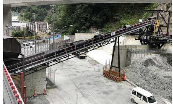
写真5-9-16 仮設物の色合いへの配慮 (ベルトコンベアー)
