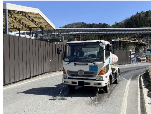
写真5-8-10 周辺道路の散水状況
