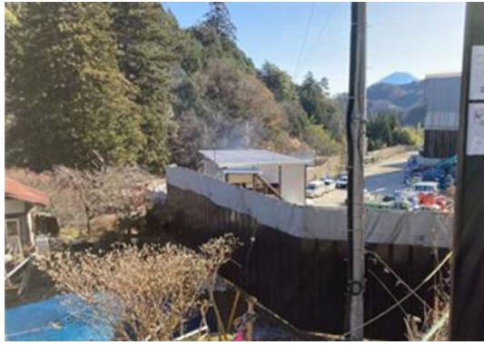
写真5-8-7 仮囲い、防音シートの設置状況
