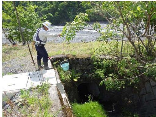
写真 5-12-6 工事排水の監視状況 (塩島地区発生土置き場)
