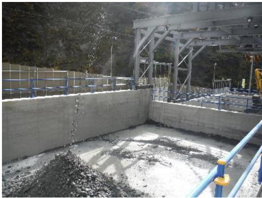
写真 5-11-14 土砂ピットにおける掘削土砂管理 (底盤及び周囲のコンクリート打設) (早川非常口)
