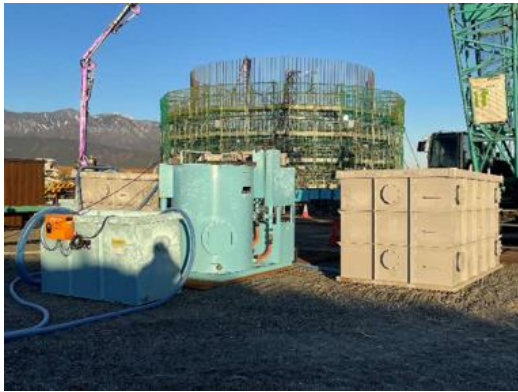
写真5-5-15 河川内工事の適切な排水処理 (濁水処理設備)
