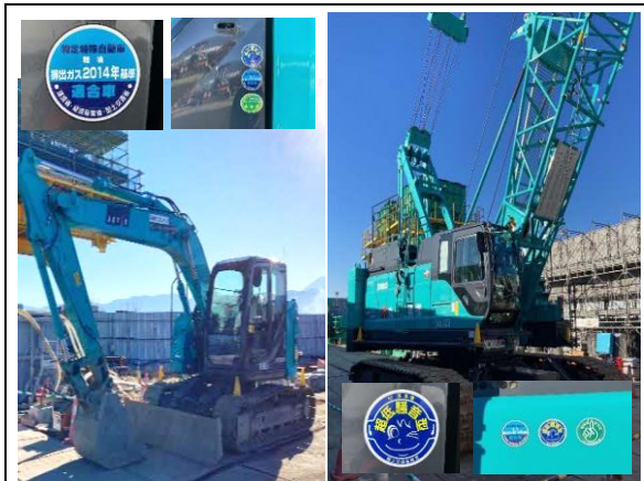
写真5-5-1 排出ガス対策型・低騒音型機械の採用
