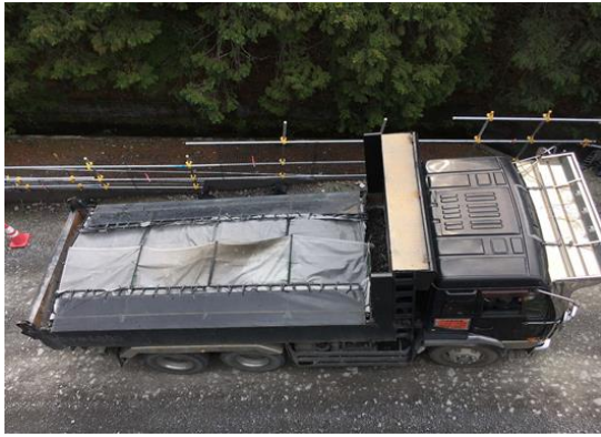
写真 5-9-7 運搬時の防じんシート 設置状況
