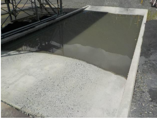
写真 5-13-5 タイヤ洗浄プールの設置状況 (塩島(南)発生土仮置き場)
