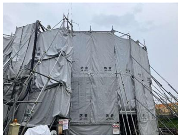
写真5-4-8 防音シートの設置状況
