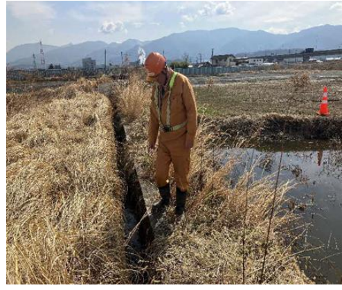
写真5-3-8 工事排水の監視
