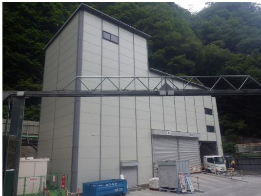
写真 5-11-10(2) バッチャープラント建屋設置状況 (広河原非常口)
