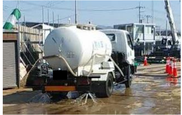
写真5-5-8 散水の実施状況
