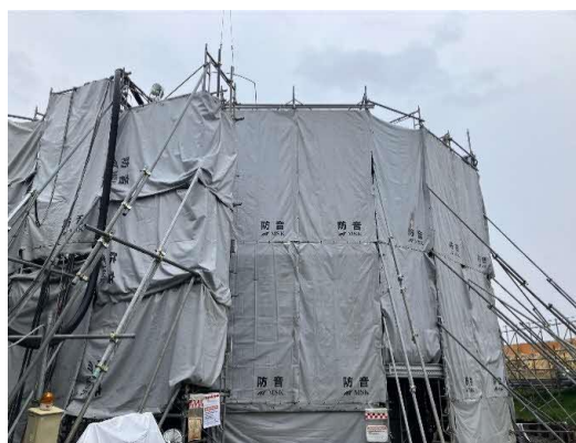
写真5-5-5 仮囲い・防音シートの設置状況
