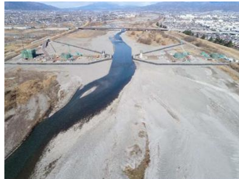
写真5-5-16 (1) 仮締切工の実施状況
