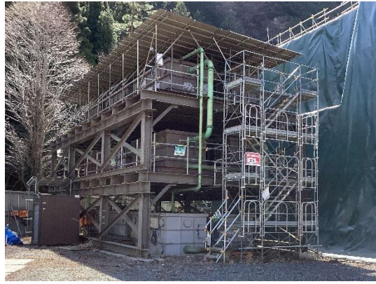
写真 5-13-6 浸潤水用水槽の設置状況 (塩島(下流)発生土仮置き場)
