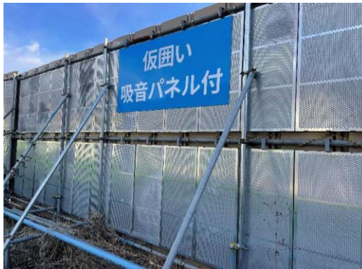
写真5-7-5 仮囲い、防音シートの設置状況
