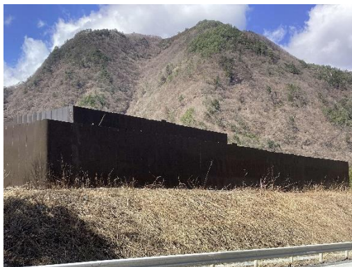
写真 5-12-4 仮囲いの設置状況 (塩島地区発生土置き場)
