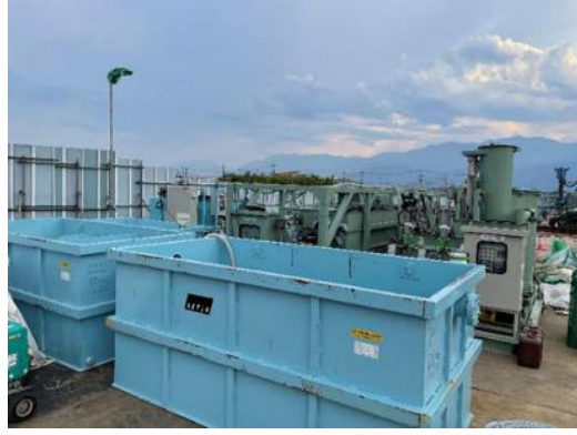
写真5-5-14 濁水処理設備の設置状況
