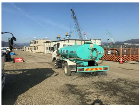
写真5-2-5 工事現場の散水状況
