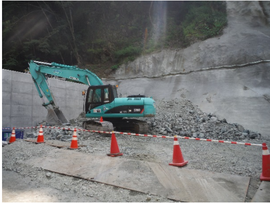
写真6-4-11(1) 土砂ピットにおける掘削土砂の管理（底盤及び周囲のコンクリート打設）
