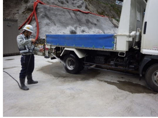
写真 6-5-8 外来種の拡大抑制 (タイヤ洗浄)
