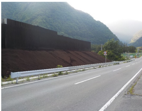
写真 6-6-5 仮囲い設置 (塩島地区発生土置き場)
