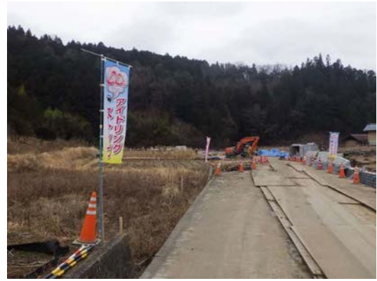
写真6-8-2 建設機械の使用時における配慮
