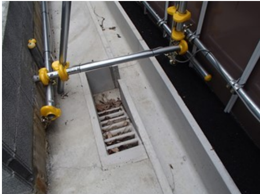
写真6-4-11(1) 土砂ピットにおける掘削土砂の管理（底盤及び周囲のコンクリート打設）
