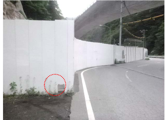
写真6-4-12(2) 小動物が脱出可能な仮囲い
