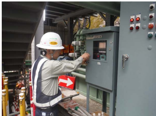
写真 6-5-11 工事排水の監視 (濁水処理設備の監視・点検)
