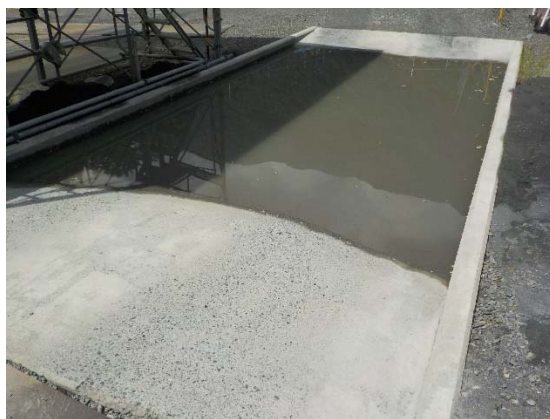
写真 6-7-5 タイヤ洗浄プール (塩島(下流)発生土仮置き場)
