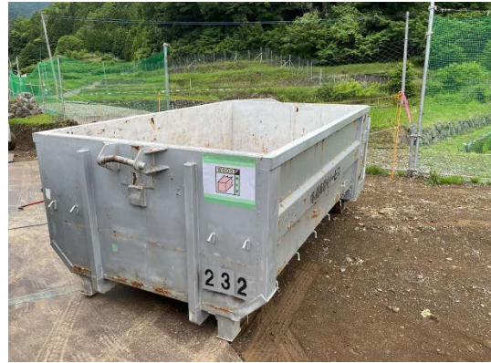
写真6-3-8 建設副産物の分別・再資源化
