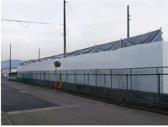
写真6-1-7 仮囲いの設置
