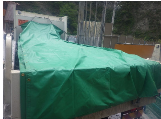
写真 6-5-12 運搬時の浸透防止シート 設置状況
