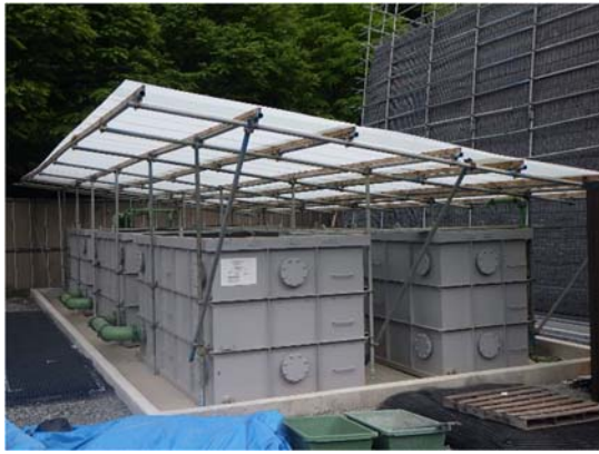
写真 6-7-7 浸潤水用水槽 (塩島 (下流) 発生土仮置き場)
