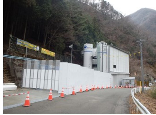
写真6-4-6(2) 仮囲い、バッチャープラント建屋設置
