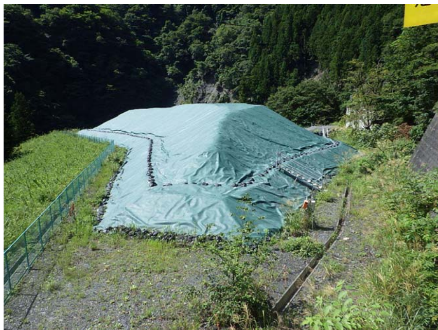
写真 4-1-1-1 雨畑地区発生土仮置き場
