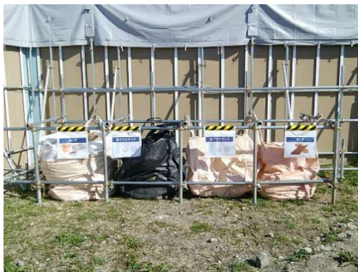
写真6-1-10 建設副産物の分別・再資源化
