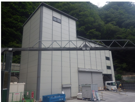
写真 6-5-21 (2) バッチャープラント建屋設置 (広河原非常口)
