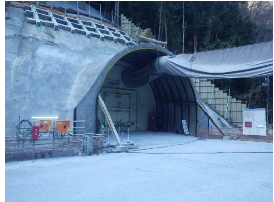
写真 6-5-16 防音扉の設置 (広河原非常口)
