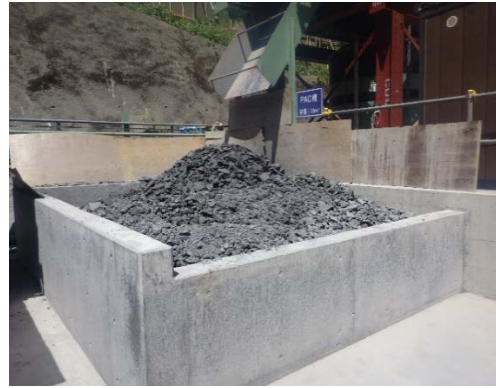
写真 6-5-19 建設汚泥の脱水処理 (早川非常口)
