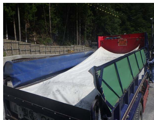
写真 6-7-6 運搬時の浸透防止シート 設置状況
