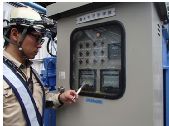
写真6-4-10 工事排水の監視 (濁水処理設備の監視・点検)
