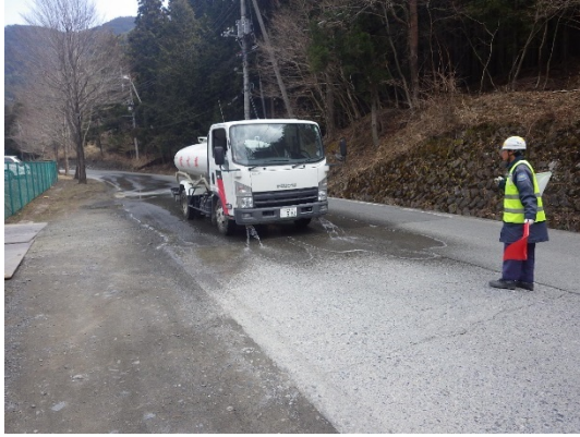
写真 6-5-7 道路への散水
