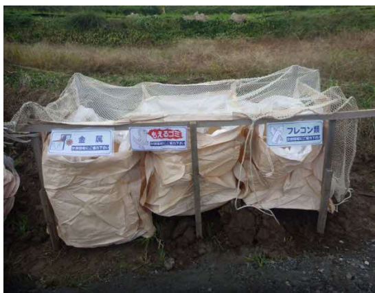
写真6-8-7 建設副産物の分別・再資源化
