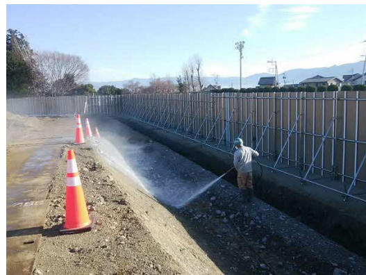
写真6-2-10 粉じん飛散防止剤散布
