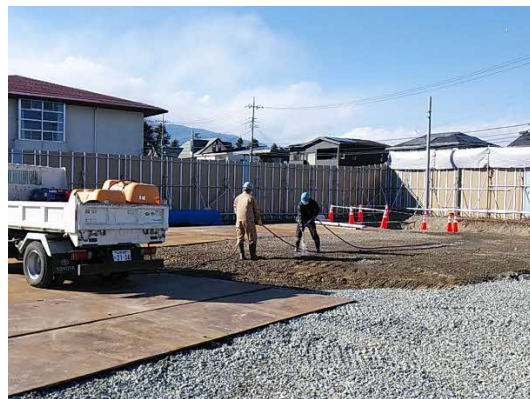
写真6-1-6 粉じん飛散防止剤散布
