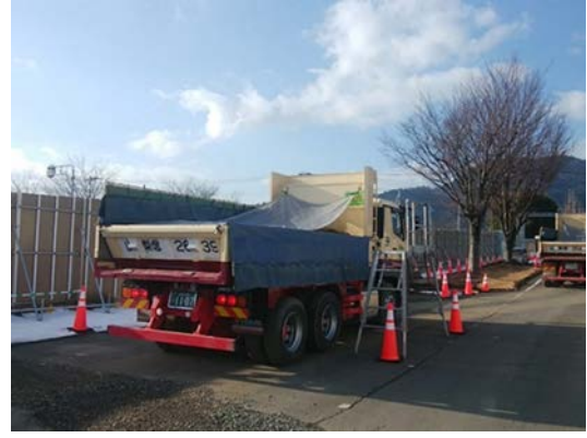
写真6-2-8 防塵シート設置
