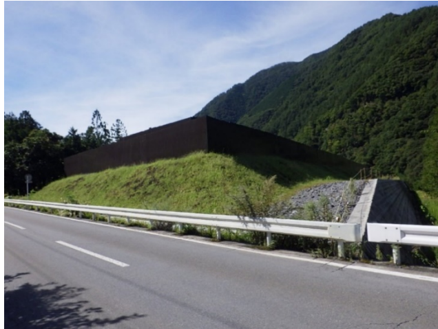
写真 9-5-1 防音パネル、法面植生工（塩島地区発生土置き場）
