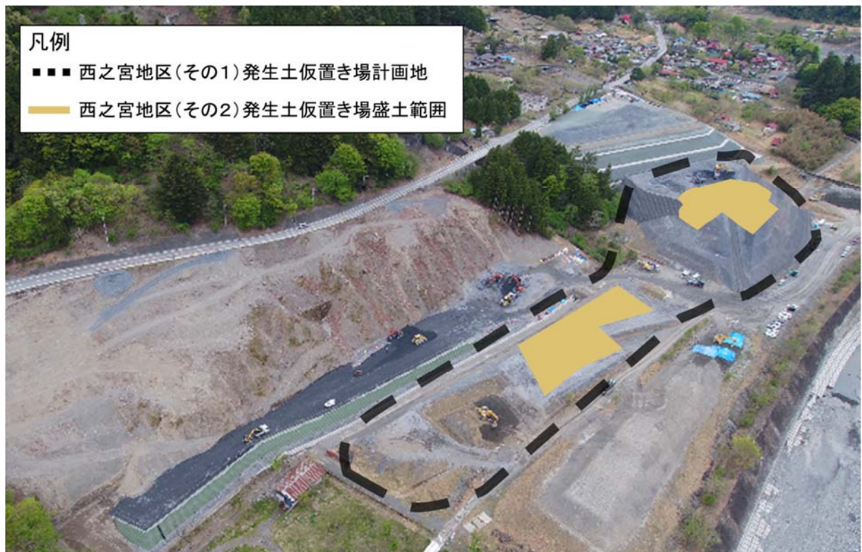
写真 2-1 西之宮地区（その 2）発生土仮置き場計画地（現況）
