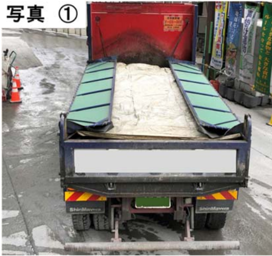
荷台への防じんシート等の設置
