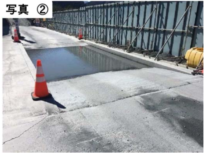
タイヤ洗浄設備の設置
