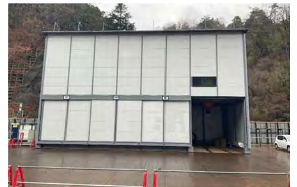
写真 4-1-5-12 防音シート、低騒音型の建設機械の採用、仮囲い・防音シート等の設置による遮音対策 (バッチャープラントへの建屋の設置)
