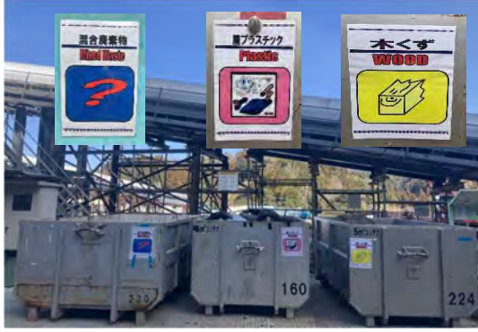
写真 4-1-6-19 副産物の分別、再資源化
