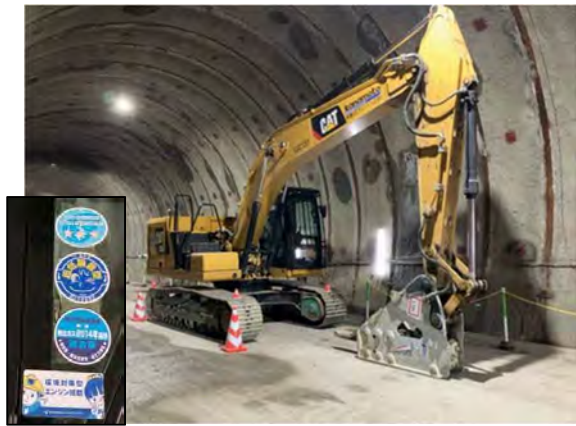
写真 4-1-8-1 排出ガス対策型、低騒音型建設機械の採用
