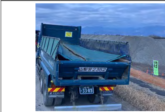
写真 4-1-4-13 荷台への防じんシートの敷設及び散水 (防じんシートの敷設)
