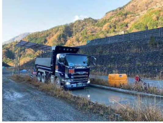
写真 4-1-11-8 資材及び機械の運搬に用いる車両の出入口、周辺道路の清掃及び散水、タイヤの洗浄 (タイヤの洗浄) (西之宮地区(その2)発生土仮置き場)
