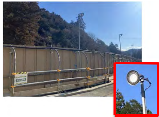
写真 4-1-6-16 照明の漏れ出しの抑制等（昆虫類等の誘引効果が少ない灯具（LED）の採用）
