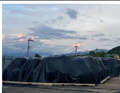
写真 4-1-1-8 仮置き場における掘削土砂の適切な管理
