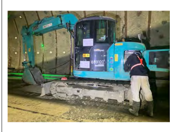
写真 4-1-6-6 建設機械の点検及び整備による性能維持
