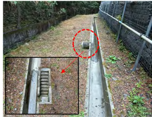
写真 4-1-7-10 小動物が脱出可能な側溝の設 置
