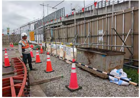
写真 4-1-3-8 副産物の分別、再資源化
