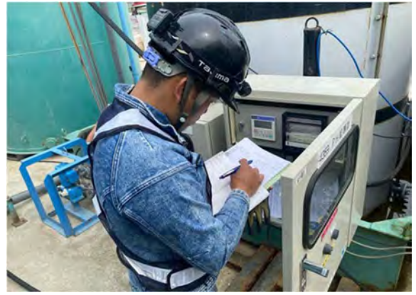
写真 4-1-5-8 工事排水の監視
