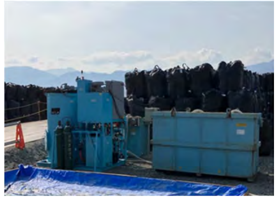
写真 4-1-4-8 河川内工事における工事排水の適切な処理
