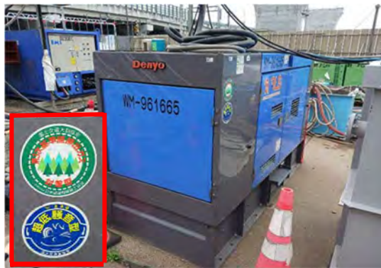
写真 4-1-3-1 排出ガス対策型、低騒音型建設機械の採用
