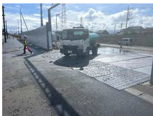
写真 4-1-3-5 工事現場の清掃及び散水
