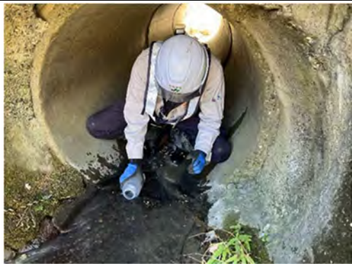
写真 4-1-10-7 工事排水の監視 (塩島地区発生土仮置き場)
