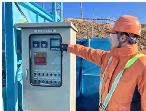
写真 4-1-2-8 工事排水の監視、処理装置の点検・整備による性能維持
