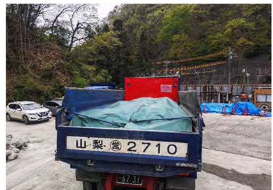
写真 4-1-5-18 荷台への防じんシートの敷設及 び散水 (防じんシートの敷設)
