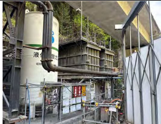
写真 4-1-7-6 工事排水の適切な処理、汚濁処理施設及び仮設沈砂池の設置 (濁水処理施設の設置)
