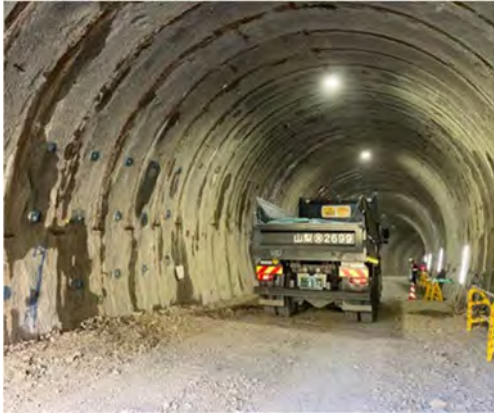
写真 4-1-8-7 荷台への防じんシートの敷設及び散水 (防じんシートの敷設)
