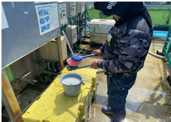
写真 4-1-5-9 処理装置の点検・整備による性能維持
