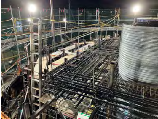
写真 4-1-1-9 照明の漏れ出しの抑制等 (昆虫類等の誘引効果が少ない 灯具 (LED) の採用)
