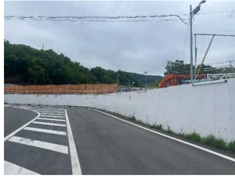
写真 4-1-1-2 仮囲いの設置、仮囲い・防音シート等の設置による遮音対策、低騒音型の建設機械の採用 (仮囲いの設置)
