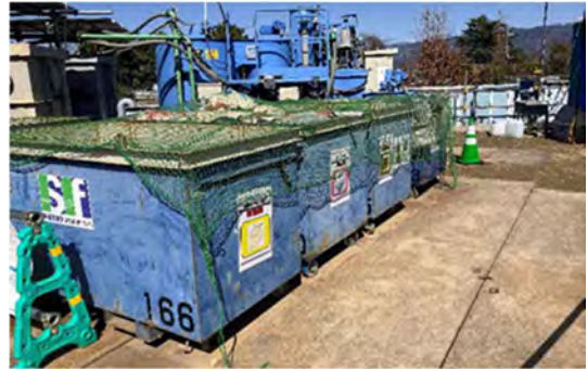
写真 4-1-1-10 副産物の分別、再資源化
