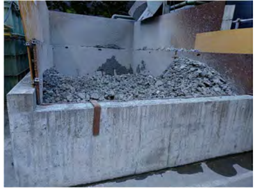
写真 4-1-9-16 建設汚泥の脱水処理
