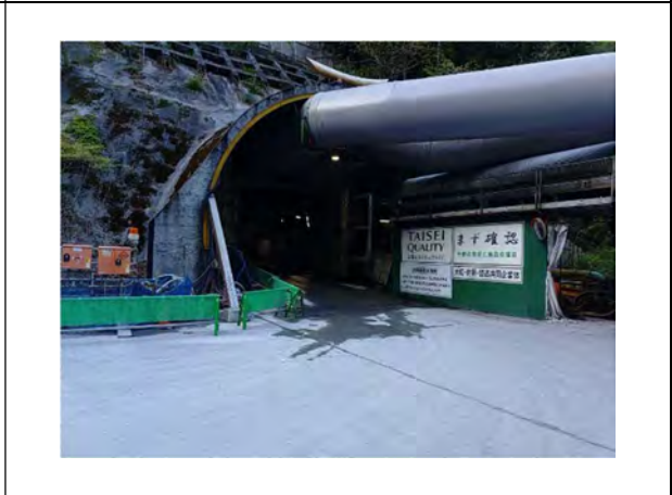
写真 4-1-9-4 仮囲い・防音シート等の設置による遮音対策、防音シート、低騒音型の建設機械の採用 (非常口トンネル坑口への防音扉の設置)
