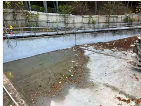
写真 4-1-9-10 仮置き場における掘削土砂の適切な管理
