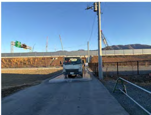
写真 4-1-2-5 工事現場の清掃及び散水
