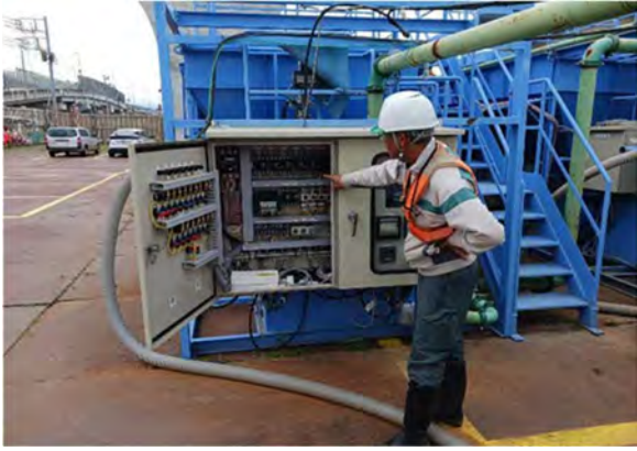
写真 4-1-3-7 工事排水の監視、処理装置の点検・整備による性能維持
