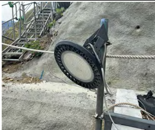
写真 4-1-8-5 照明の漏れ出しの抑制等 (昆虫類等の誘引効果が少ない 灯具 (LED) の採用)
