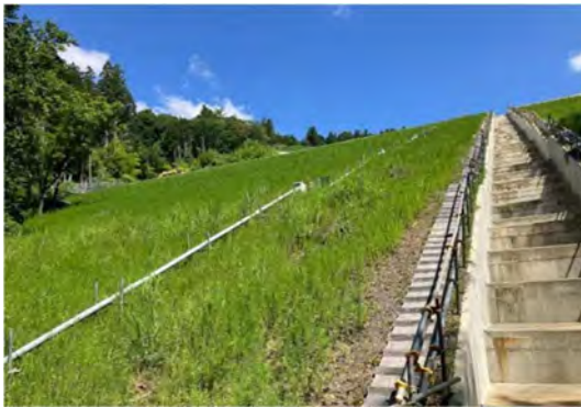
写真 4-1-6-17 外来種の拡大抑制（在来種による法面緑化）
