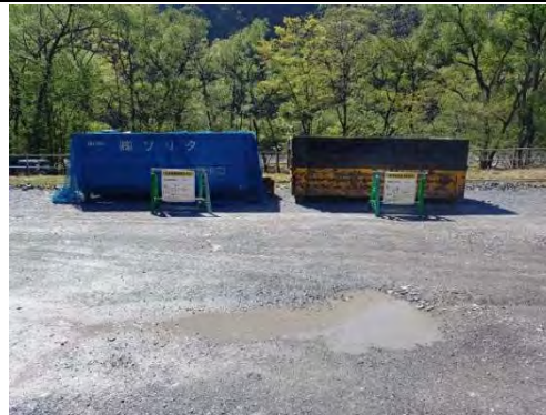
写真 4-1-10-10 副産物の分別、再資源化
