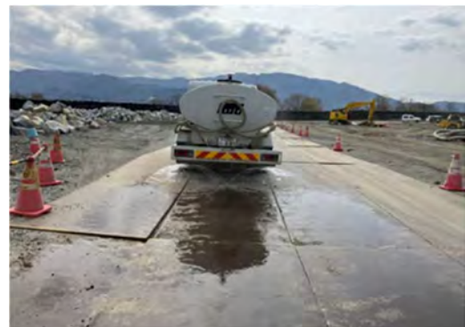
写真 4-1-4-6 工事現場の清掃及び散水
