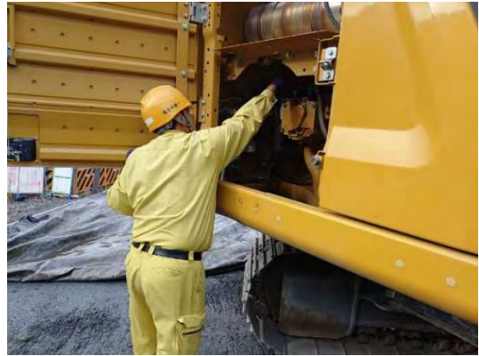
写真 4-1-11-2 建設機械の点検及び整備による性能維持
