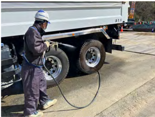
写真 4-1-1-11 資材及び機械の運搬に用いる 車両の出入口、周辺道路の清 掃及び散水、タイヤの洗浄 (タイヤの洗浄)
