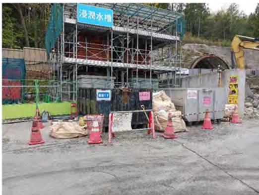
写真 4-1-5-17 副産物の分別、再資源化
