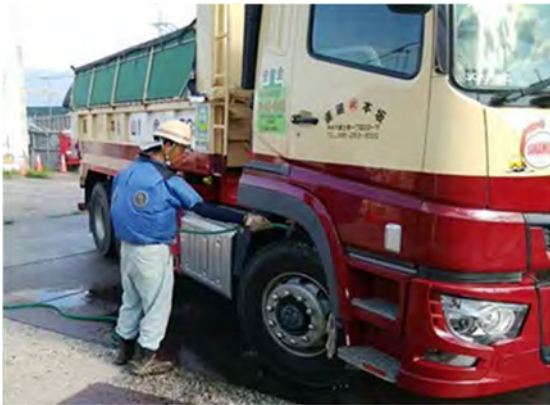
写真 4-1-3-9 資材及び機械の運搬に用いる車両の出入口、周辺道路の清掃及び散水、タイヤの洗浄 (タイヤの洗浄)
