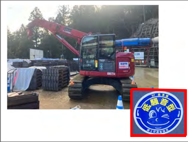
写真 4-1-6-3 防音シート、低騒音型建設機械の採用
