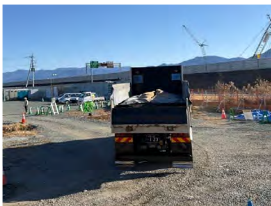
写真 4-1-2-11 荷台への防じんシートの敷設及び散水 (防じんシートの敷設)
