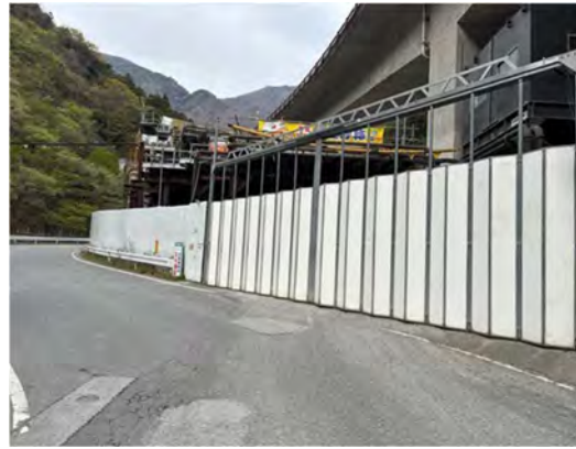
写真 4-1-7-2 仮囲いの設置、仮囲い・防音シート等の設置による遮音対策、低騒音型の建設機械の採用、侵入防止柵の設置
