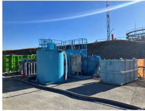
写真 4-1-2-6 工事排水の適切な処理、濁汚濁処理施設及び仮設沈砂池の設置
