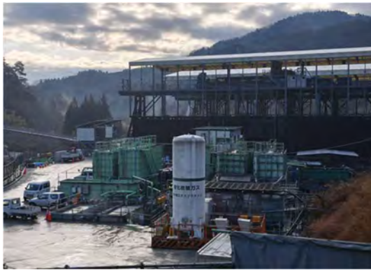
写真 4-1-6-9 工事排水の適切な処理(工事施工ヤード)、汚濁処理施設及び仮設沈砂池の設置
