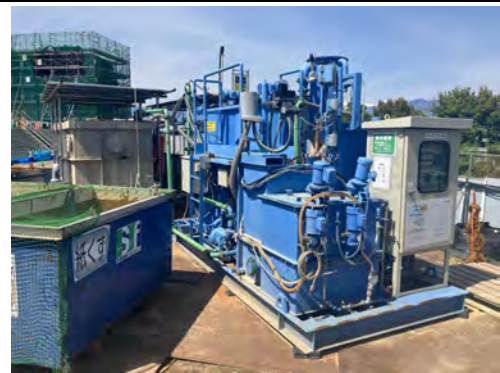
写真 4-1-1-6 工事排水の適切な処理、汚濁処理施設及び仮設沈砂池の設置
