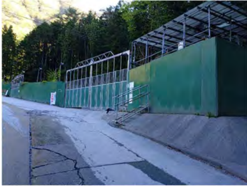
写真 4-1-9-15 仮設物の色合いへの配慮
