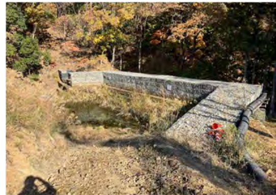
写真 4-1-6-10 工事排水の適切な処理(保守基地・変電所)
