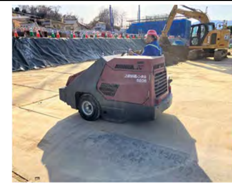
写真 4-1-1-5 工事現場の清掃及び散水
