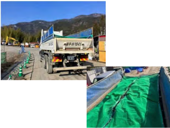
写真 4-1-6-21 荷台への防じんシート敷設及び散水 (防塵シートの敷設)
