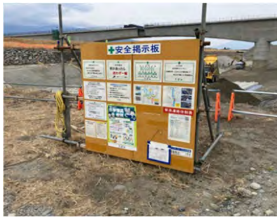
写真 4-1-4-3 建設機械の使用時における配慮
