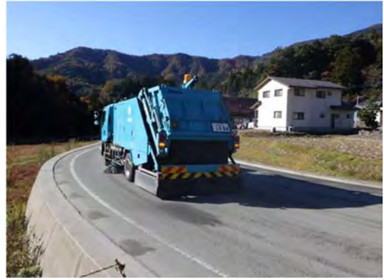
写真 4-1-6-8 工事現場の清掃及び散水
