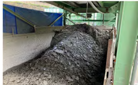
写真 4-1-6-18 建設汚泥の脱水処理
