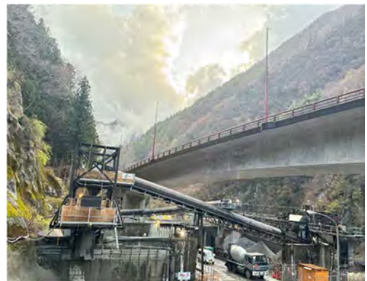
写真 4-1-7-12 仮設物の色合いへの配慮
