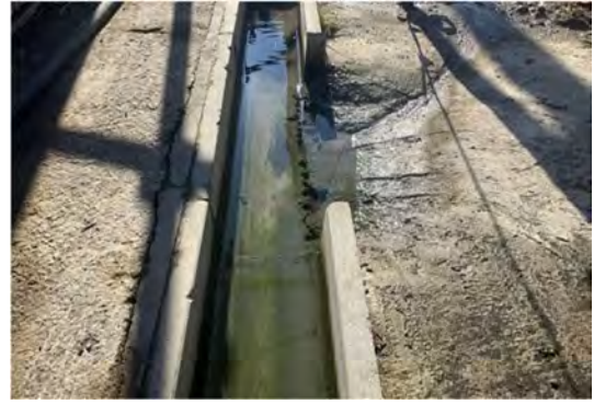
写真 4-1-6-14 小動物が脱出可能な側溝の設置
