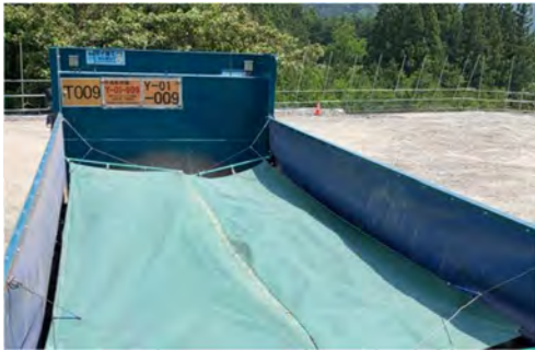
写真 4-1-9-17 荷台への防じんシートの敷設及 び散水 (防じんシートの敷設)
