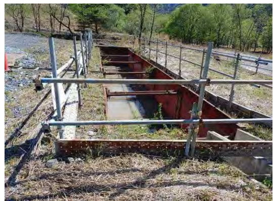
写真 4-1-10-6 工事排水の適切な処理、仮設沈砂池の設置 (仮設沈砂池の設置) (塩島地区(河川側)発生土仮置き場)
