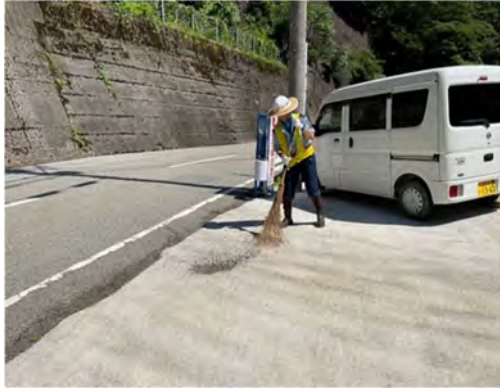
写真 4-1-5-19 資材及び機械の運搬に用いる車両の出入口、周辺道路の清掃及び散水、タイヤの洗浄 (出入口の清掃)
