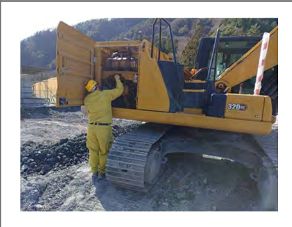
写真 4-1-9-5 建設機械の点検及び整備による性能維持
