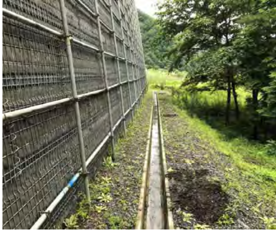
図 参 4-4-1 外周の排水溝の設置 (西之宮地区発生土仮置き場)
