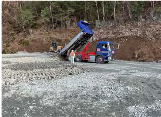
写真 4-1-5-15 建設発生土の再利用
