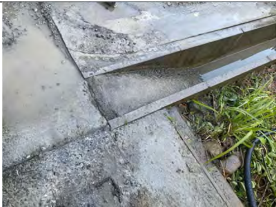
写真 4-1-5-11 小動物が脱出可能な側溝の設置
