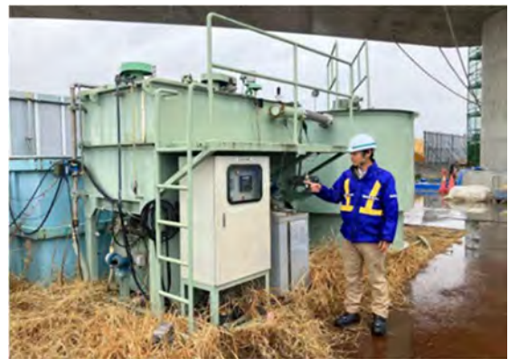
写真 4-1-4-10 工事排水の監視、処理装置の点検・整備による性能維持
