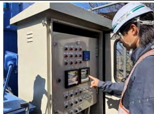
写真 4-1-1-7 工事排水の監視、処理装置の点検・整備による性能維持
