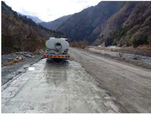
写真 4-1-9-7 工事現場の清掃及び散水、資材及び機械の運搬に用いる車両の出入口、周辺道路の清掃及び散水、タイヤの洗浄 (工所用道路の散水)
