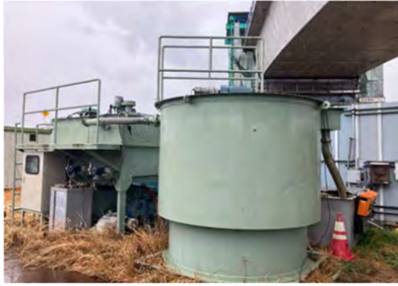
写真 4-1-4-7 工事排水の適切な処理、汚濁処理施設及び仮設沈砂池の設置
