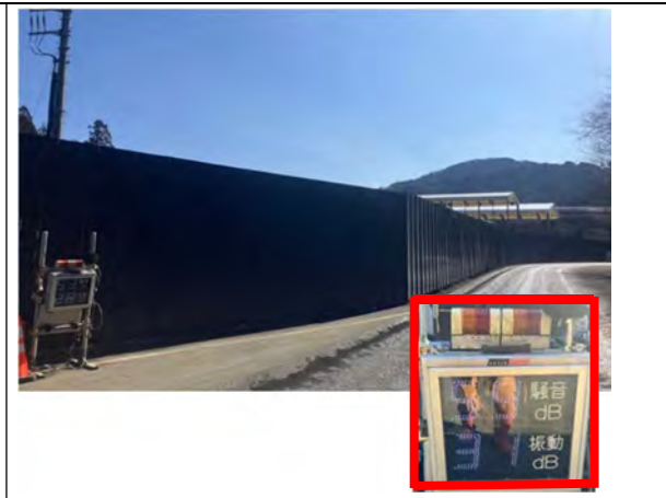
写真 4-1-6-2 仮囲いの設置、仮囲い・防音シート等の設置による遮音対策
