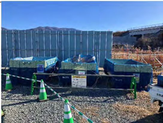
写真 4-1-2-9 副産物の分別、再資源化
