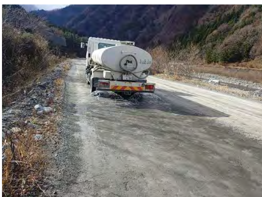
写真 4-1-10-5 工事現場の清掃及び散水、資材及び機械の運搬に用いる車両の出入口、周辺道路の清掃及び散水、タイヤの洗浄 (工事用道路の洗浄)
