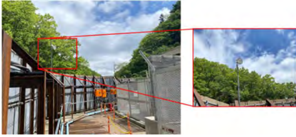
写真 4-1-5-13 照明の漏れ出しの抑制等 (昆虫類等の誘引効果が少ない灯具 (LED) の採用)
