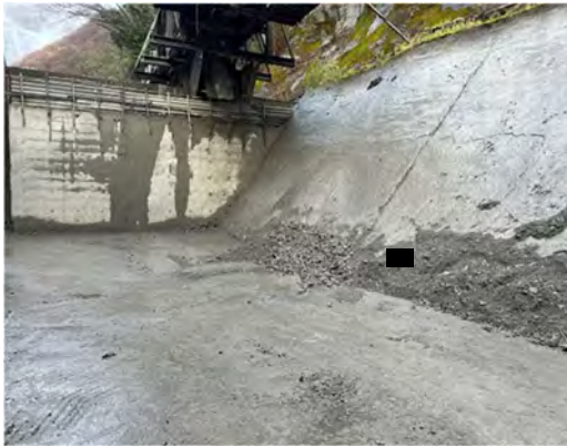
写真 4-1-7-9 仮置き場における掘削土砂の 適切な管理
