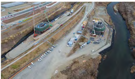
写真 4-1-2-7 仮締切工の実施
