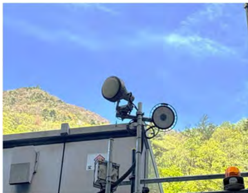
写真 4-1-7-11 照明の漏れ出しの抑制等 (昆虫類等の誘引効果が少な い灯具 (LED) の採用)
