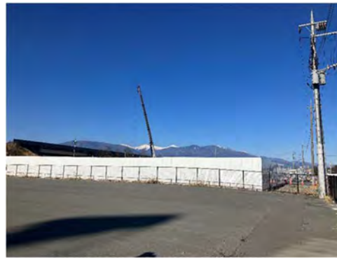
写真 4-1-2-2 仮囲いの設置、仮囲い・防音シート等の設置による遮音対策（仮囲いの設置）
