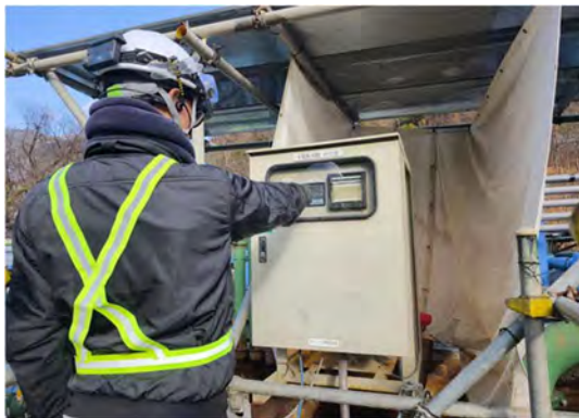
写真 4-1-6-11 工事排水の監視、処理装置又は排水設備の点検・整備による性能維持
