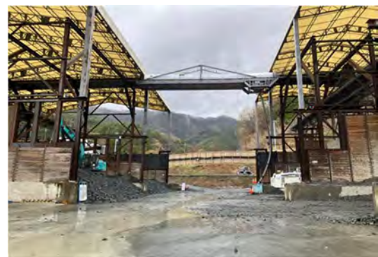
写真 4-1-6-12 仮置き場における掘削土砂の適切な管理
