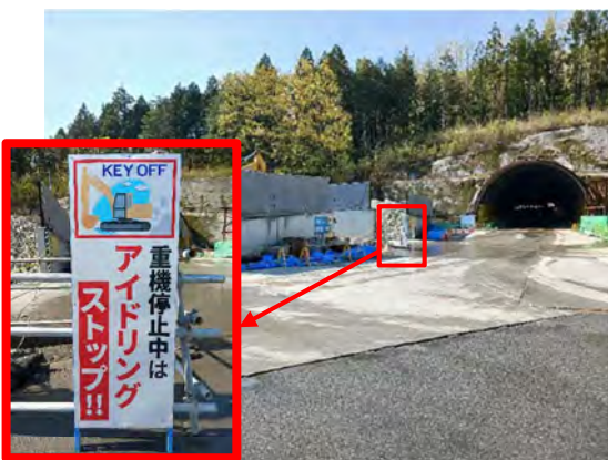
写真 4-1-5-3 建設機械の使用時における配慮
