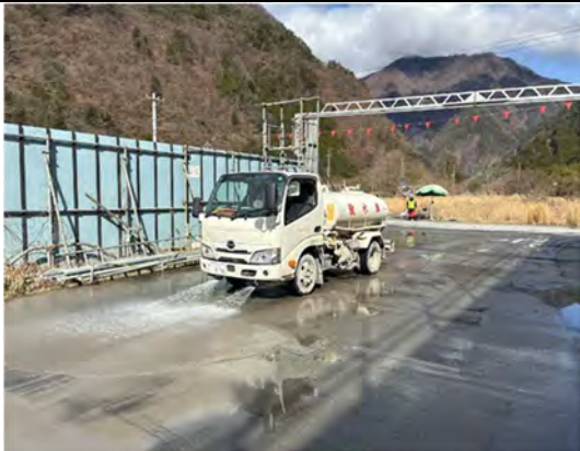
写真 4-1-7-5 工事現場の清掃及び散水
