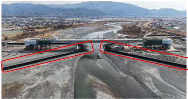
写真 4-1-4-9 仮締切工の実施
