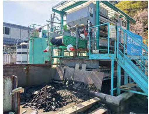
写真 4-1-5-16 建設汚泥の脱水処理
