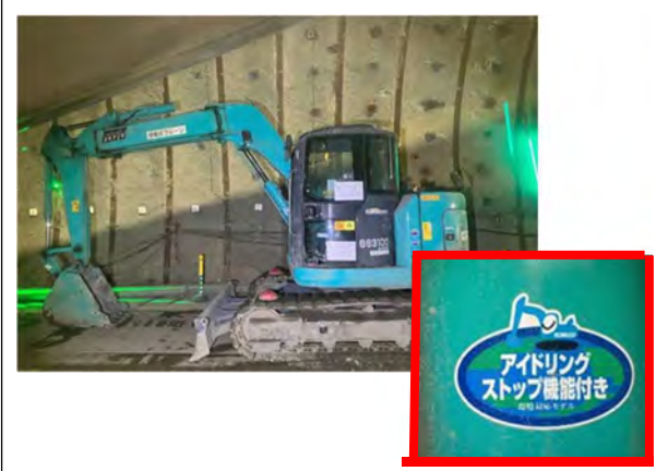
写真 4-1-6-5 建設機械の使用時における配慮
