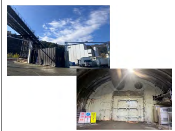
写真 4-1-6-4 仮囲い・防音シート等の設置による遮音対策
