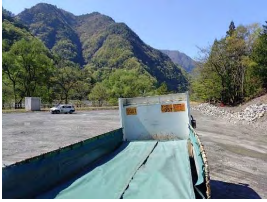
写真 4-1-11-7 区分土の適切な運搬、荷台への防じんシートの敷設及び散水 (防じんシートの敷設)
