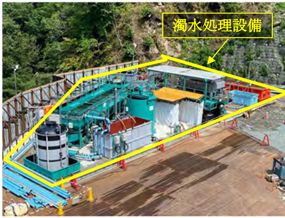
写真 4-1-5-7 工事排水の適切な処理、汚濁処理施設及び仮設沈砂池の設置
