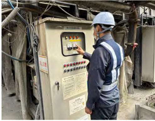
写真 4-1-7-7 工事排水の監視、処理施設の 点検・整備による性能維持
