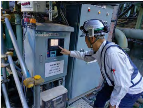
写真 4-1-9-9 工事排水の監視、処理装置の点検・整備による性能維持
