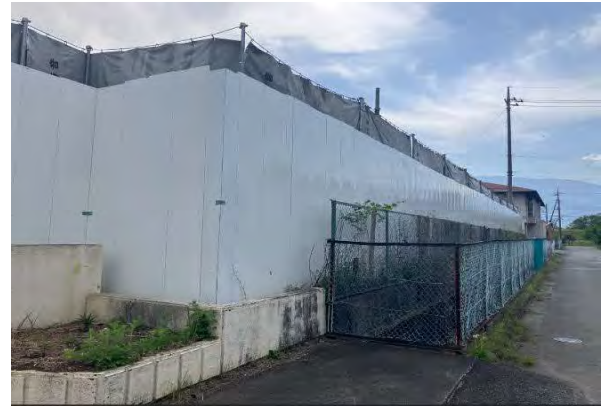
写真 4-1-4-2 仮囲いの設置、仮囲い・防音シート等の設置による遮音対策
