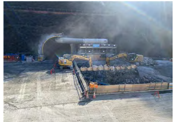
写真 4-1-5-10 仮置き場における掘削土砂の適切な管理
