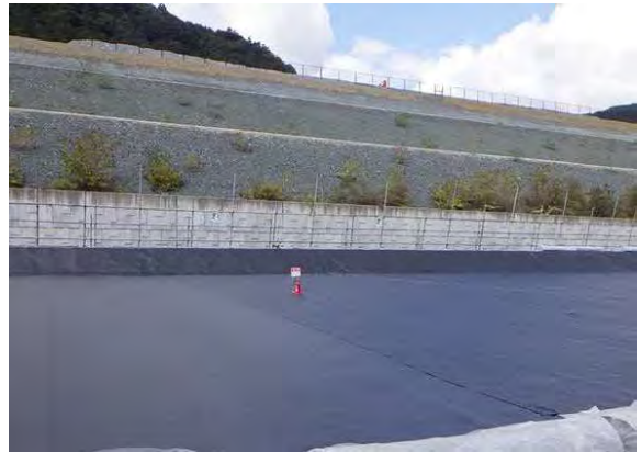
図 参 4-4-4 アスファルトの舗装状況 (西之宮地区(その2)発生土仮置き場)
