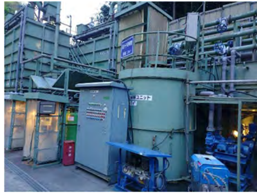
写真 4-1-9-8 工事排水の適切な処理、汚濁処理施設及び仮設沈砂池の設置
