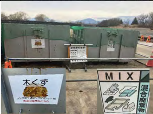
写真 4-1-4-11 副産物の分別、再資源化
