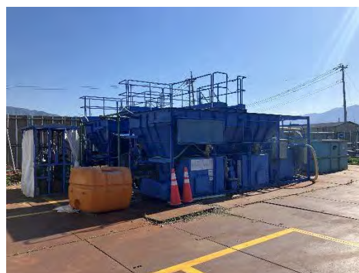
写真 4-1-3-6 工事排水の適切な処理 (濁水処理施設の設置)
