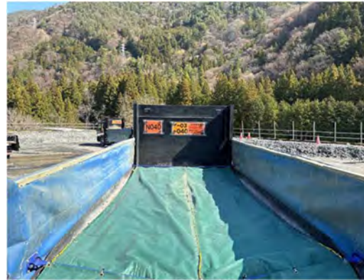
写真4-1-7-14 荷台への防じんシートの敷設及び散水 (防塵シートの敷設)
