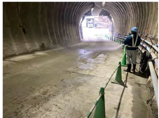
写真 4-1-5-6 工事現場の清掃及び散水
