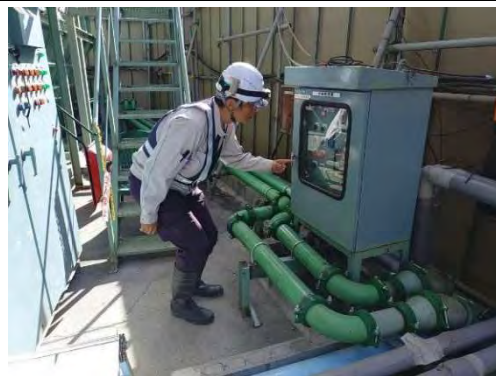
写真 4-1-10-8 工事排水の監視、処理装置の 点検・整備による性能維持
