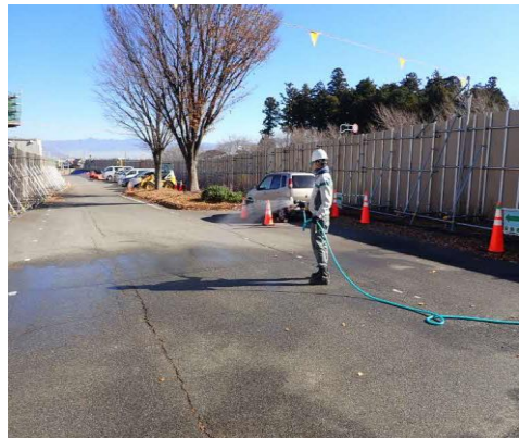
写真4-1-5-6 工事現場の散水
