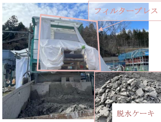
写真4-1-6-17 建設汚泥の脱水処理
