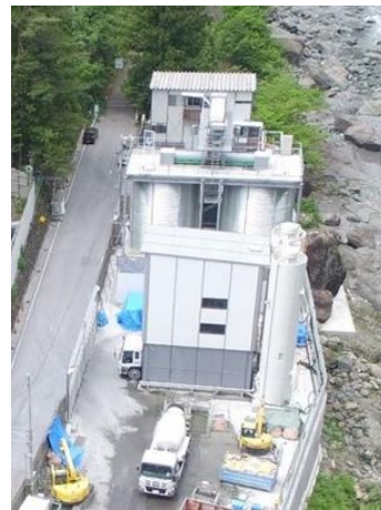
写真 4-1-9-10(1) バッチャープラント建屋設置状況 (早川非常口)
