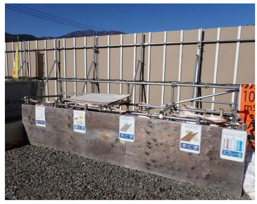
写真4-1-5-10 建設副産物の分別・再資源化
