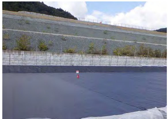
図 参 4-4-4 アスファルトの舗装状況 (西之宮地区(その2)発生土仮置き場)
