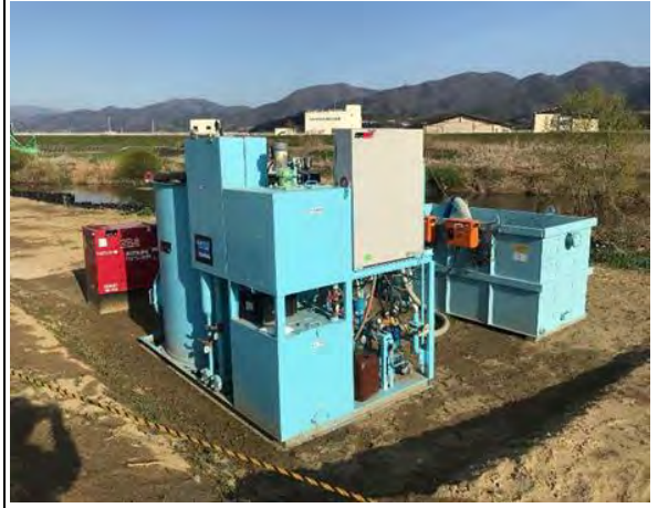
写真 4-1-1-8 濁水処置設備の設置状況
