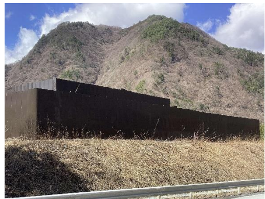
写真 4-1-10-4 仮囲いの設置状況 (塩島地区発生土置き場)
