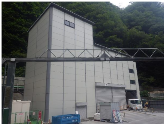
写真 4-1-9-10(2) バッチャープラント建屋設置状況 (広河原非常口)
