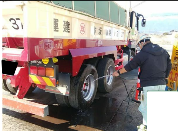
写真4-1-3-6 資材及び機械の運搬に用いる車両のタイヤの洗浄
