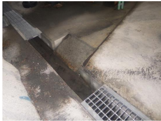
写真 4-1-9-15 小動物が脱出可能な側溝 (広河原非常口)
