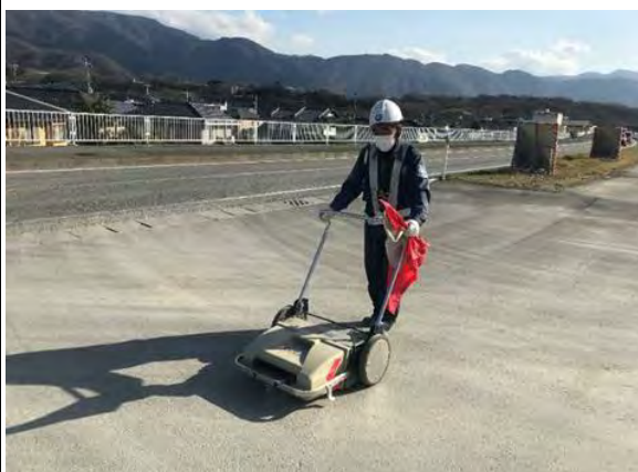
写真4-1-1-6 車両出入口の清掃状況
