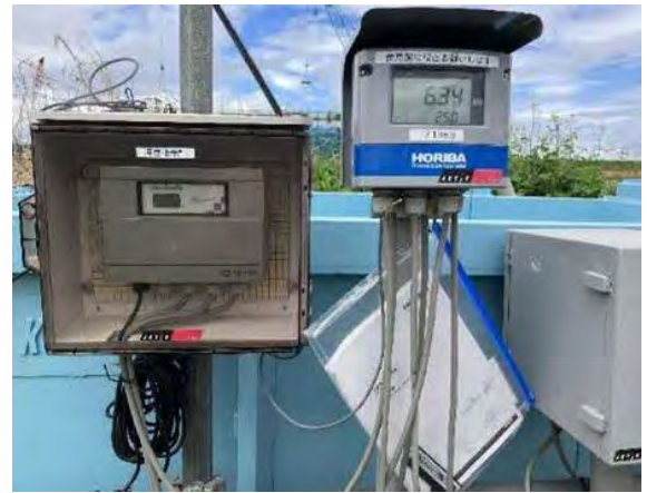
写真 4-1-1-10 工事排水の監視状況
