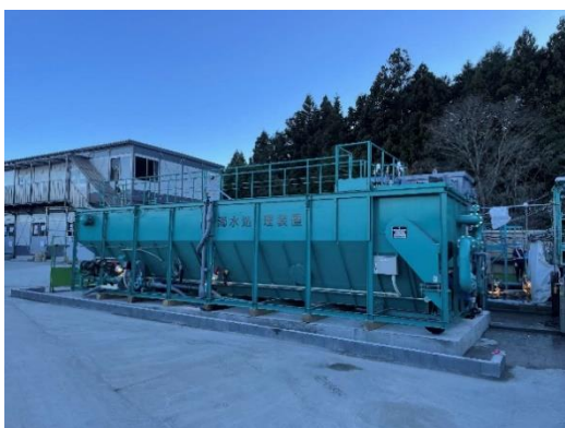
写真4-1-6-9 工事排水の適切な処理
