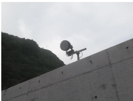
写真4-1-8-13 (2) 照明の漏れ出しの抑制 (LED照明の採用)
