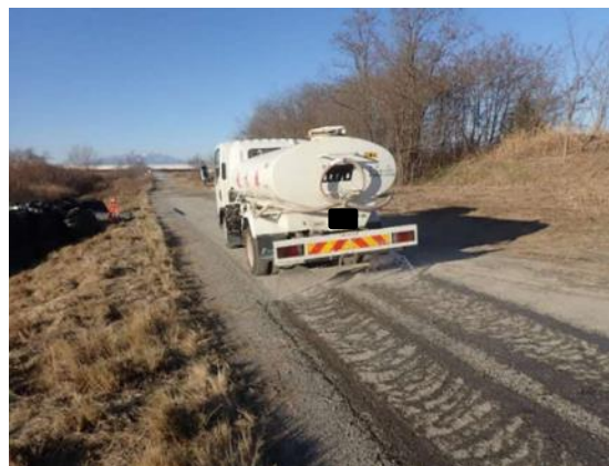
写真4-1-4-6 河川内道路への散水
