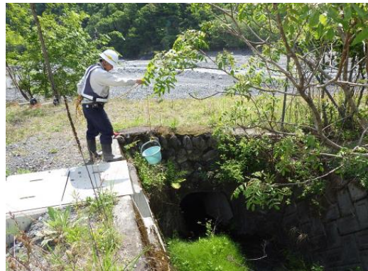
写真 4-1-10-6 工事排水の監視 (塩島地区発生土置き場)
