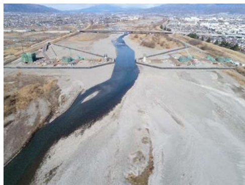
写真4-1-4-11 (1) 仮締切工の実施
