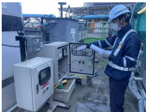
写真4-1-6-10 工事排水の監視
