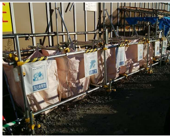
写真4-1-3-10 副産物の分別・再資源化
