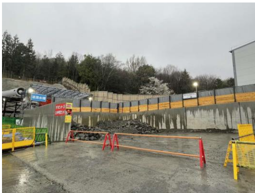
写真4-1-6-15 LED灯の設置状況
