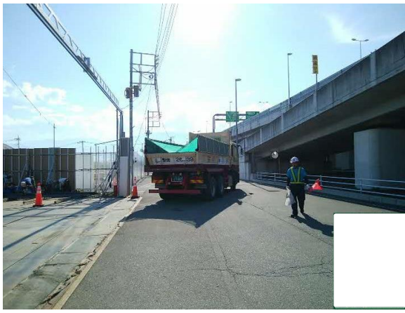
写真4-1-3-7 荷台への防塵シートの敷設
