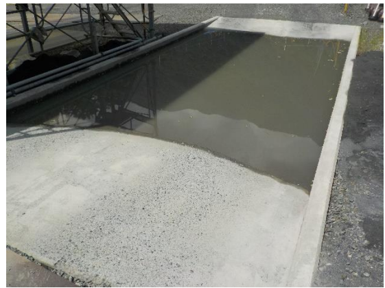
写真 4-1-11-4 タイヤ洗浄プールの 設置状況 (塩島(南)発生土仮置き場)
