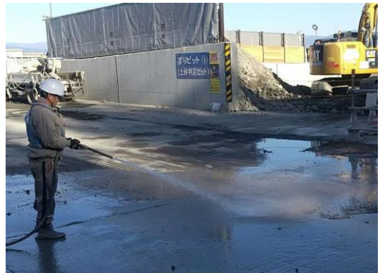
写真4-1-6-6 工事現場の散水
