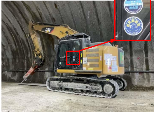
写真4-1-6-1 排出ガス対策型・低騒音型建設機械の採用
