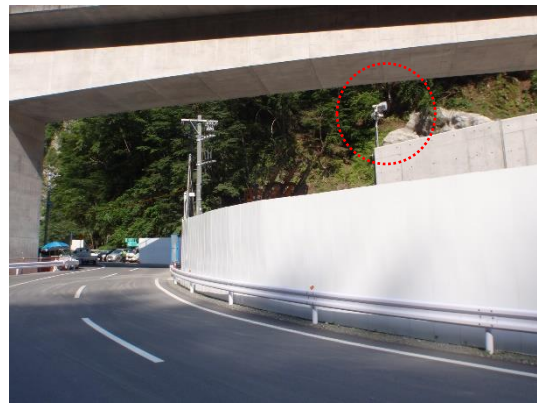
写真4-1-8-13 (1) LED照明による照明の 漏れ出しの抑制
