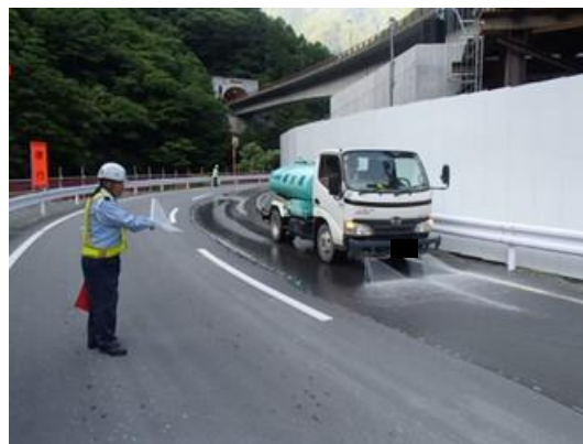
写真 4-1-8-8 周辺道路の散水
