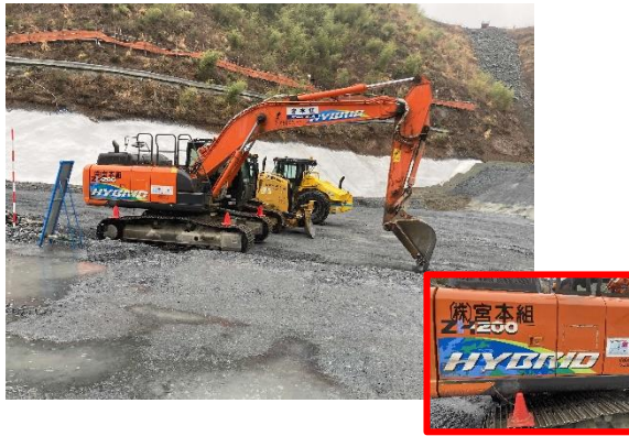
写真 4-1-7-17 低炭素型建設機械の採用
