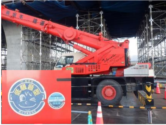
写真4-1-4-1 排出ガス対策型・低騒音型 機械の採用
