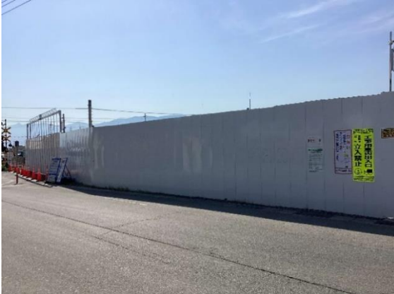
写真4-1-3-4 仮囲いの設置状況
