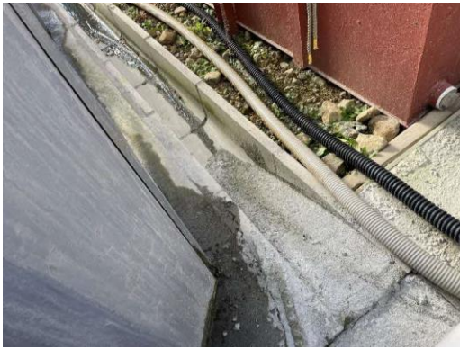
写真4-1-6-13 小動物が脱出可能な側溝の設置状況
