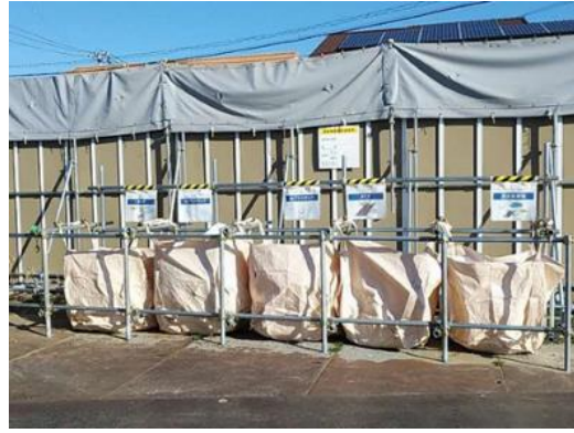
写真4-1-4-13 副産物の分別、再資源化
