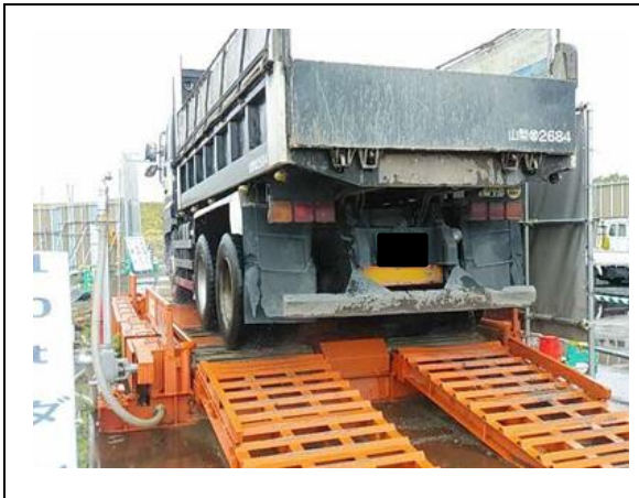
写真4-1-4-7 タイヤ洗浄 (乾式スパッツ)
