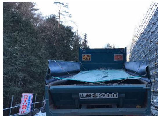
写真 4-1-8-6 運搬時の防じんシート 設置状況
