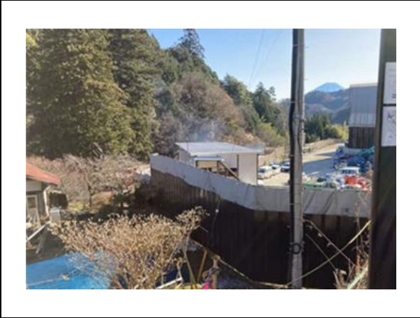
写真4-1-7-5 仮囲い、防音シートの 設置状況
