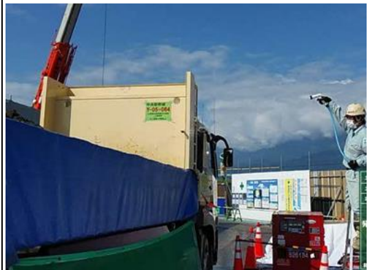
写真4-1-4-8 荷台への防塵シートの敷設及び散水
