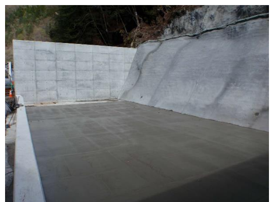
写真4-1-8-11 土砂ピットにおける掘削土砂の適切な管理状況（底盤及び周囲のコンクリート打設）
