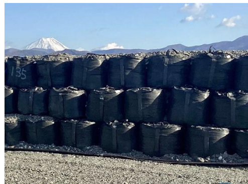
写真4-1-4-11 (2) 仮締切工の実施
