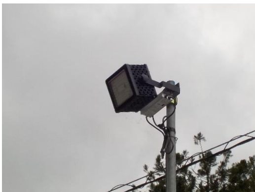
写真4-1-9-16 照明の漏れ出しの抑制 (LED照明の採用) (早川非常口)
