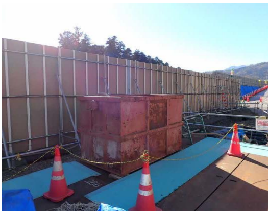
写真4-1-5-9 濁水処理施設の設置状況
