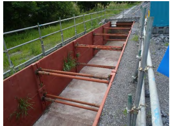
図 参 4-4-2 仮設沈砂池の設置 (塩島地区(河川側)発生土仮置き場)
