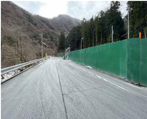
写真 4-1-9-14 侵入防止柵（仮囲い）の設置状況 (広河原非常口)
