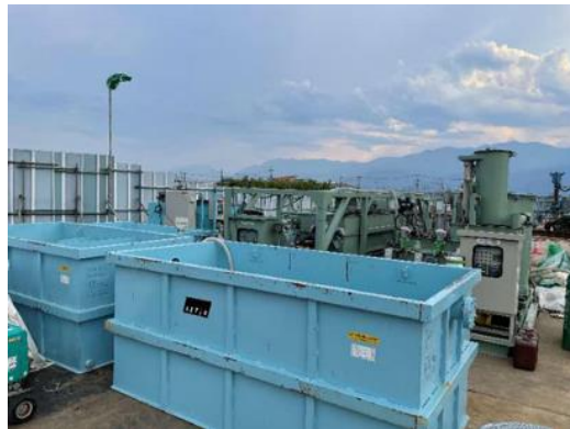
写真4-1-4-9 濁水処理施設の設置状況
