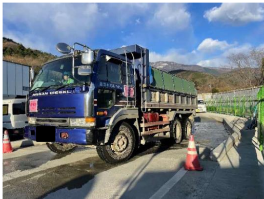
写真4-1-6-8 資材及び機械の運搬に用いる 車両の出入口、周辺道路の清掃 及び散水、タイヤの洗浄
