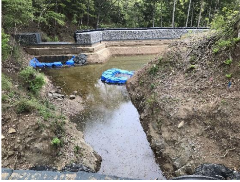
写真 4-1-7-13 仮設沈砂池の設置
