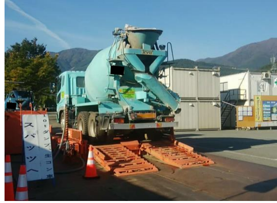
写真4-1-5-8 タイヤ洗浄(湿式スパッツ)
