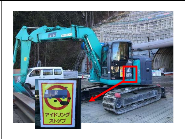
写真4-1-7-2 建設機械の使用時における配慮 の実施状況
