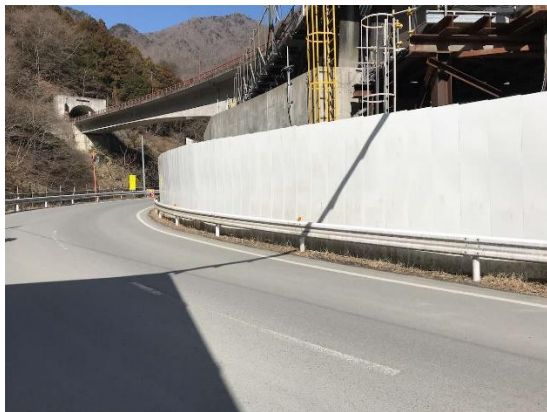
写真4-1-8-5 仮囲いの設置状況
