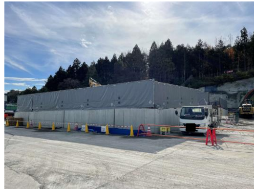
写真4-1-6-14 防音シートの採用管理
