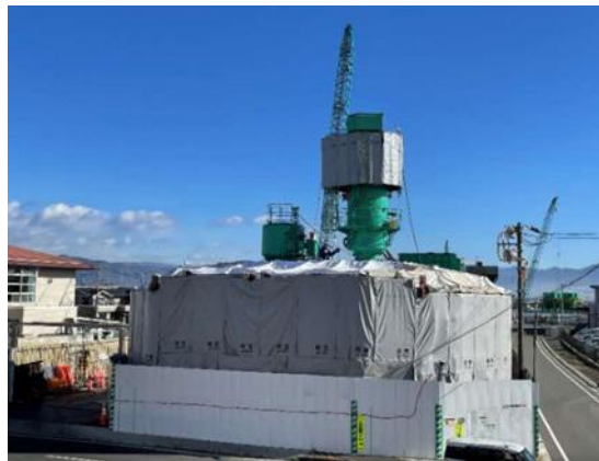
写真4-1-4-5 仮囲い・防音シートの 設置状況
