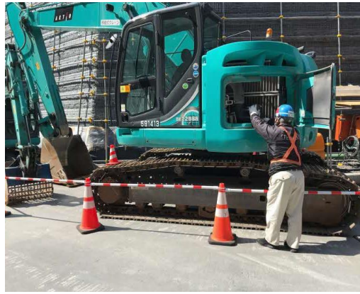
写真4-1-8-2 建設機械の点検及び整備
