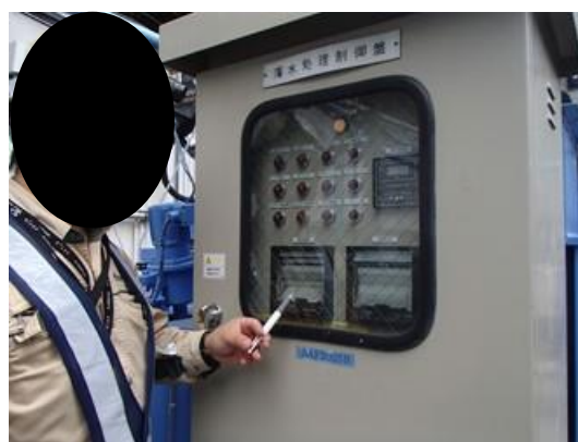
写真4-1-8-10 工事排水の監視
