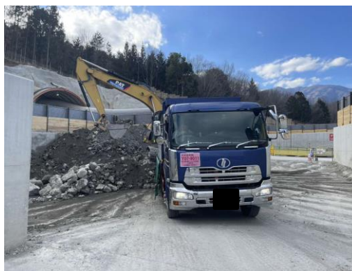
写真4-1-6-12 掘削土砂の適切な管理（底盤 及び周辺のコンクリート打設）
