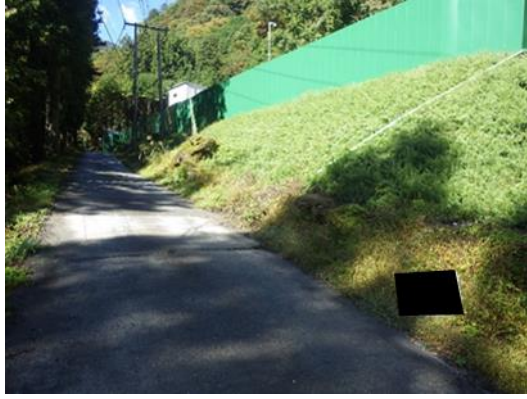
写真 4-1-9-18 のり面の緑化（広河原非常口）
