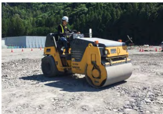
図 参 4-4-5 締固め状況 (中洲地区(その2)発生土仮置き場)
