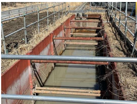
写真 4-1-10-5 沈砂池の設置状況 (塩島地区(河川側)発生土仮置き場)
