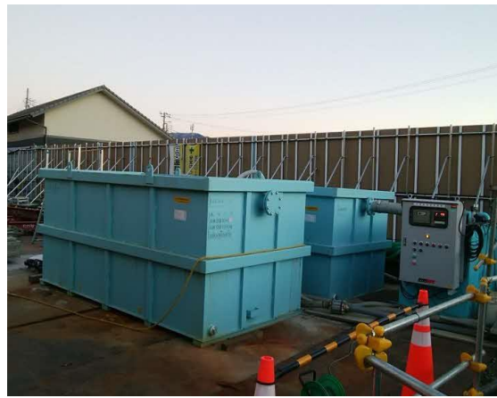
写真4-1-3-8 濁水処理施設の設置状況
