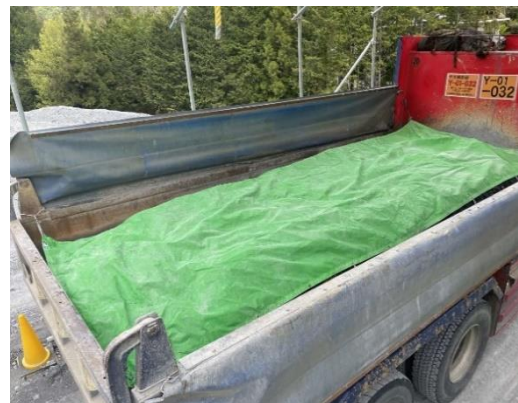
写真 4-1-9-6 運搬時の防じんシート 設置状況
