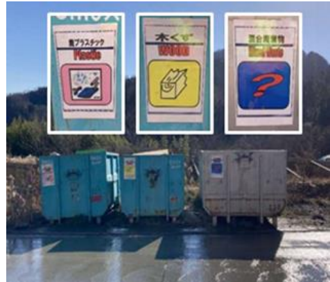
写真 4-1-7-16 副産物の分別、再資源化
