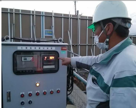
写真4-1-3-9 工事排水の監視及び、排水設備の点検
