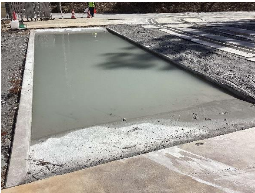
写真 4-1-10-3 タイヤ洗浄プールの 設置状況 (塩島地区(河川側)発生土仮置き場)
