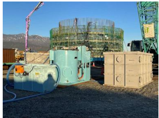
写真4-1-4-10 河川内工事の適切な排水処理
