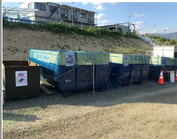
写真 4-1-1-11 副産物の分別、再資源化
