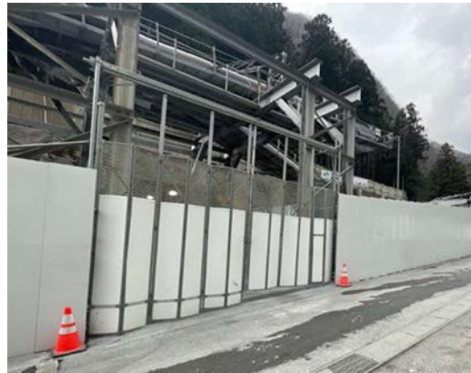
写真 4-1-9-4 仮囲いの設置状況 (早川非常口)
