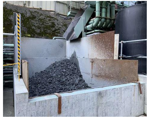
写真 4-1-9-19 建設汚泥の脱水処理 （早川非常口）
