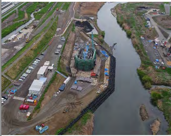
写真 4-1-1-9 仮締切工の実施状況
