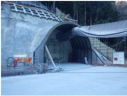
写真 4-1-9-9 防音扉の設置状況 (広河原非常口)
