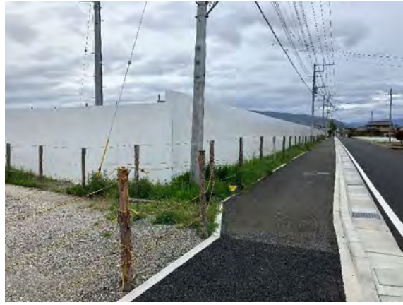
写真4-1-1-4 仮囲い設置状況
