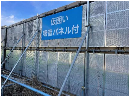
写真4-1-6-5 仮囲い、防音シートの設置状況
