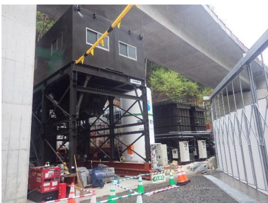
写真4-1-8-9 濁水処理施設の設置状況
