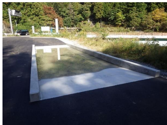
写真 4-1-9-17 外来種の拡大抑制のための タイヤ洗浄 (広河原非常口入口)
