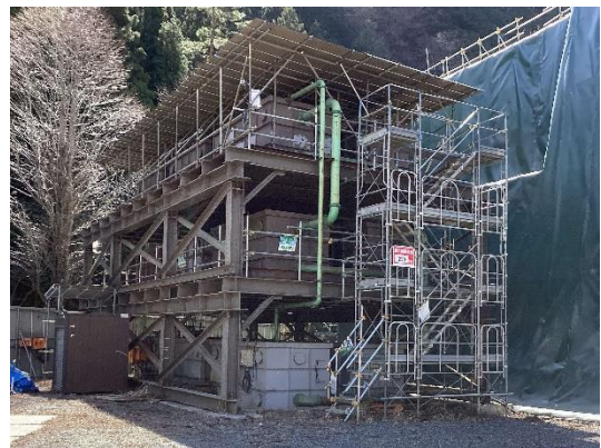
写真 4-1-11-6 浸潤水用水槽の設置状況 (塩島(下流)発生土仮置き場)
