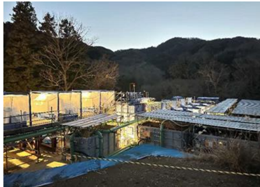
写真4-1-7-10 濁水処理施設の設置状況
