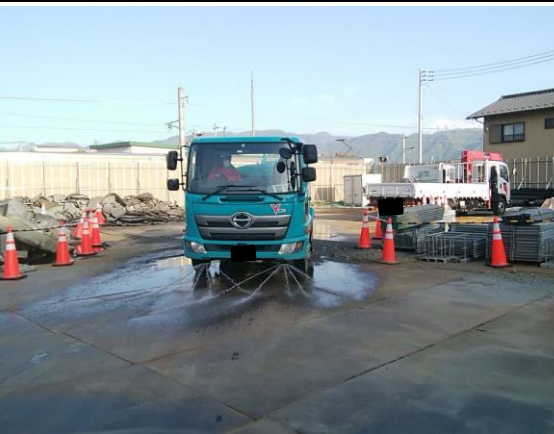
写真4-1-3-5 工事現場の散水状況
