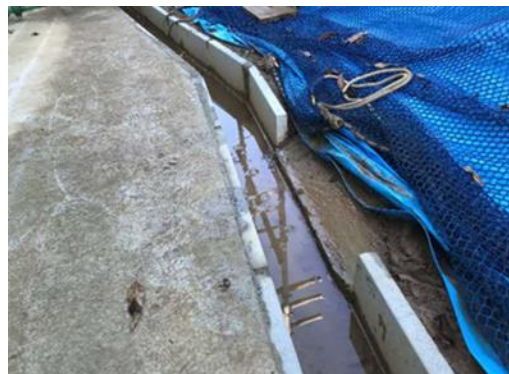
写真 4-1-7-12 小動物が脱出可能な側溝の設置状況
