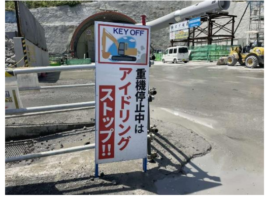
写真4-1-6-2 建設機械の使用時における配慮
