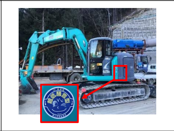
写真4-1-7-4 低騒音型建設機械の採用
