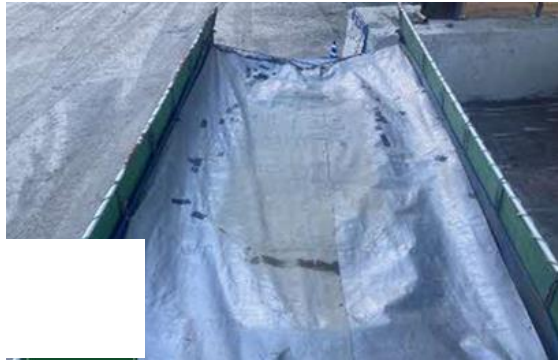
写真4-1-7-8 荷台への防塵シート敷設
