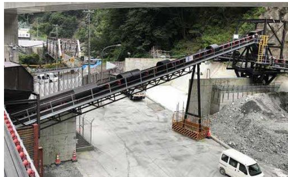
写真4-1-8-14 仮設物の色合いへの配慮 (ベルトコンベアー)
