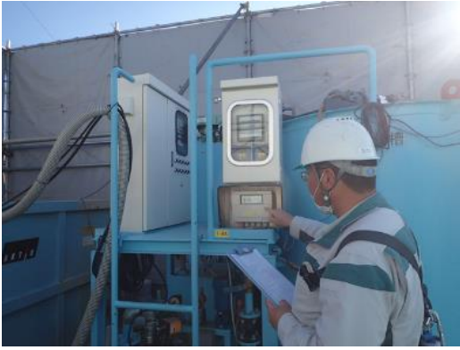
写真4-1-4-12 工事排水の監視及び、排水設備の点検
