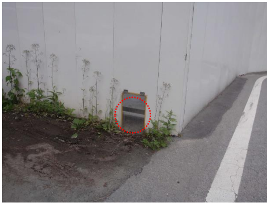
写真4-1-8-12(2) 小動物が脱出可能な仮囲い
