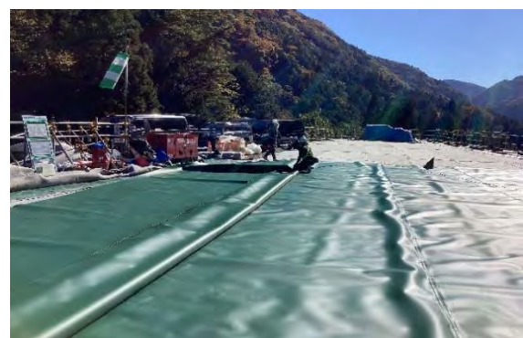
図 参 4-4-6 遮水シート設置状況 (湯島地区(田島)発生土仮置き場)
