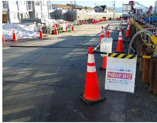
写真4-1-4-2 建設機械の使用時における配慮
