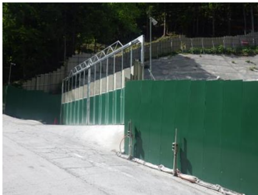
写真 4-1-9-5 仮設物の色合いへの配慮 (広河原非常口仮囲い)
