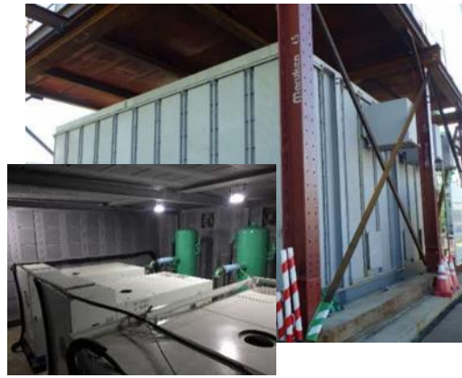
写真4-1-4-15 空気圧縮機の防音ハウス内への設置
