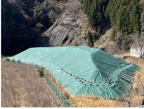
写真 4-1-11-7 遮水シートの設置状況 (雨畑発生土仮置き場)
