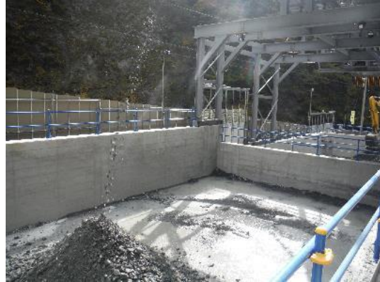
写真 4-1-9-13 土砂ピットにおける掘削土砂管理 (底盤及び周囲のコンクリート打設) (早川非常口)
