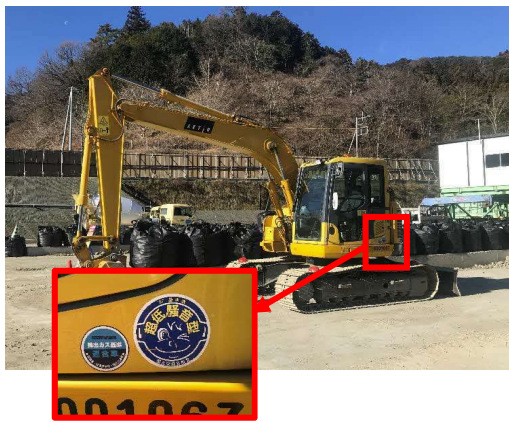
写真4-1-6-3 低騒音型建設機械の採用
