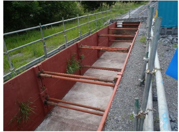
図 参 6-3-2 仮設沈砂池の設置 (塩島地区(河川側)発生土仮置き場)
