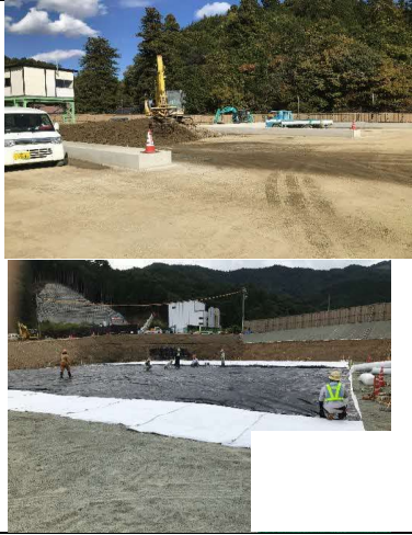
写真 4-1-6-13 掘削土砂の適切な管理
