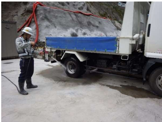
写真 4-1-8-9 外来種の拡大抑制のための タイヤ洗浄
