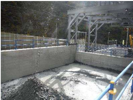
写真 4-1-8-14 土砂ピットにおける 掘削土砂管理 (底盤及び周囲のコンクリート打設) (早川非常口)
