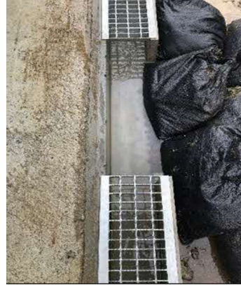
写真 4-1-6-14 小動物が脱出可能な側溝の設置
