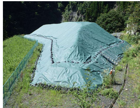
図 参 6-3-6 遮水シート設置状況 (雨畑地区発生土仮置き場)
