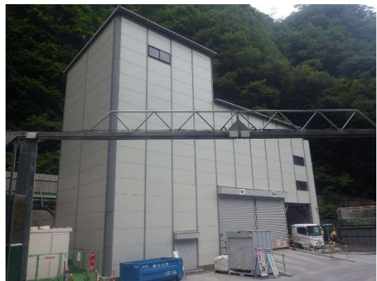
写真 4-1-8-11(2) バッチャープラント建屋設置状況 (広河原非常口)
