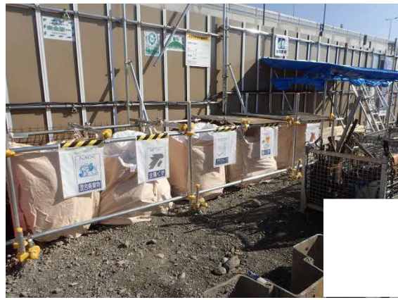
写真4-1-2-6 副産物の分別・再資源化
