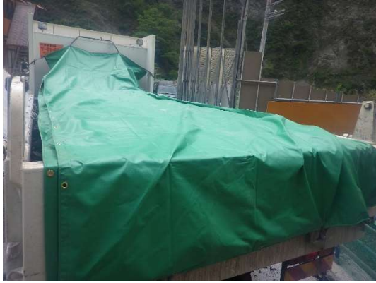
写真 4-1-8-7 運搬時の防じんシート 設置状況
