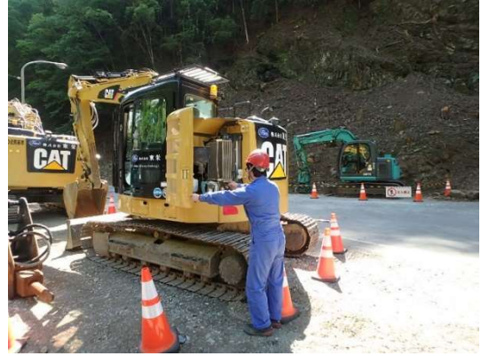
写真4-1-7-2 建設機械の点検・整備
