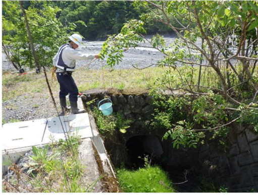
写真 4-1-9-7 工事排水の監視 (塩島地区発生土置き場)
