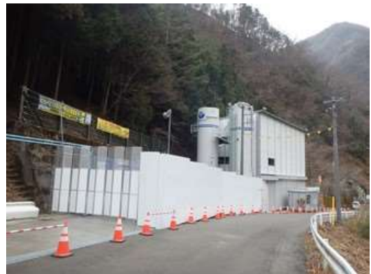
写真4-1-7-5(2) 仮囲いの設置状況
