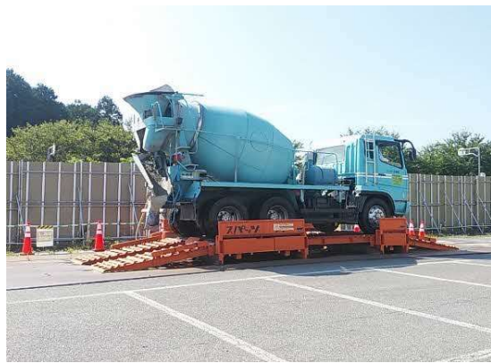
写真4-1-4-9 (2) タイヤ洗浄(湿式スパッツ)
