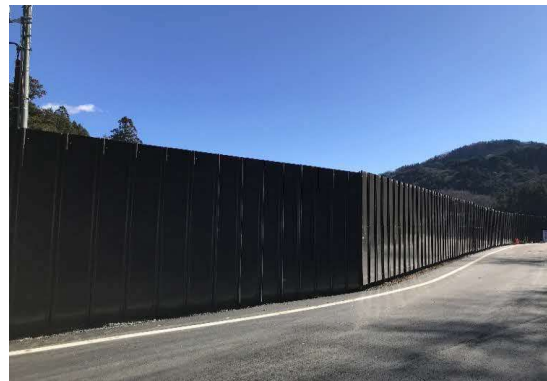
写真4-1-6-4 仮囲い等の設置
