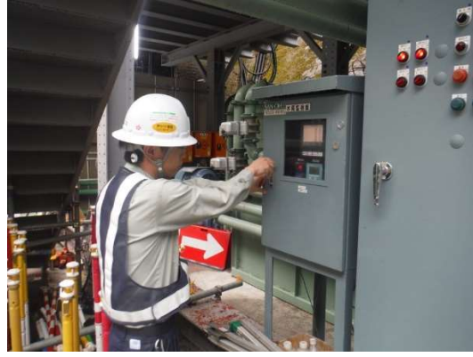
写真 4-1-8-13 工事排水の監視 (濁水処理設備の監視・点検)
