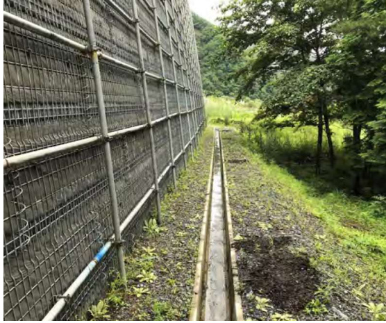
図 参 6-3-1 外周の排水溝の設置 (西之宮地区発生土仮置き場)
