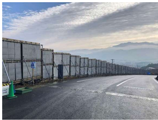
写真4-1-5-9 仮囲い・防音シートなどの設置による遮音対策
