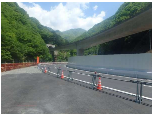
写真4-1-7-5 (1) 仮囲いの設置状況
