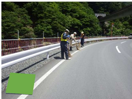
写真4-1-7-6 工事現場周辺の清掃
