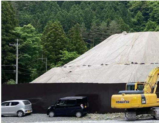
図 参 6-3-3 盛土の安定性 (湯島地区(南草里)発生土仮置き場)
