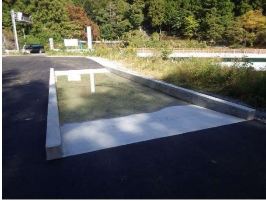
写真 4-1-8-18 外来種の拡大抑制のための タイヤ洗浄 (広河原非常口入口)
