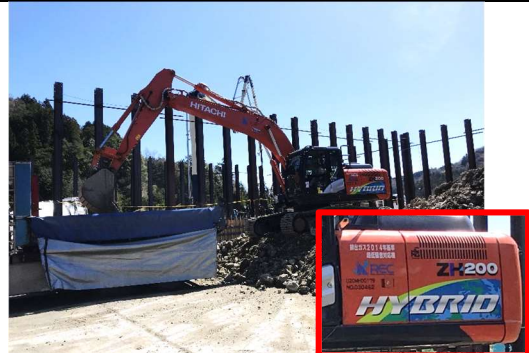
写真 4-1-6-18 低炭素型建設機械の採用
