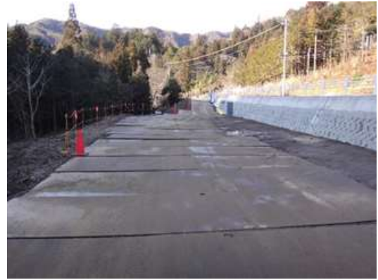
写真4-1-6-8 敷鉄板設置による粉じん抑制状況
