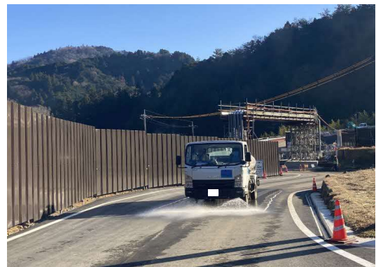
写真4-1-6-10 資材及び機械の運搬に用いる車両の出入り口、周辺道路の清掃及び散水、タイヤの洗浄
