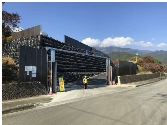
写真4-1-5-5 仮囲いの設置
