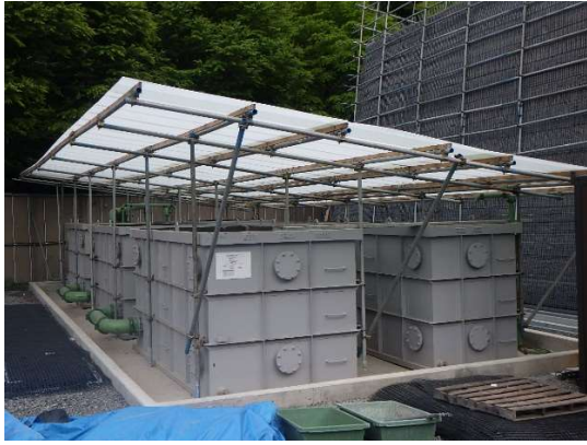
写真 4-1-10-7 浸潤水用水槽の設置状況 (塩島 (下流) 発生土仮置き場)
