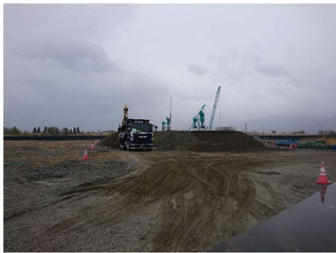
写真4-1-3-13 掘削土砂の適切な管理
