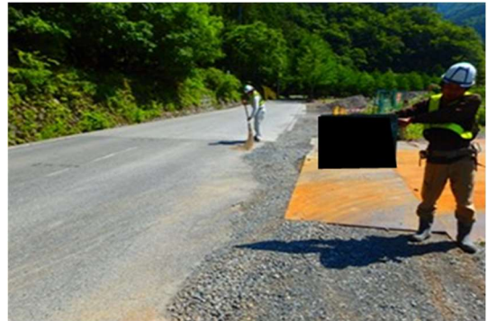
写真 4-1-10-4 清掃実施状況 (塩島地区(南)発生土仮置き場)
