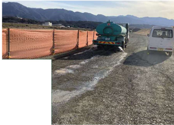
写真4-1-1-4 工事現場の清掃及び散水
