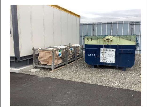
写真4-1-1-7 副産物の分別、再資源化
