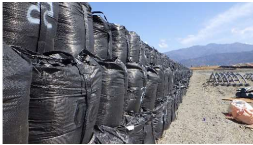
写真4-1-3-11 仮締切工の実施 (2)
