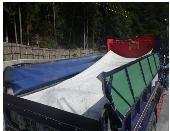
写真 4-1-10-6 運搬時の防じんシート等 設置状況
