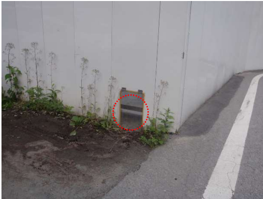
写真4-1-7-13(2) 小動物が脱出可能な側溝
