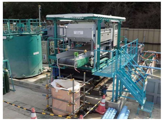
写真4-1-5-19 建設汚泥の脱水処理
