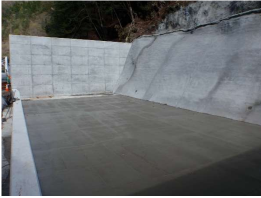
写真4-1-7-12 土砂ピットにおける掘削 土砂の管理（底盤及び周囲 のコンクリート打設）
