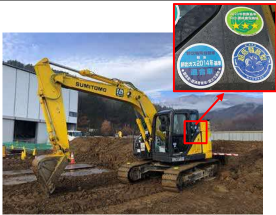
写真4-1-5-1 排出ガス対策型・低騒音型建設機械の採用
