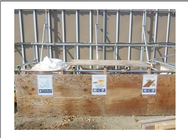
写真4-1-4-12 建設副産物の分別・再資源化
