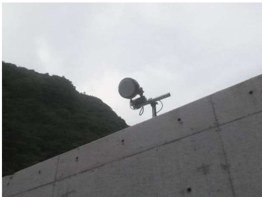
写真4-1-7-14 (2) LED照明による照明 の漏れ出しの抑制
