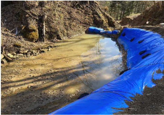
写真 4-1-6-15 仮設沈砂池の設置
