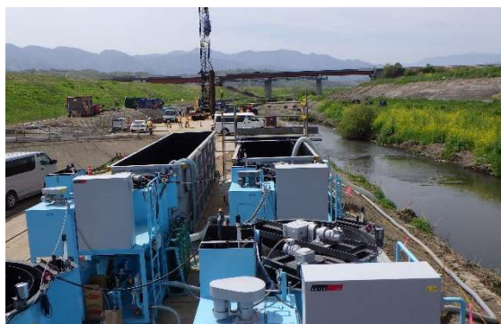
写真4-1-1-6 河川内排水時の適切な排水処理
