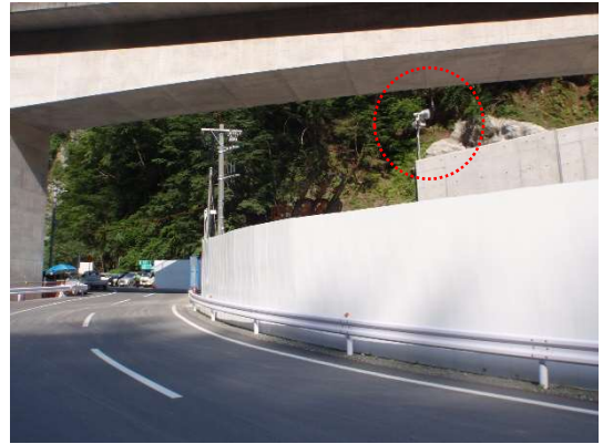
写真4-1-7-14(1) LED照明による照明の 漏れ出しの抑制
