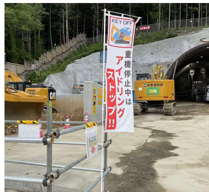
写真4-1-5-2 建設機械の使用時における配慮
