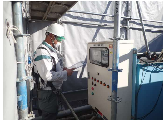
写真4-1-3-12 工事排水の監視、 機械の点検
