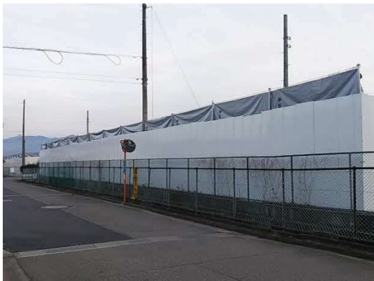
写真4-1-3-5 仮囲いの設置状況
