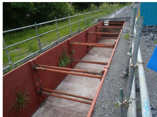
写真 4-1-9-6 沈砂池の設置状況 (塩島地区(河川側)発生土仮置き場)
