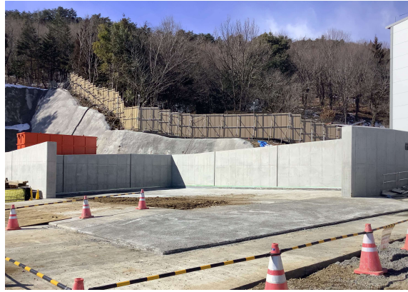
写真4-1-5-13 掘削土砂の適切な管理
