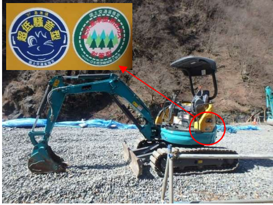
写真4-1-7-1 排出ガス対策型・低騒音型 建設機械の採用
