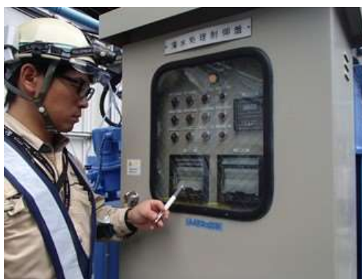
写真4-1-7-11 工事排水の監視 (濁水処理設備の監視・点検)
