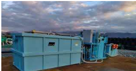
写真4-1-3-10 河川内工事の適切な排水処理
