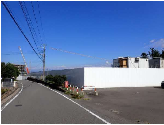
写真4-1-4-7 仮囲いの設置状況
