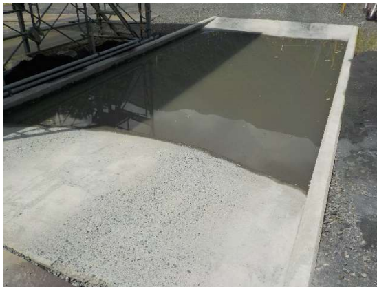
写真 4-1-10-5 外来種の拡大抑制のための タイヤ洗浄プール (塩島(下流)発生土仮置き場)
