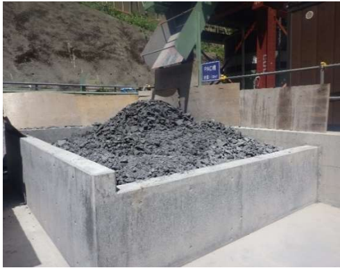
写真 4-1-8-20 建設汚泥の脱水処理 (早川非常口)
