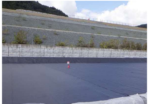
図 参 6-3-4 遮水シートの敷設状況 (西之宮地区(その2)発生土仮置き場)
