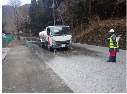
写真 4-1-8-8 道路への散水
