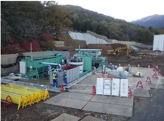
写真4-1-5-10 工事排水の適切な処理
