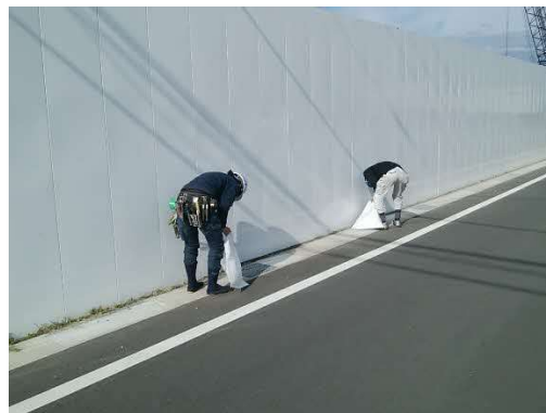
写真4-1-3-6 工事現場の清掃
