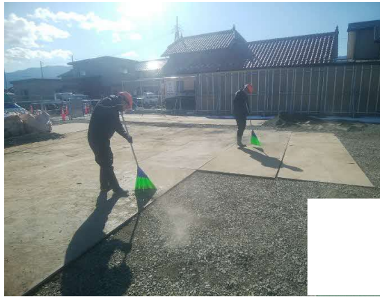
写真4-1-2-5 工事現場の清掃及び散水
