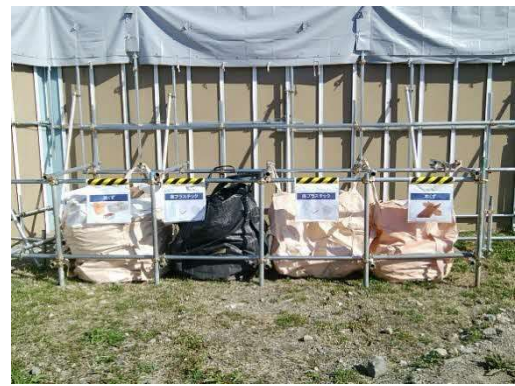
写真4-1-3-14 副産物の分別、 再資源化
