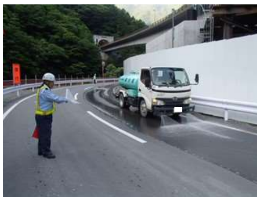
写真4-1-7-9 道路への散水
