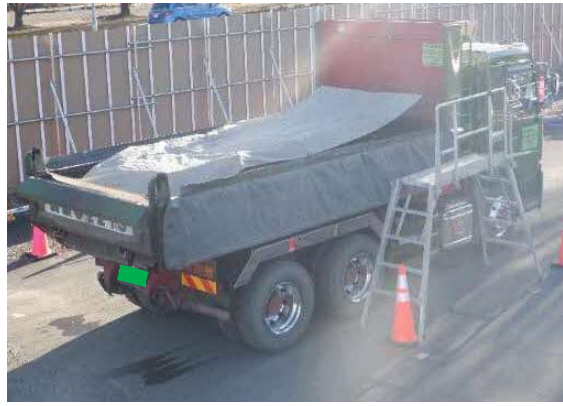
写真4-1-4-8 防じんシート設置
