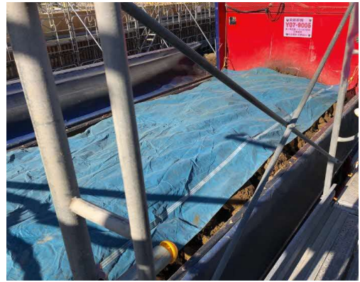
写真4-1-5-7 荷台への防じんシート敷設
