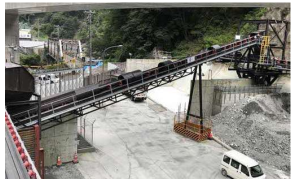
写真4-1-7-15 仮設物の色合いへの配慮 (ベルトコンベアー)
