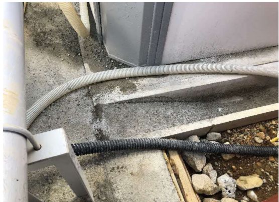
写真4-1-5-14 小動物が脱出可能な側溝の設置
