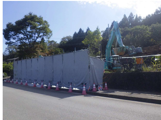
写真4-1-5-15 防音シート、低騒音機械の採用
