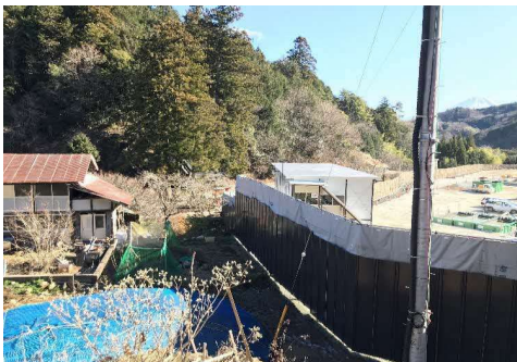
写真4-1-6-5 仮囲い・防音シート等の 設置による遮音対策
