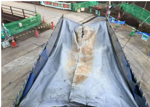
写真4-1-6-9 荷台への防じんシート敷設、対策土を含む発生土の適切な運搬
