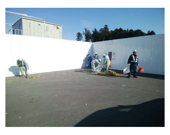
写真4-1-4-6 工事現場の清掃
