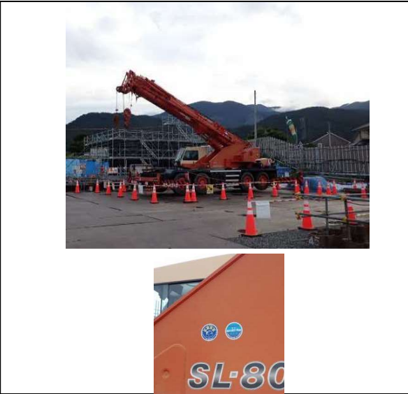
写真4-1-4-1 排出ガス対策型・低騒音型 建設機械の採用
