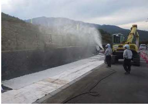
写真4-1-5-6 工事現場の清掃及び散水
