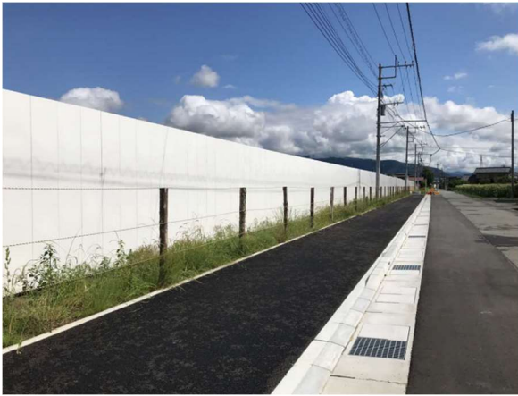
写真4-1-1-3 仮囲いの設置
