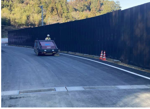
写真4-1-6-7 工事現場の清掃
