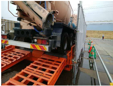
写真4-1-3-8 (2) タイヤ洗浄 (湿式スパッツ)
