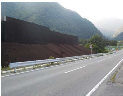
写真 4-1-9-5 仮囲いの設置状況 (塩島地区発生土置き場)
