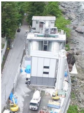
写真 4-1-8-11(1) バッチャープラント建屋設置状況 (早川非常口)
