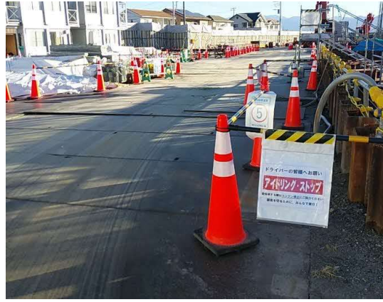
写真4-1-3-2 建設機械の使用時における配慮
