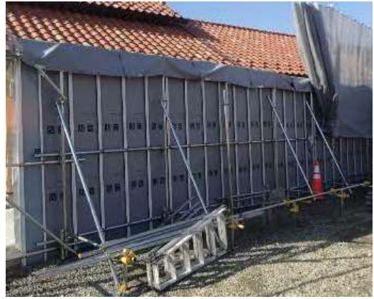
写真4-1-2-4 仮囲い・防音シート等の設置による遮音対策
