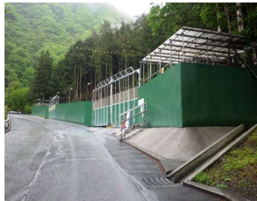
写真 4-1-8-15 侵入防止柵（仮囲い）の 設置状況 (広河原非常口)
