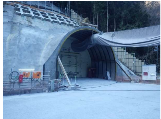
写真 4-1-8-10 防音扉の設置状況 (広河原非常口)
