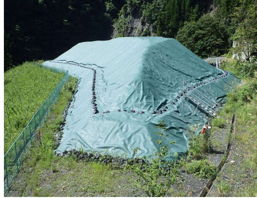
写真 4-1-10-8 遮水シートの設置状況 (雨畑発生土仮置き場)
