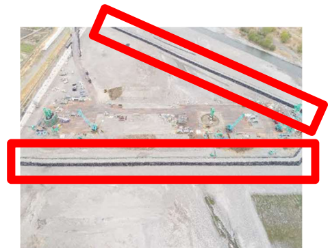
写真4-1-3-11 仮締切工の実施 (1)
