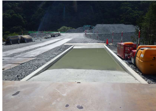
写真 4-1-9-4 外来種の拡大抑制のための タイヤ洗浄プール (塩島地区(河川側)発生土仮置き場)
