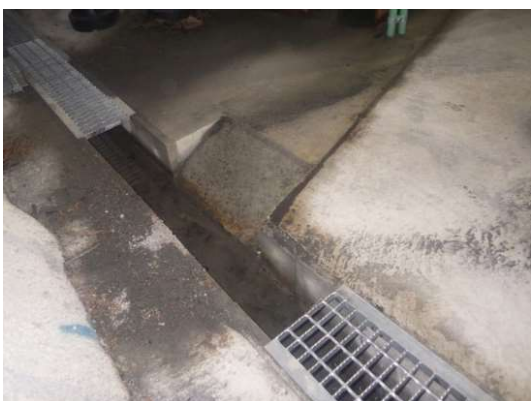
写真 4-1-8-14 土砂ピットにおける 掘削土砂管理 (底盤及び周囲のコンクリート打設) (早川非常口)
