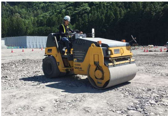
図 参 6-3-5 締固め状況 (中洲地区発生土仮置き場)
