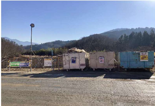
写真 4-1-6-17 副産物の分別、再資源化
