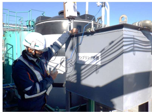
写真4-1-5-11 工事排水の監視
