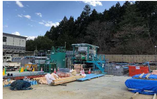
写真4-1-5-17 汚濁処理施設の設置
