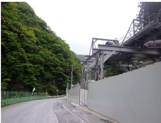
写真 4-1-8-5 仮囲いの設置状況 (早川非常口)
