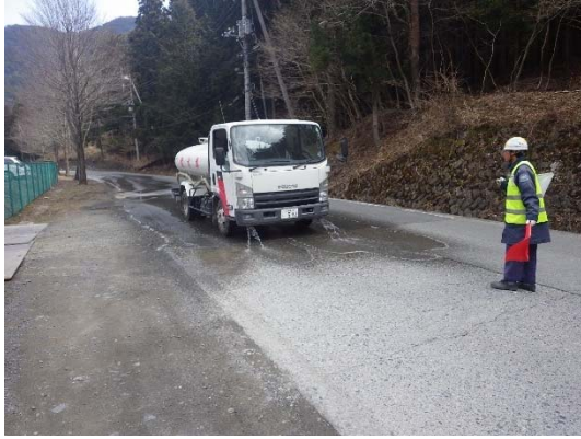
写真4-1-2-7 道路への散水
