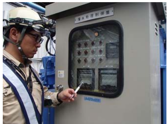
写真4-1-1-10 工事排水の監視 (濁水処理設備の監視・点検)
