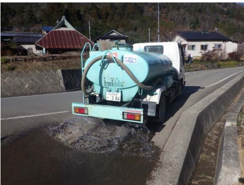
写真4-1-5-5 工事施工ヤード・運搬経路の 散水実施
