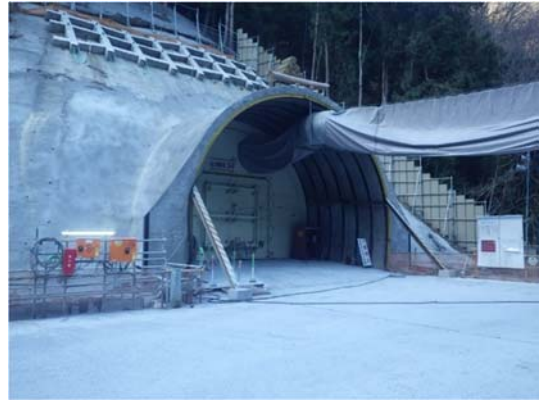
写真4-1-2-16 防音扉の設置 (広河原非常口)
