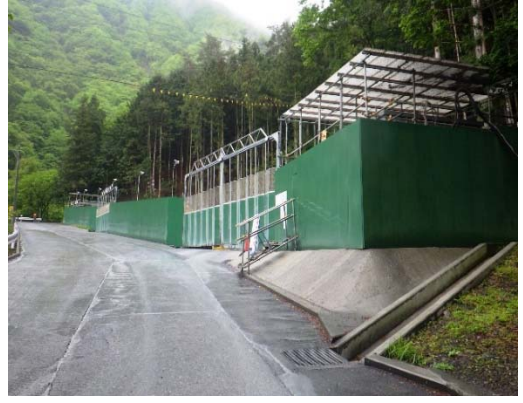
写真4-1-2-14 侵入防止柵の設置 (広河原非常口)
