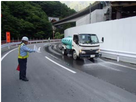
写真4-1-1-7 道路への散水
