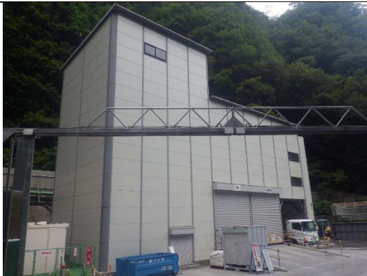
写真4-1-2-21 (2) バッチャープラント建屋設置 (広河原非常口)
