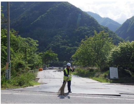
写真4-1-3-3 清掃実施状況 (塩島地区発生土置き場)
