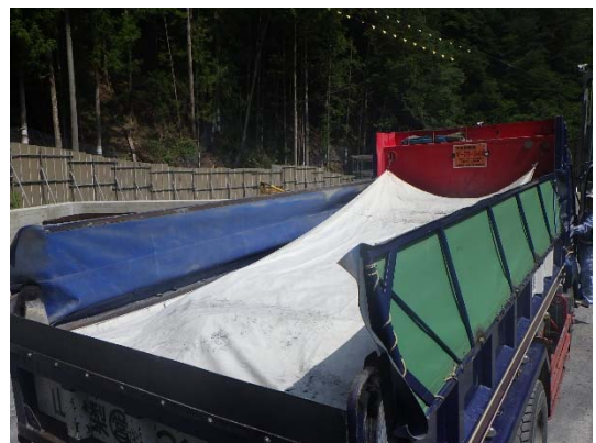
写真4-1-4-6 運搬時の浸透防止シート 設置状況
