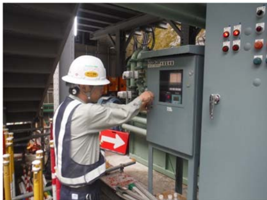
写真4-1-2-11 工事排水の監視 (濁水処理設備の監視・点検)
