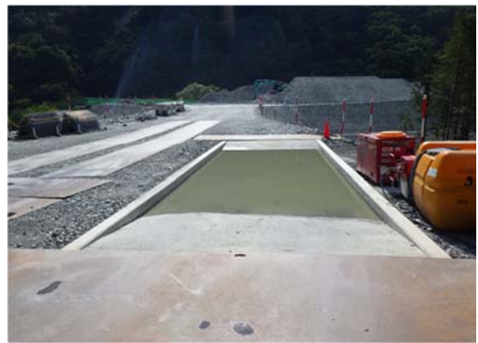
写真4-1-3-4 タイヤ洗浄プール (塩島地区(河川側)発生土仮置き場)
