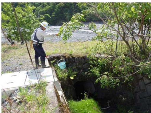
写真4-1-3-7 工事排水の監視 (塩島地区発生土置き場)
