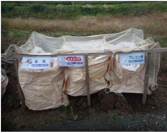
写真4-1-5-7 副産物の分別・再資源化
