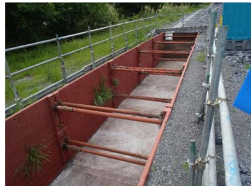
写真4-1-3-6 沈砂池の設置 (塩島地区(河川側)発生土仮置き場)
