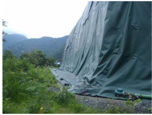
写真4-1-4-8 遮水シート (塩島下流発生土仮置き場)
