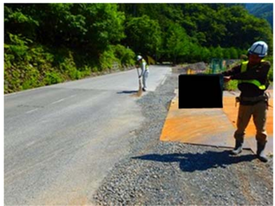
写真4-1-4-4 清掃実施状況 (塩島地区(南)発生土仮置き場)
