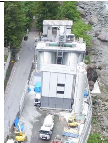
写真4-1-2-21 (1) バッチャープラント建屋設置 (早川非常口)
