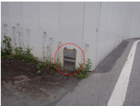
写真4-1-1-12(3) 小動物が脱出可能な 仮囲い
