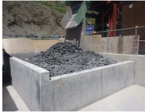
写真4-1-2-19 建設汚泥の脱水処理 (早川非常口)
