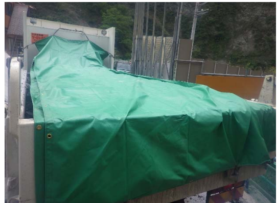
写真4-1-2-12 運搬時の浸透防止シート 設置状況
