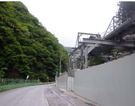
写真4-1-2-5 仮囲いの設置 (早川非常口)
