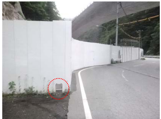
写真4-1-1-12(2) 小動物が脱出可能な 仮囲い
