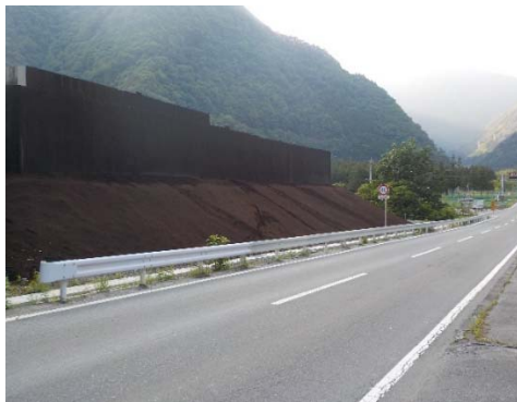
写真4-1-3-5 仮囲い設置 (塩島地区発生土置き場)
