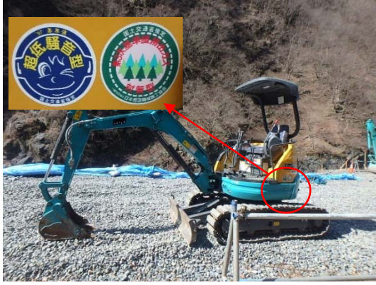
写真4-1-1-1 排出ガス対策型・低騒音型 建設機械の採用
