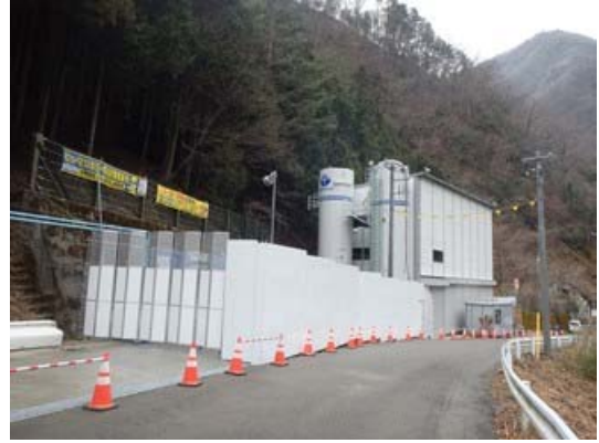
写真4-1-1-6(2) 仮囲い、バッチャープラント建屋設置
