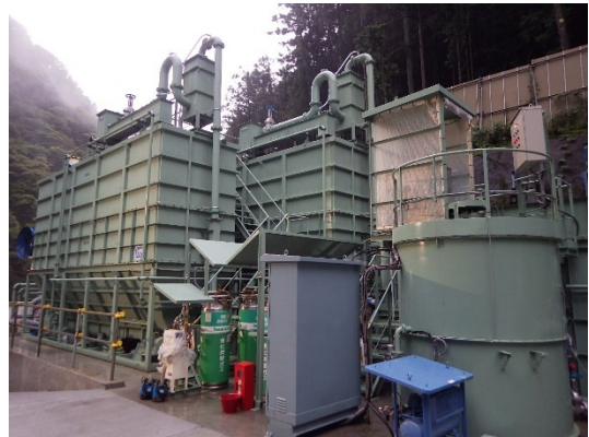
写真 4-1-2-10 濁水処理設備 (早川非常口)
