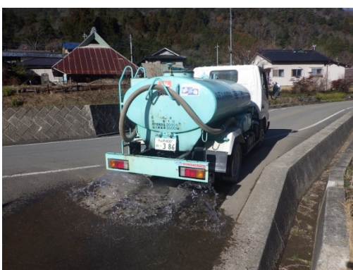
写真 4-1-5-5 工事施工ヤード・運搬経路の 散水実施
