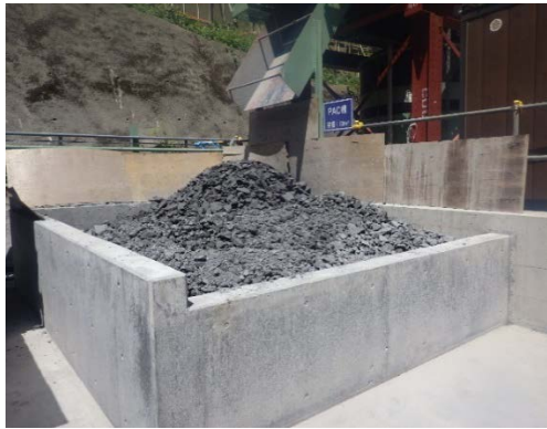
写真 4-1-2-19 建設汚泥の脱水処理 (早川非常口)
