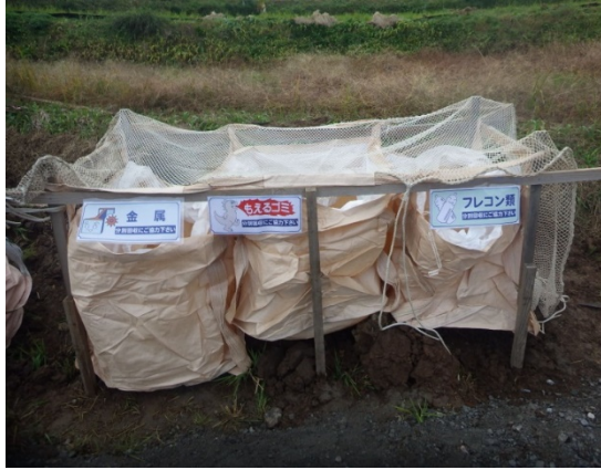
写真 4-1-5-7 副産物の分別・再資源化
