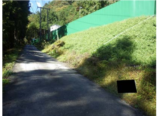
写真 4-1-2-18 のり面の緑化 (広河原非常口)
