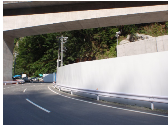
写真 4-1-1-13(1) LED 照明（点灯前）
