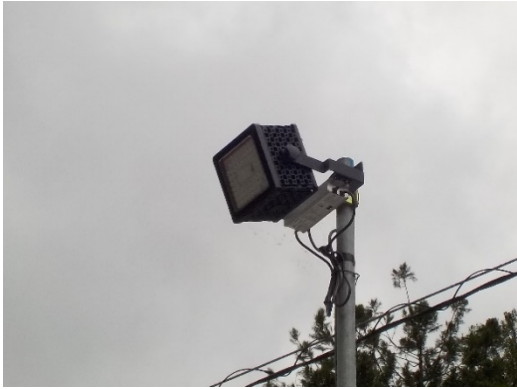
写真 4-1-2-17(3) LED 照明 (早川非常口)
