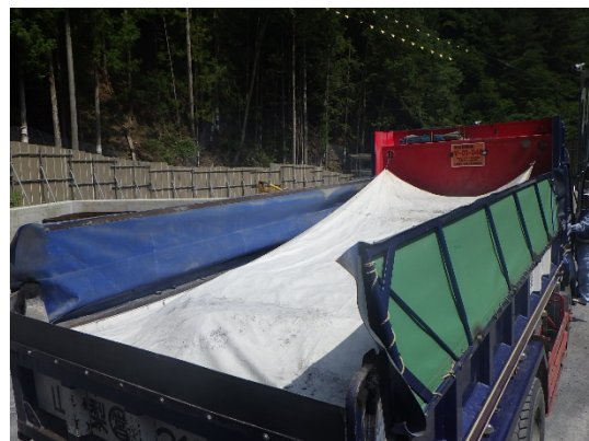
写真 4-1-4-6 運搬時の浸透防止シート設置状 況
