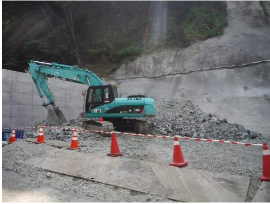
写真 4-1-1-11 土砂ピットにおける掘削土砂の管理（底盤及び周囲のコンクリート打設）
