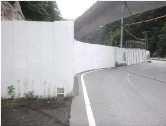
写真 4-1-1-12(2) 小動物が脱出可能な仮囲い
