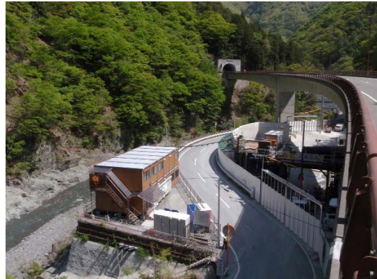
写真 4-1-1-5(2) 工事現場の清掃（清掃後）
