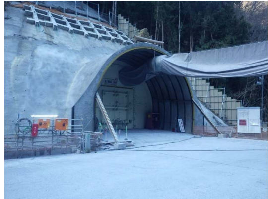
写真 4-1-2-16 防音扉の設置（広河原非常口）
