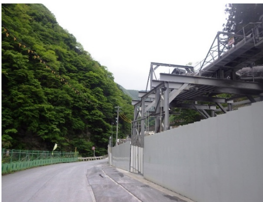
写真 4-1-2-5 仮囲いの設置 (早川非常口)
