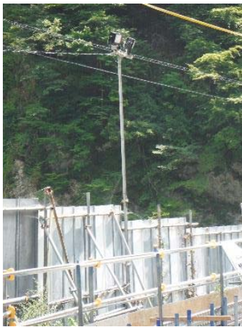
写真 4-1-2-17(1) LED 照明（点灯前）（早川非常口）
