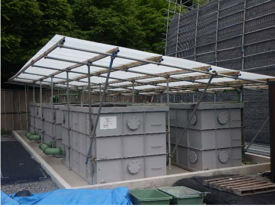
写真 4-1-4-7 浸潤水用水槽 (塩島(下流)発生土仮置き場)
