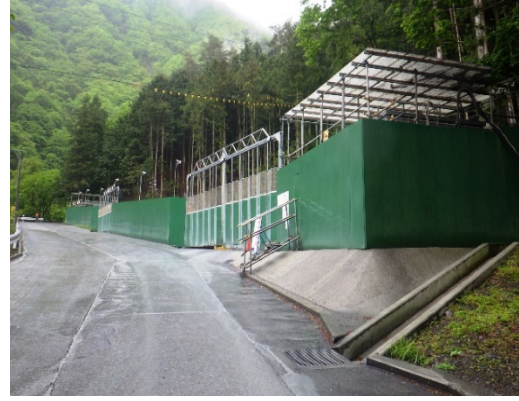
写真 4-1-2-14 侵入防止柵の設置（広河原非常口）
