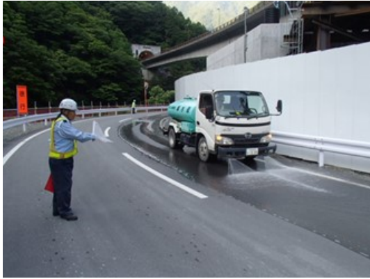
写真 4-1-1-7 道路への散水
