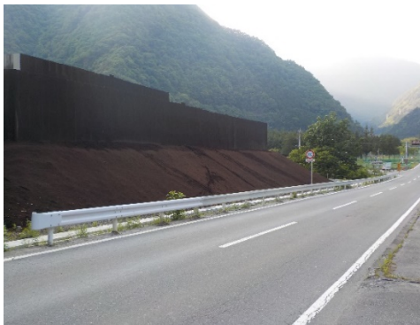
写真 4-1-3-5 仮囲い設置 (塩島地区発生土置き場)
