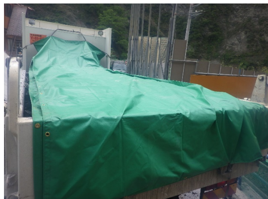
写真 4-1-2-12 運搬時の浸透防止シート設置 状況
