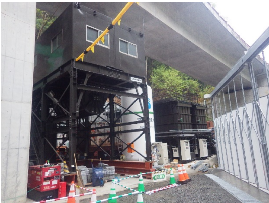
写真 4-1-1-9 濁水処理設備
