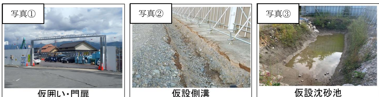
図 2-2 工事施工ヤード整備の計画
