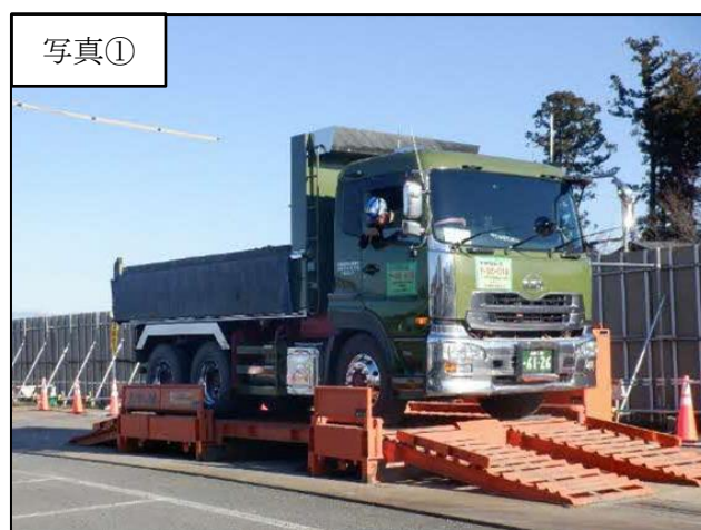
※写真①は中央新幹線山梨県内高架橋ほか新設工事（利根川公園交差点）での事例を示す。
