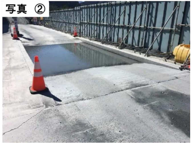
タイヤ洗浄設備の設置
