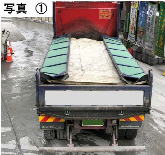
荷台への防じんシート等の設置
