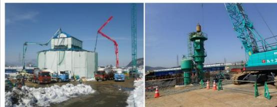
図 2-27 (1) 下部工（ニューマチックケーソン基礎形式）の施工手順
