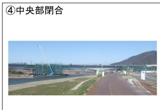
※施工手順②、③を繰り返し行い、中央部まで上部工を構築していく。
