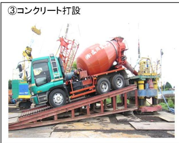
図 2-25 (1) 下部工（場所打ち杭基礎形式）の施工手順
