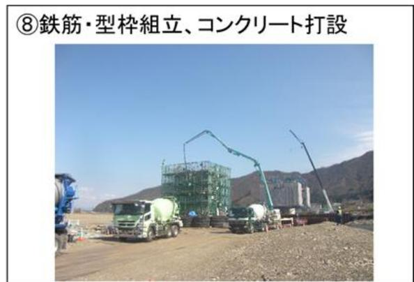
図 2-27 (2) 下部工 (ニューマチックケーソン基礎形式) の施工手順
