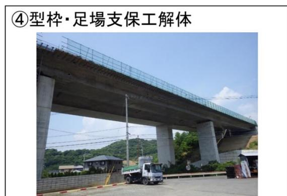
図 2-29 上部工（固定式支保工法）の施工手順
