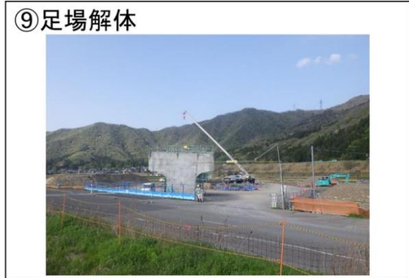
図 2-27 (3) 下部工（ニューマチックケーソン基礎形式）の施工手順
