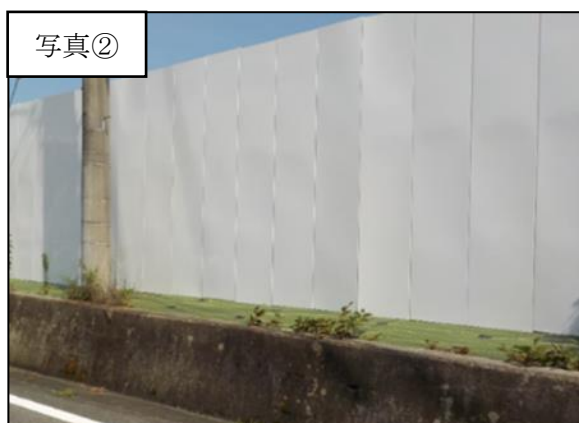
写真② 仮囲いの設置
