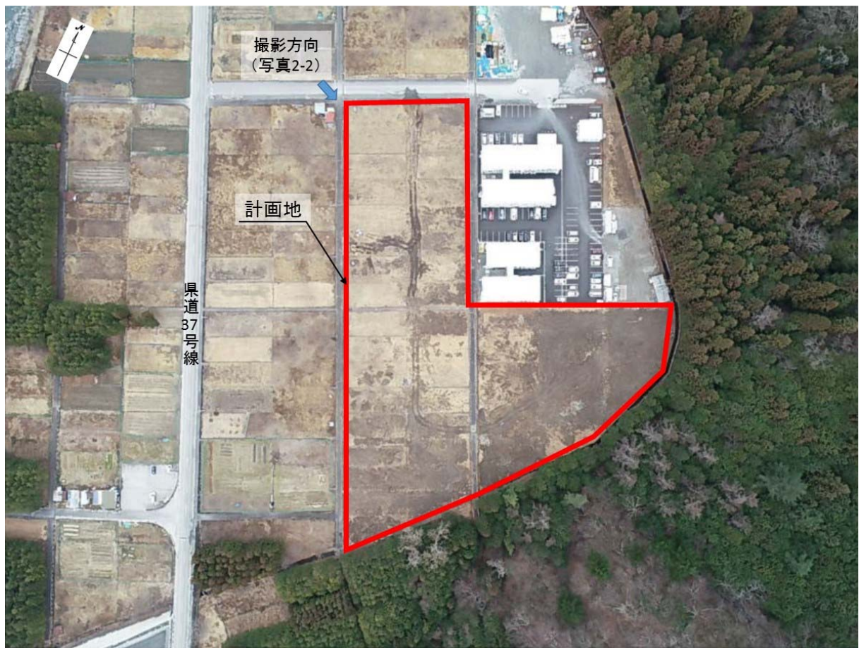
写真 2-1 中洲地区発生土仮置き場計画地の現況 (遠景)
