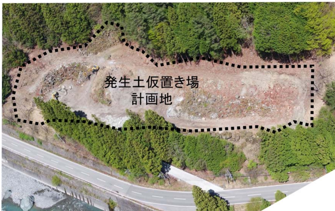
写真 2-1 湯島地区（田島）発生土仮置き場計画地（現況）
