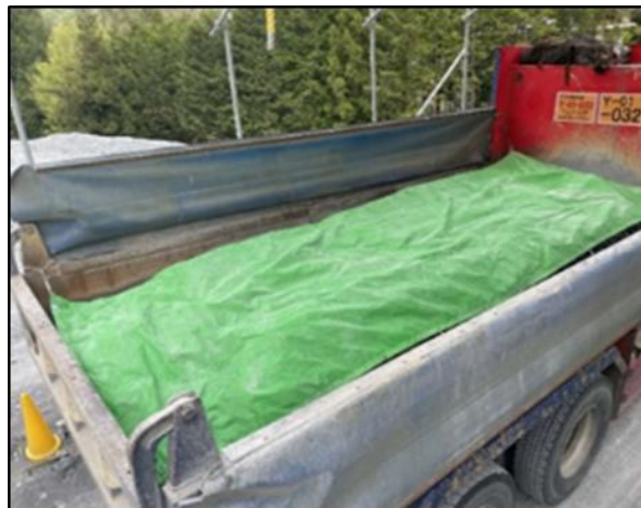
防じんシートの敷設
