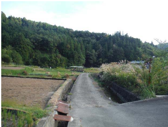
写真 2-1 工事用道路整備計画地①
