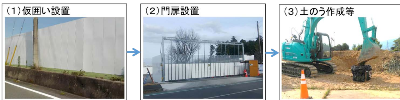
図 2-3 P1 橋脚工事施工ヤード（旧中道北小学校跡地）施工手順
