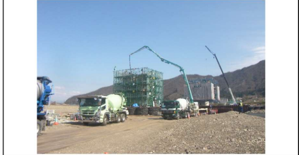
⑩躯体・脚頭部鉄筋・型枠組立、 コンクリート打設
