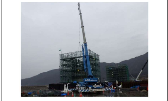
⑨足場設置(躯体・脚頭部)
