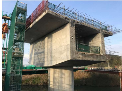
図 2-19 (1) 上部工（張出架設工法）の施工手順
