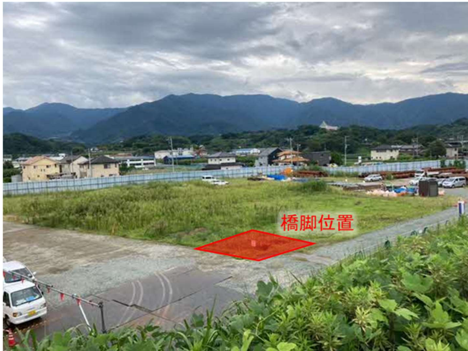
写真 2-1 A 区間工事着手前の状況
