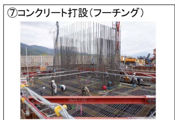
図 2-13 (2) 下部工 (場所打ち杭工法) の施工手順
