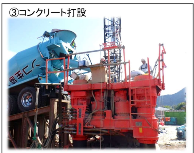
図 2-13 (1) 下部工（場所打ち杭工法）の施工手順
