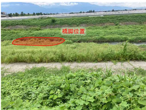
写真 2-2 B 区間工事着手前の状況
