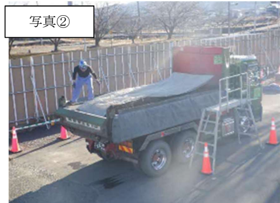
防じんシートの敷設
