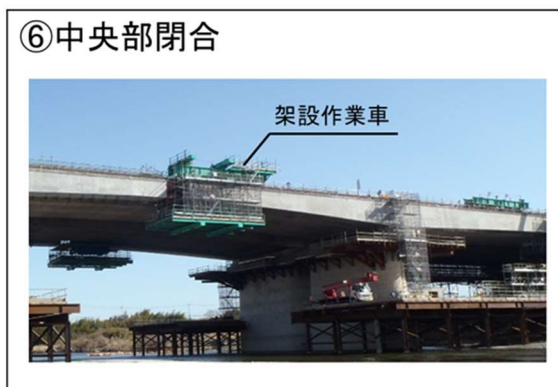
図 2-19 (2) 上部工（張出架設工法）の施工手順
