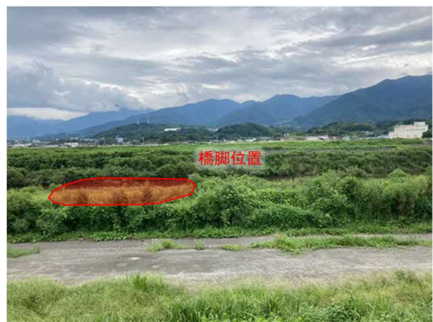
写真 2-3 B 区間工事着手前の状況
