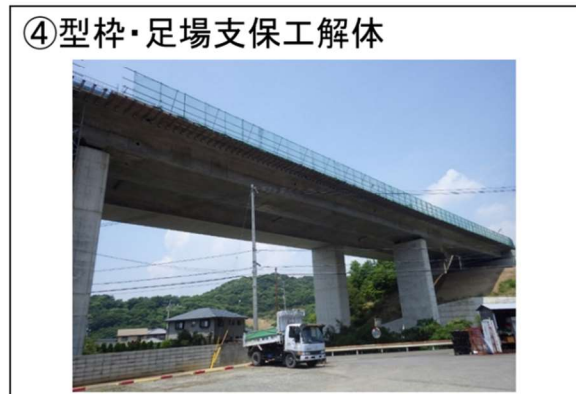
図 2-17 上部工（固定式支保工架設工法）の施工手順
