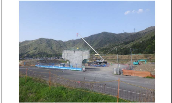
図 2-15 (3) 下部工 (ニューマチックケーソン工法) の施工手順
