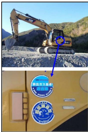
写真① 低騒音・排出ガス 対策型建設機械の使用
