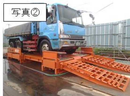
タイヤ洗浄設備の設置
