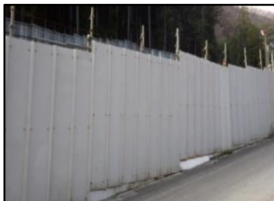
写真② 仮囲いの設置
