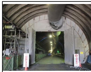
写真③ 防音扉の設置
