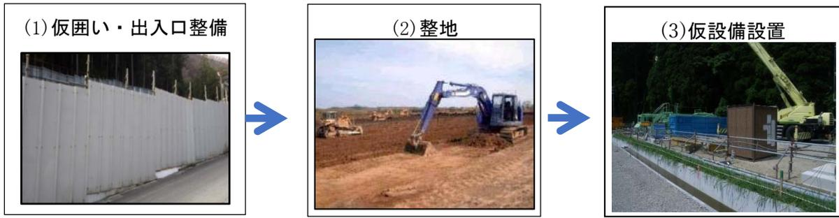
図 2-4 工事施工ヤード整備の施工手順（写真は類似工事の例）
