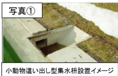
写真① 小動物脱出用側溝
