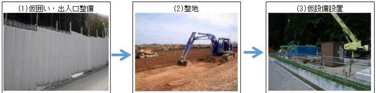
図 2-16 千本ヤード施工手順（写真は類似工事の例を示す）
