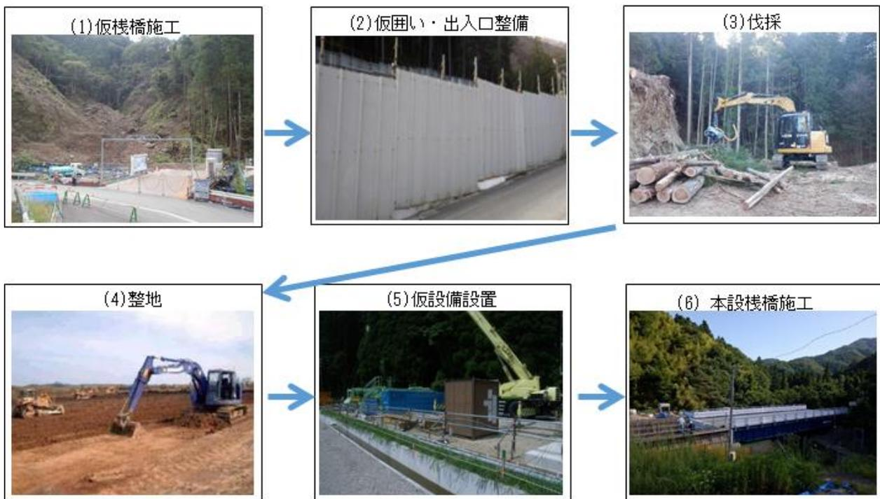
図 2-11 小室非常口ヤード施工手順（写真は類似工事の例を示す）
