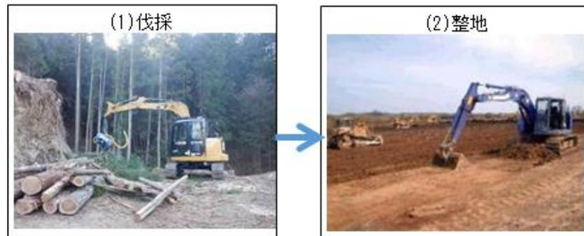
図 2-23 坑口部施工手順（写真は類似工事の例を示す）
