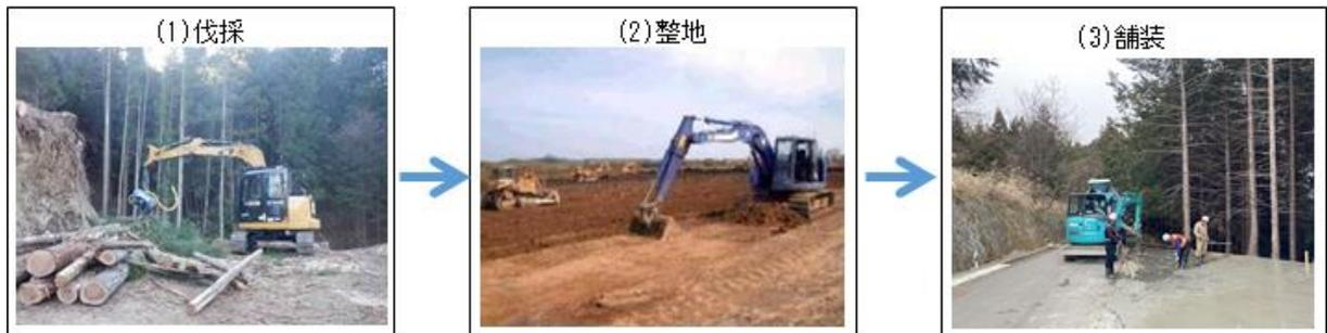
図 2-20 農道整備施工手順（写真は類似工事の例を示す）
