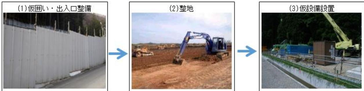
図 2-8 畔沢川橋りょうヤード施工手順（写真は類似工事の例を示す）
