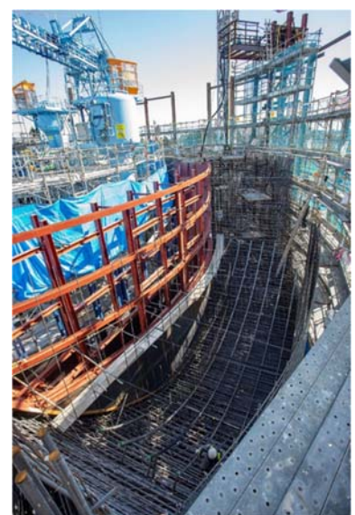
写真 3-4-8(2) 鉄筋組立の状況 (令和 3 年 3 月時点)
