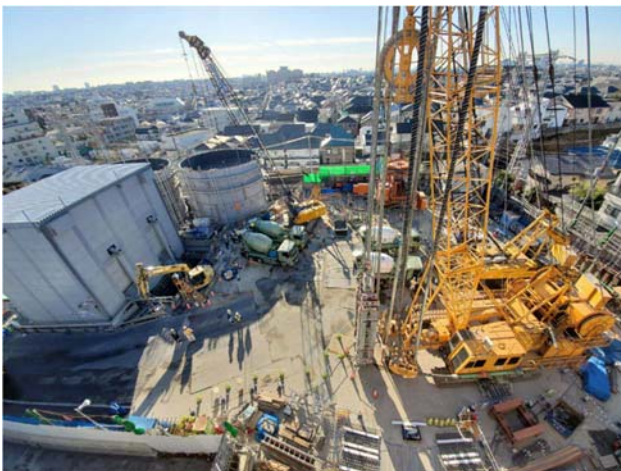
写真 3-4-5(1) コンクリート打設状況 (令和 2 年 12 月時点)
