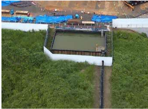
写真-1-3 工事排水の処理状況（地点 06）
