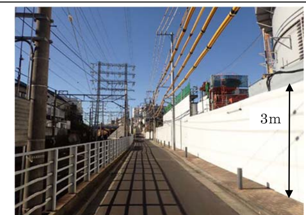
写真-2-2 仮囲いの設置状況 (地点 03)
