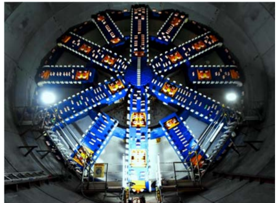
写真 3-4-3(2) 耐圧円筒内に据え付けられた シールド機の状況 (令和 3 年 3 月時点)
