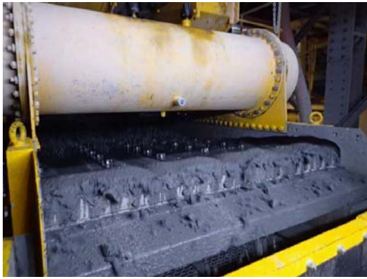
写真-1 建設汚泥の脱水処理の状況 (地点 03)
