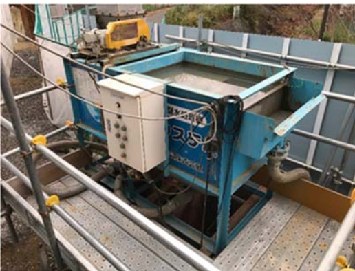
写真-1-3 工事排水の適切な処理状況 (地点 05)
