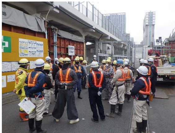
写真-4-1 工事従事者への講習・指導状況 (地点 01)
