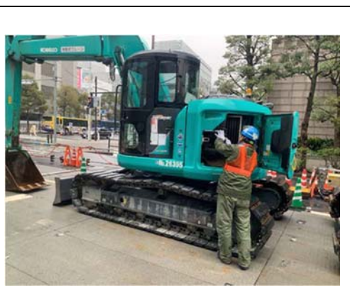
写真-2-1 建設機械の点検及び整備による性能維持（地点 01）
