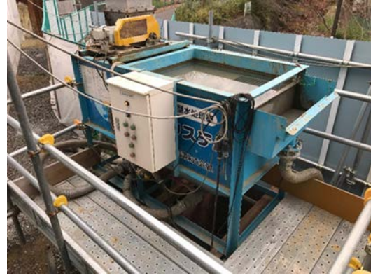
写真-1-2 工事排水の処理状況（地点 05）
