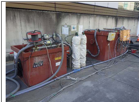
写真-1-1 工事排水の処理状況 (地点 01)
