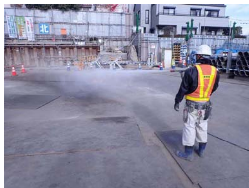
写真-6-2 車両の出入り口、周辺道路の清掃の状況（地点03）
