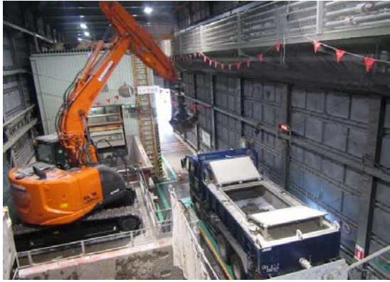
写真-1 建設汚泥の脱水処理の状況 (地点 01)
