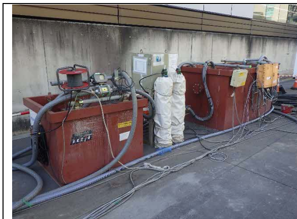
写真-1-1 工事排水の処理状況 (地点 01)
