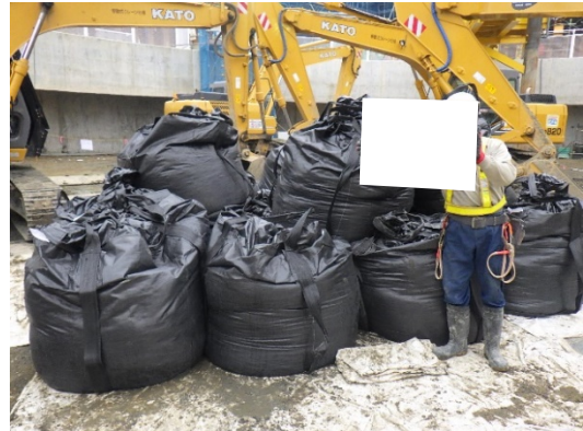
写真-3 発生土の仮置き状況（地点 02）
