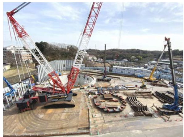
写真 3-4-7(2) 発進のための設備設置状況 （令和3年3月時点）
