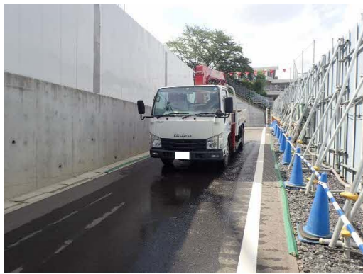
写真-10 タイヤの洗浄の状況（地点 05）
