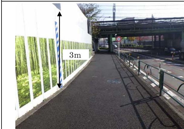
写真-2-1 仮囲いの設置状況 (地点 02)
