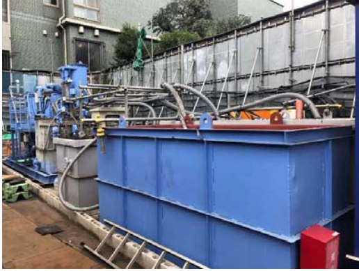
写真-1-1 工事排水の適切な処理状況 (地点 02)
