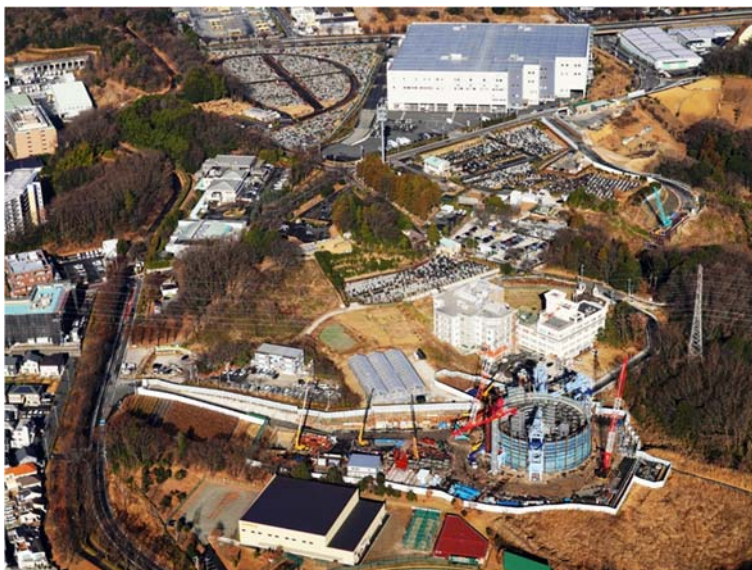
写真 3-4-8(1) ニューマチックケーソン工の施工状況 (令和 3 年 3 月時点)
