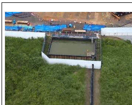
写真-7 仮設沈砂池の設置（地点 06）
