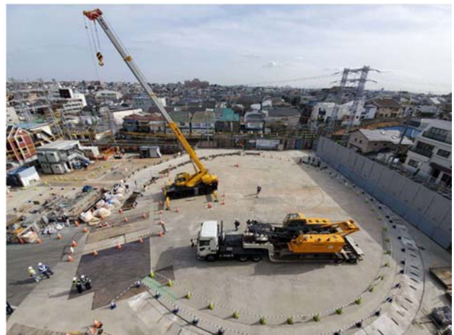
写真 3-4-5(2) 地中連続壁の施工状況 (令和 3 年 3 月時点)
