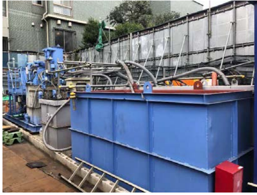
写真-1-1 工事排水の処理状況（地点 02）
