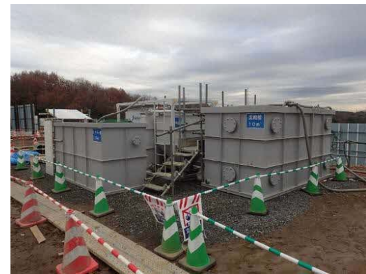
写真-1-4 工事排水の適切な処理状況 (地点 06)
