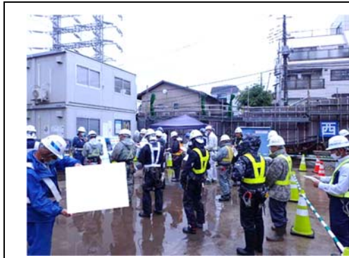
写真-3-2 工事従事者への講習・指導の状況（地点03）
