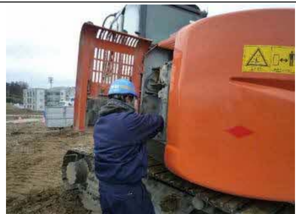
写真-3-2 建設機械の点検及び整備による 性能維持状況 (地点 06)
