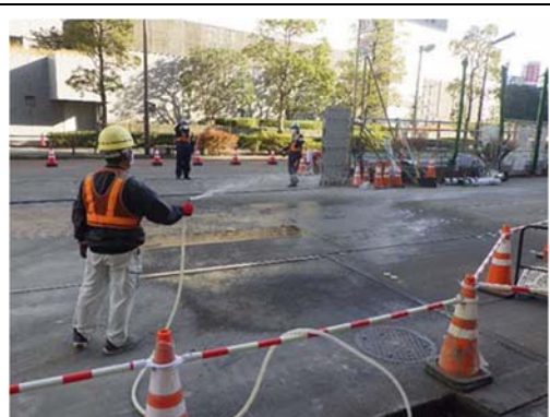
写真-6-1 車両の出入り口、周辺道路の清掃の状況（地点01）
