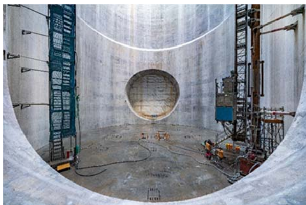
写真 3-4-2(1) 坑口から見た完成状況 (令和元年 12 月時点)
