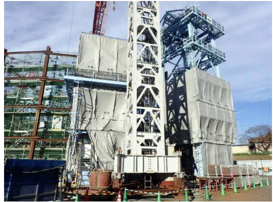
写真-4 防音シートの設置（地点 02）
