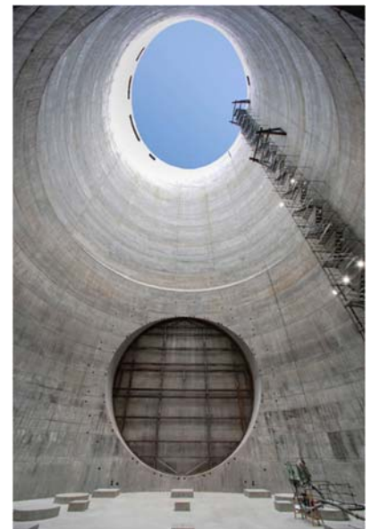
写真 3-4-6(2) 底板から見た完成状況 (令和 2 年 12 月時点)
