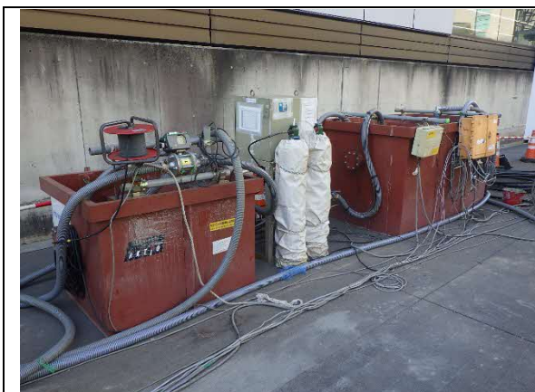
写真-1-1 工事排水の処理状況（地点 01）
