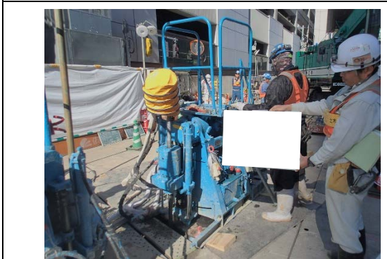
写真-3 薬液注入工の状況（地点 01）
