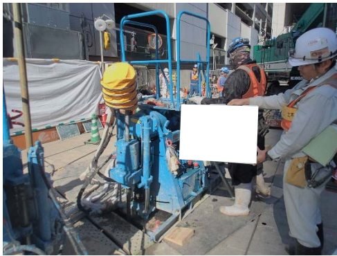
写真-2 薬液注入工の状況（地点 01）
