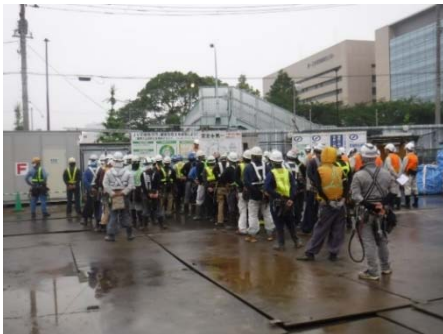
写真-4-1 工事従事者への講習・指導の状況 (地点 02)
