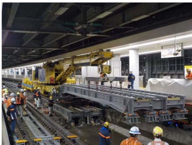
写真 3-4-1 (1) 工事桁架設の施工状況 (令和3年3月時点)
