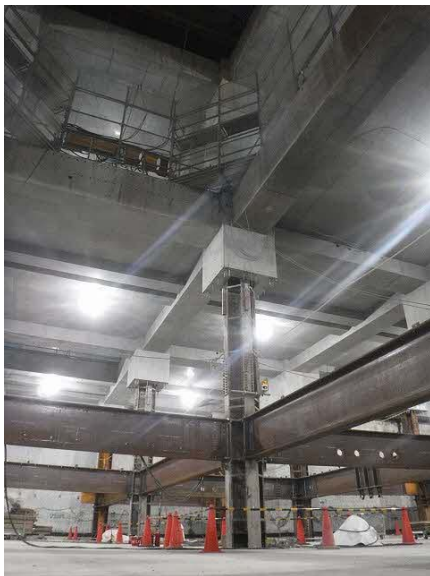
写真 3-4-4(1) 掘削・躯体構築状況 (令和 2 年 12 月時点)
