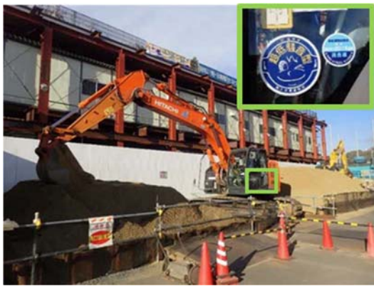
写真-5 低騒音型建設機械の採用（地点 02）
