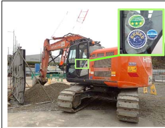
写真-8-2 低騒音・低振動型の建設機械の採用（地点 05）
