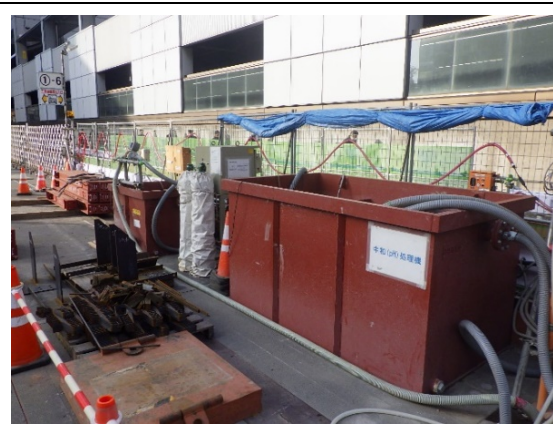
写真-2-1 工事排水の適切な処理状況（地点 01）
