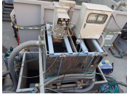
写真-1-2 工事排水の適切な処理状況 (地点 03)
