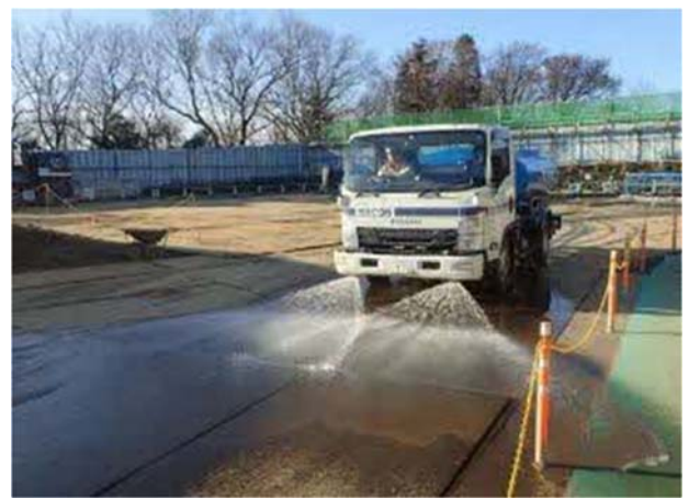
写真-1-2 工事現場の清掃、散水の状況 (地点 06)
