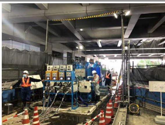
写真-1 薬液注入工法における指針の順守の状況（地点 01）
